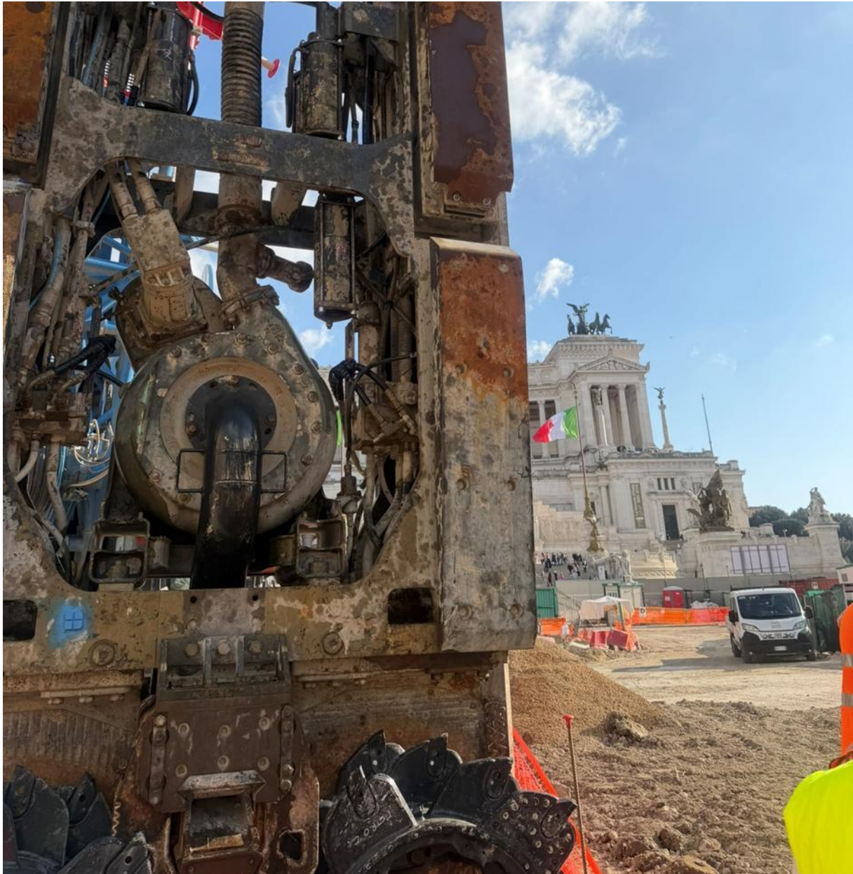
En stor tung «slissemaskin/hydromill» er et viktig redskap for å grave ut en metrostasjon på Piazza Venezia, i bakgrunnen ligger Palazzo Venezia (Foto: NFF)
