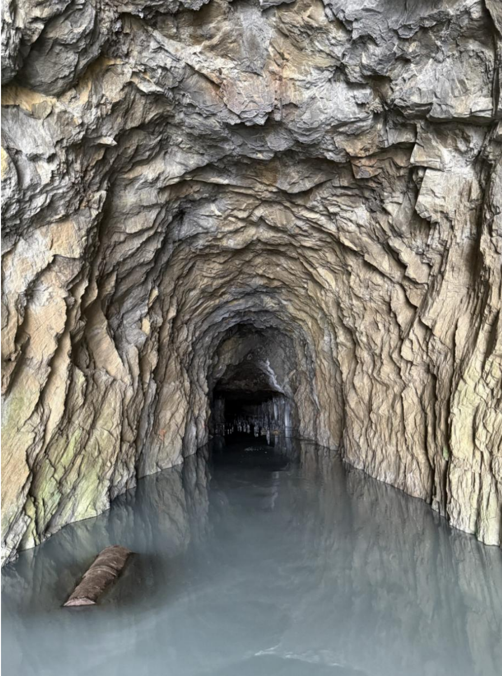
Figur 1: Starten av Polarbanetunnelen, med islagt såle. Foto: Øystein Fure.
