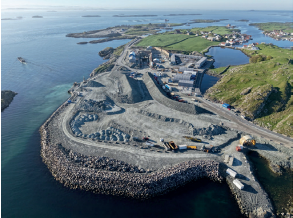
Figur 5 Riggområdet på Krossøy med stor sjøfylling og påhugg for Kvitsøytunnelen.
