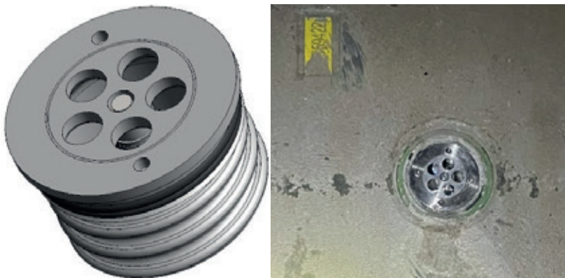
Figur 7. Ventilløkk. Skisse til venstre, montert i tunnelen til høyre.
