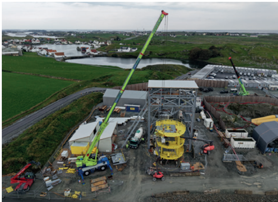
Figur 14: bilde av arbeidsplattformen før den senkes ned i sjakten.
