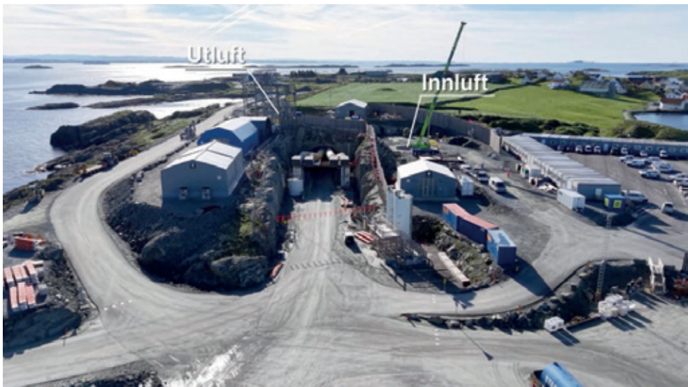
Figur 6 Området ved påhugg til Kvitsøytunnel med sjakter på begge sider av tunnelen (innluft, utluft).
