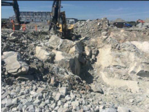
Bilde 2 - Det av store høydeforskjeller på sprengt flate. Foto: Morten Lorentzen
