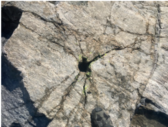
Bilde 12 - Hull med sprekkesone kontrollert for gjennstående sprengstoff
