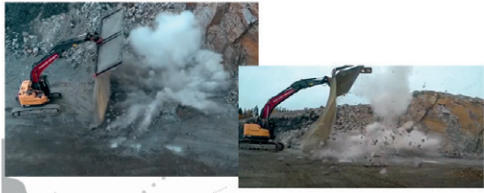
Bilde 14 - Testing av sikkerhetsbarriere i Vestby pukkverk. Foto: AF gruppen
