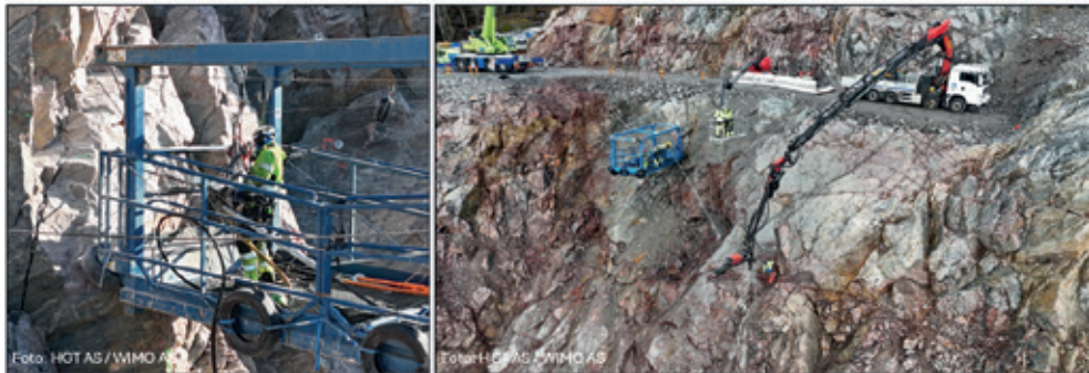
Figur 8: Bilder fra sikringsarbeidet. Venstre: Knemater påmontert personkurv for mobilitet i skjæringen. Høyre: Parallell sikringsoperasjoner i tildelte sektorer.
