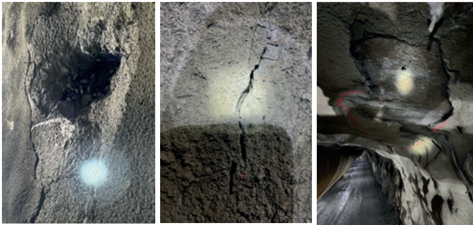
Figur 12 Sprøytebetong utført i 2024/2025
