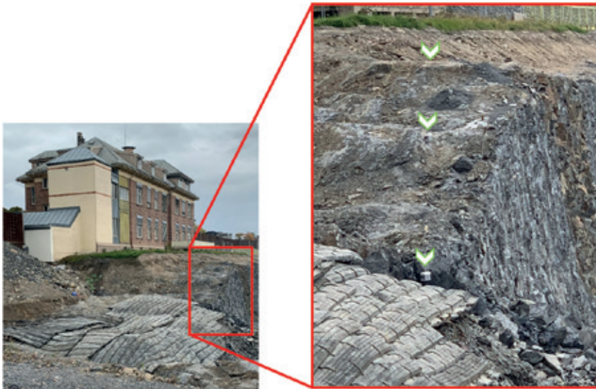
Figur 5: Oppsett for sprengning og rystelsesmålere på 5, 10 og 15 m avstand (Mofoss, 2025).
