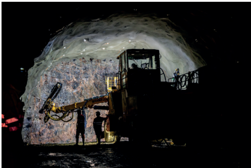
AMV Tunnelrigg – E10 Hålogandsveien Skanska (Bilde: AMV)
