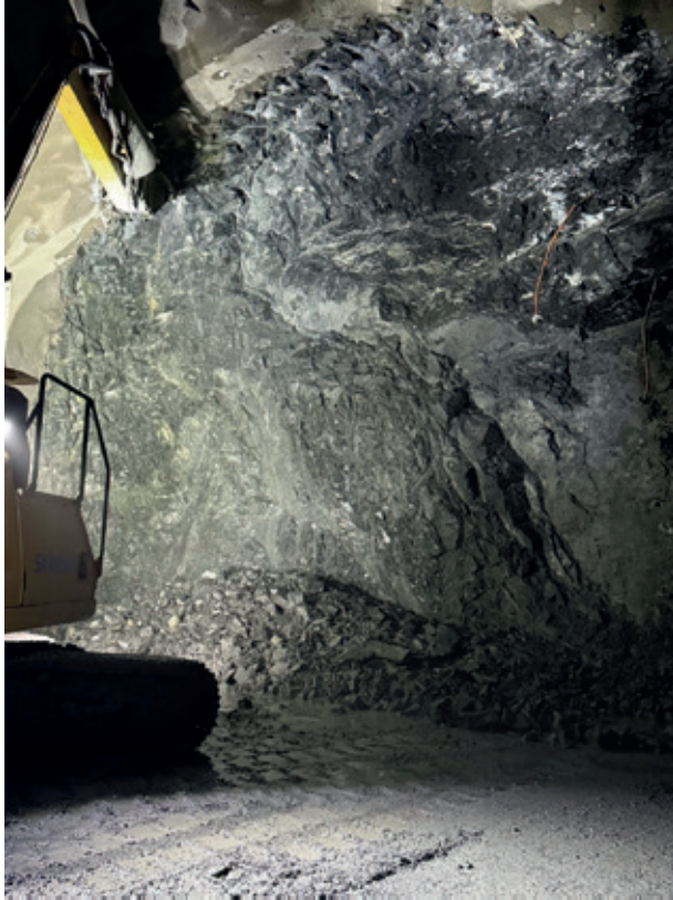
Figur 9 Fra driving under dyprennen på Strand. Bildet er tatt ved ca. profil 7719, hvor det var lavest bergoverdekning på ca. 2,1 m. Tunnelspennet er her 18 m.
