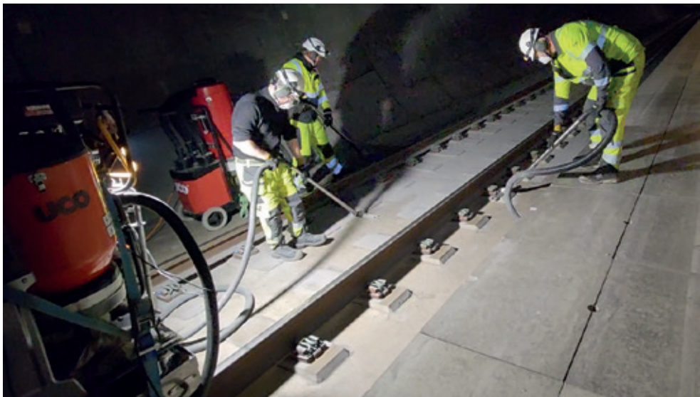
Figur 11: Støvsugning av Blixtunnelen.
