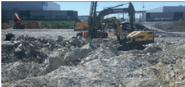
Bilde 1 - Slik så bergoverflaten ut etter tidligere sprengning. Foto: Morten Lorentzen
