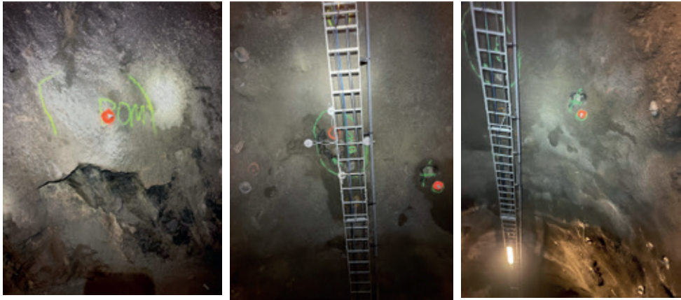
Figur 7 Monterte bombolter, bergbånd og erstatningsbolter
