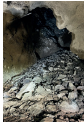
Figur 6 - Stuff etter utrasing har påbegynt (Foto: LNS)
