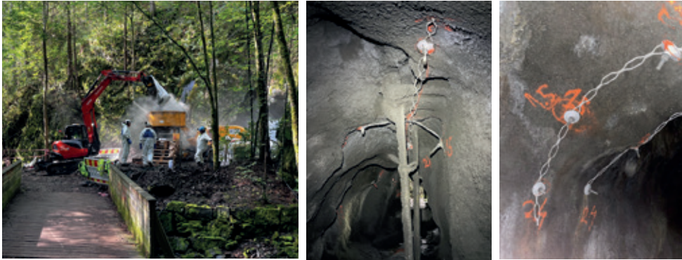
Figur 3 blanding av fiberarmert sprøytebetong på stedet. innsprøytet lem støttet opp med stillasben og bergbånd
