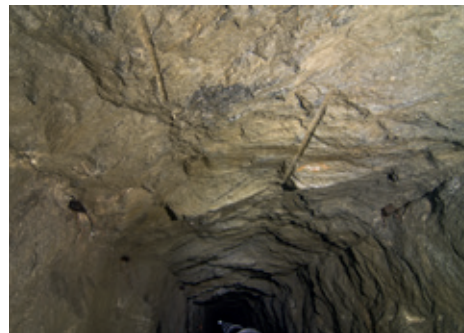
Figur 9 Tunnel fra 1959 i gneis. Utmerket stabilitet 65 år senere
