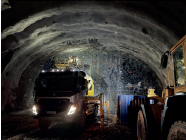
Figur 13 Fra injeksjon under dyprennen på Strand. Bildet er tatt med stoff på ca. profil 7721, hvor det var det var injeksjon av stag med RBA380.
