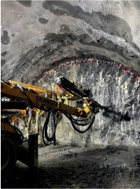
Figur 3 Montering av rør og kjemisk injeksjon
