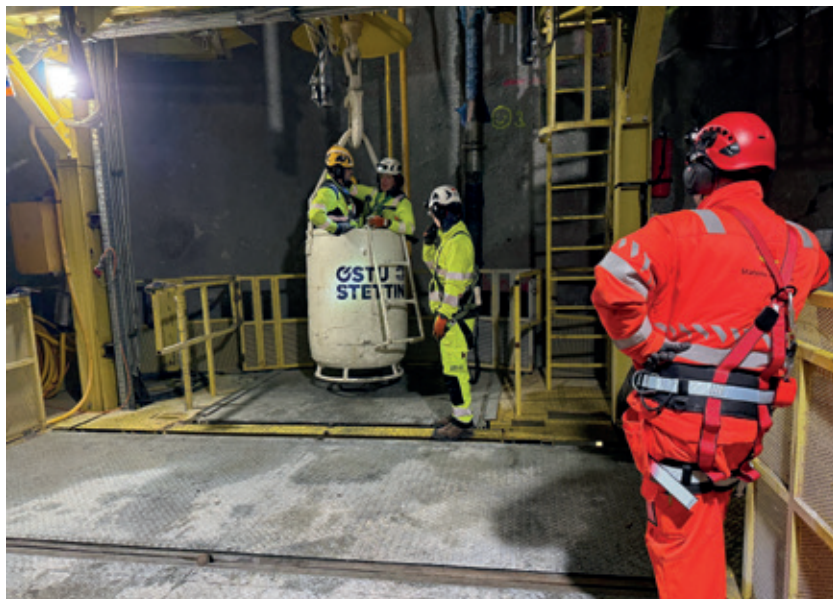
Figur 25 inne i arbeidsplattformen.
