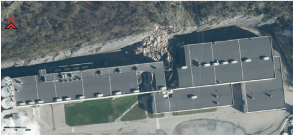
Figur 1: Flyfoto som viser oversiktsbilde av skredet og PM6-bygget med store ødeleggelser. Bildet er fra våren 2023. Kilde: www.norgebilder.no
