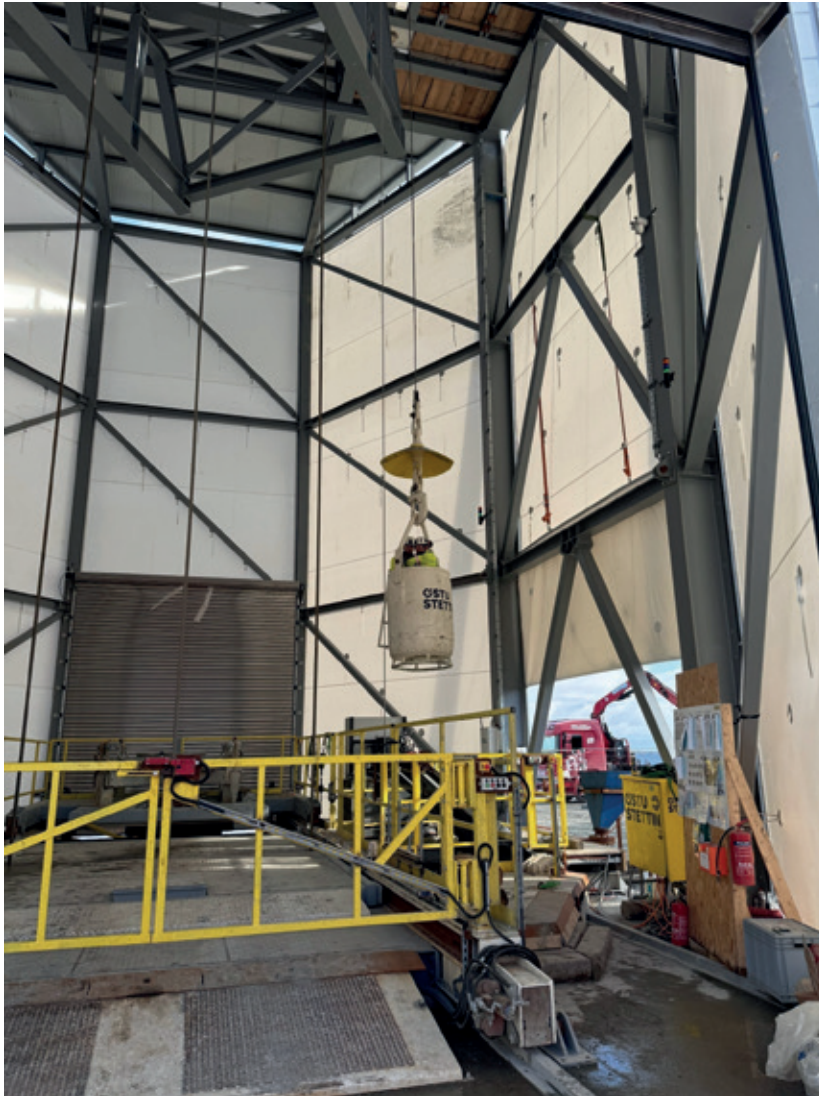
Figur 17 Sjakttårn vist fra innsiden med to personer i korg på tur opp/ned av sjakt. Nederst i bildet ses den gode tettingen av topp sjakt med luker.
