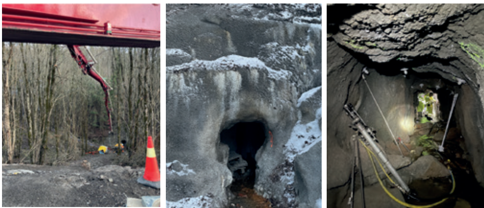
Figur 5 fiberarmert sprøytebetong måtte pumpes ned til portal og håndsprøytes. Ferdig innsprutet portalåpning. Ferdig innsprutet tunnel med bergbolter. knemateren som brukes til boring for bolt kan sees i høyre bilde
