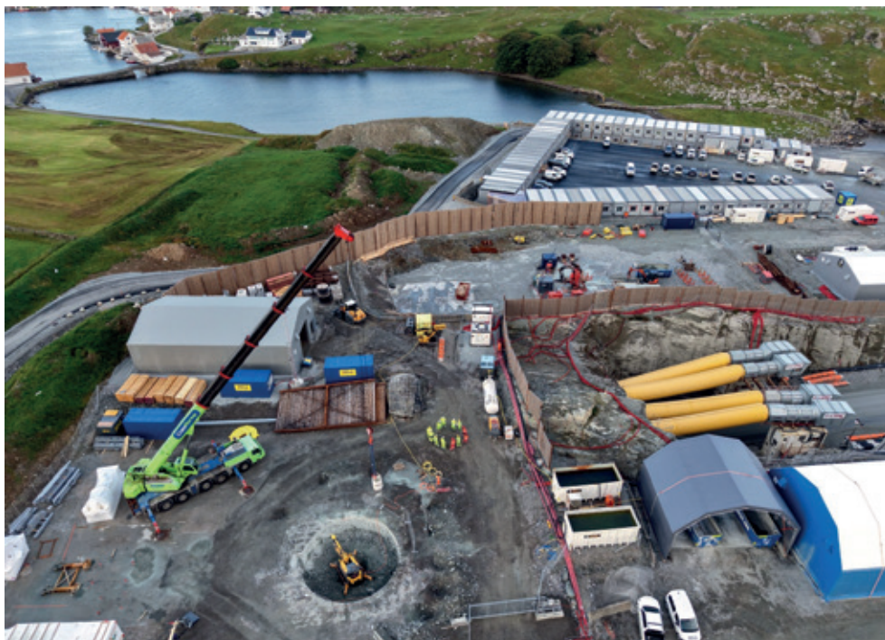
Figur 11 Start sjaktsynking av østre sjakt (utluft).
