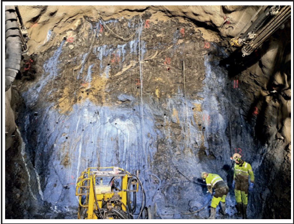
Figur 11 Injeksjon med kolloidal silika i sekundærskjermen i sterkt oppsprukket skifer. Masseinntrengning i fine riss og sprekker og noen utganger vises tydelig.
