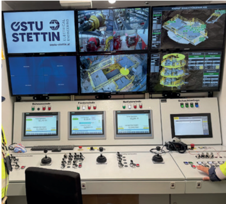
Figur 15: Kontrollrom med god oversikt over sjaktarbeidene.
