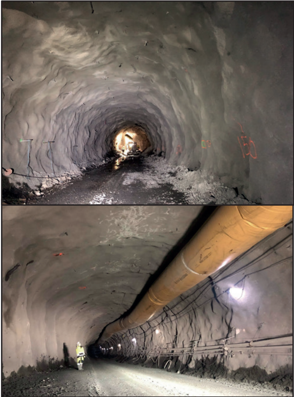
Figur 14 Eksempler på oppnådd tetterresultat i tetteklasse 3 med prosjektert innlekkasjemål < 2 \text{ L/min/100m} . Oppnådd tetting i disse partiene er mellom 0.5 og 1.
