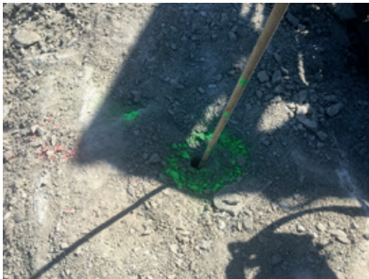
Bilde 3 - Funn av borehull boret inntill 2,0m dypere enn annsett høyden. Foto: Morten Lorentzen
