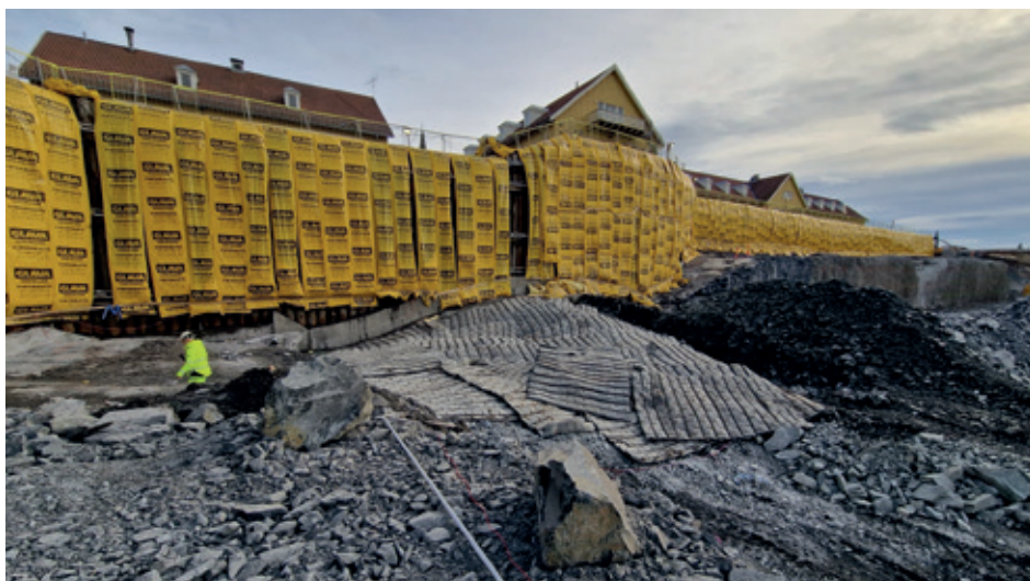
Figur 7: Oppsett med sprengningsområde. Avstand på 4, 7 og 9 m for utplasserte målere grunnet mangel på gode flater for installasjon.
