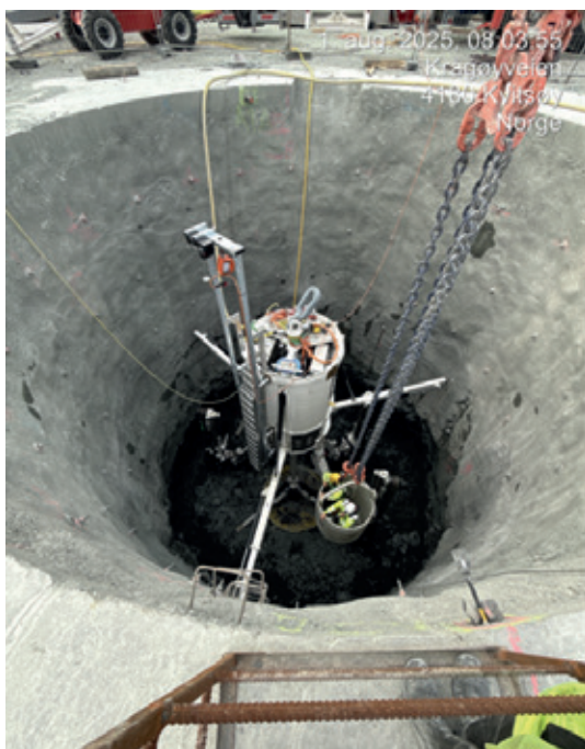
Figur 13, Spesialboremaskinen som benyttes ved sjaktsynking
