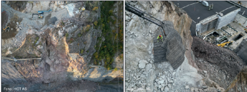
Figur 7: Bilder fra perioden med sprengningsarbeid. Venstre: Oversiktsbilde som viser etablering av arbeidsplattformen. Høyre: Tildekking av matter med kran.
