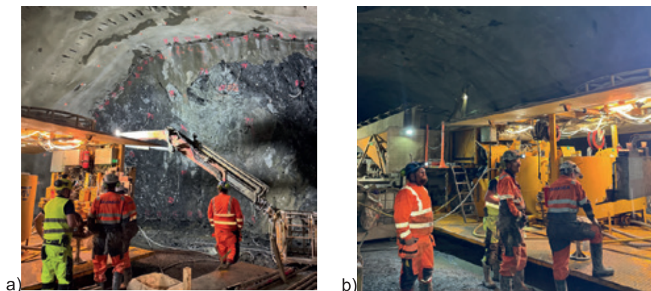
Figur 2: Bilder fra pilottesting av injeksjonsmasse, der 20% av sementen ble erstattet med SiGS (foto: Helene Strømsvik)
