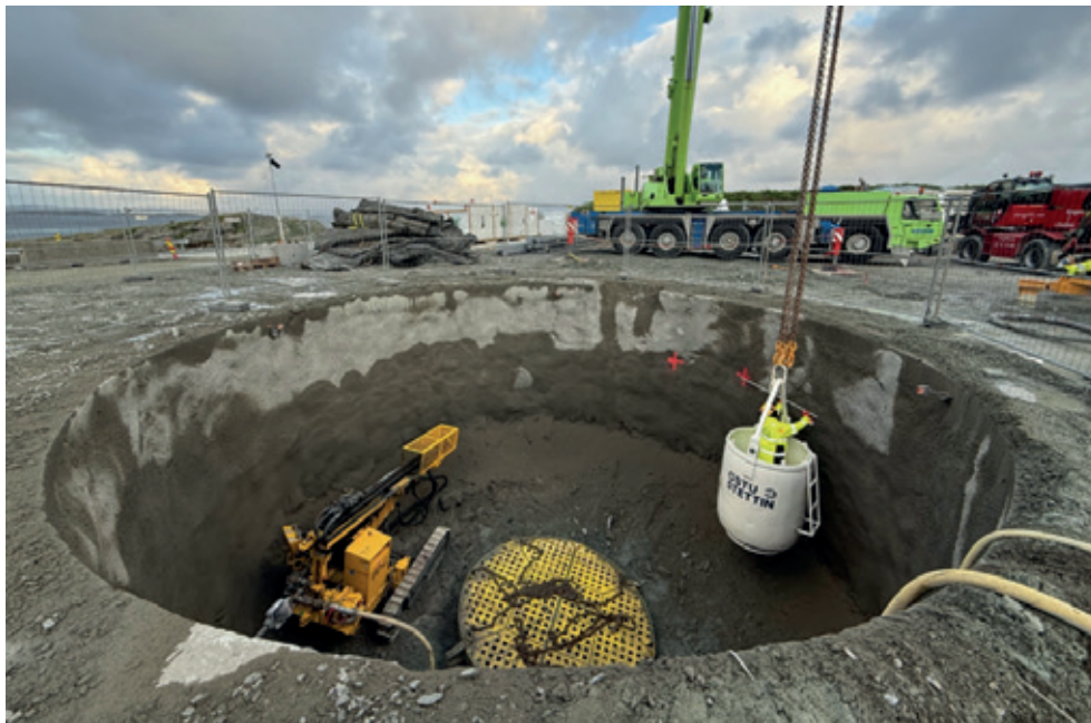
Figur 12: Her ser vi lokket dekke over det opprømmede hullet på Ø 2,4meter
