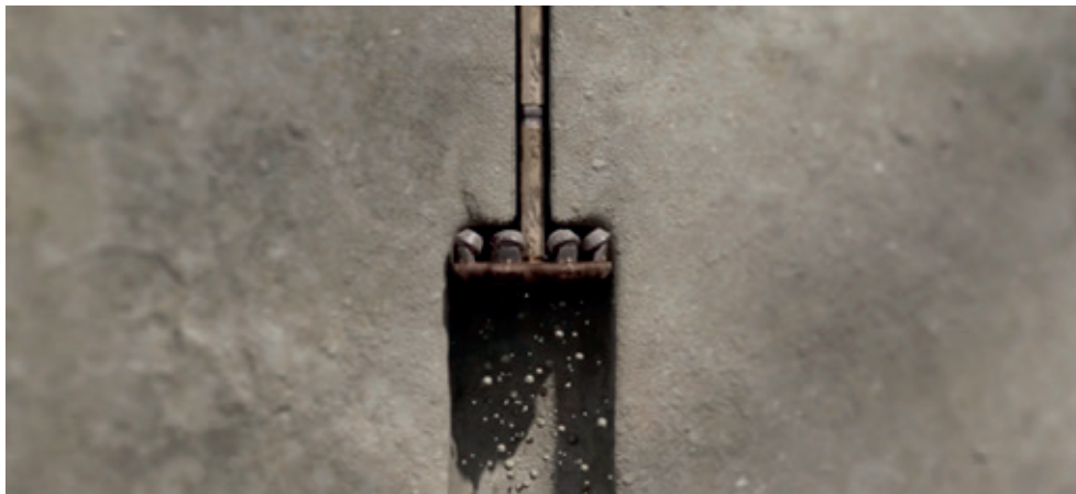
Figur 10 Opprømming. Borkrone på Ø2400mm trekkes oppover med samme borerigg som boret pilothullene.
