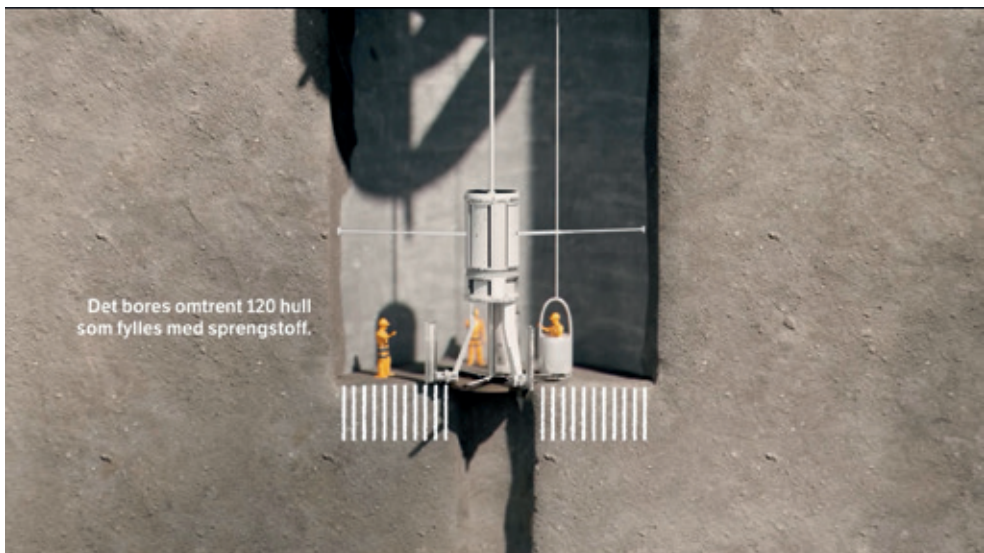
Figur 19: Spesialrigg borer opp salve, ca 120 hull, salve dybde er planlagt til ca 2,5 til 4 meter
