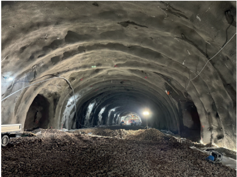
Figur 17 Tetteresultater observert i tunnel sett mot vest.
