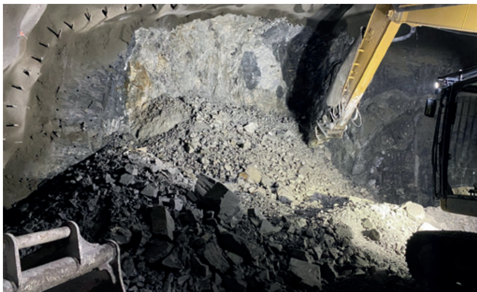
Figur 5 Krevende injeksjon i sterkt oppsprukket intrusivgangene (antatt mænaitt) i pumpestasjon HPS01 i Høviktunnelen. Gangbergart var vannførende med opp i mot 100 l/min før injeksjon.
