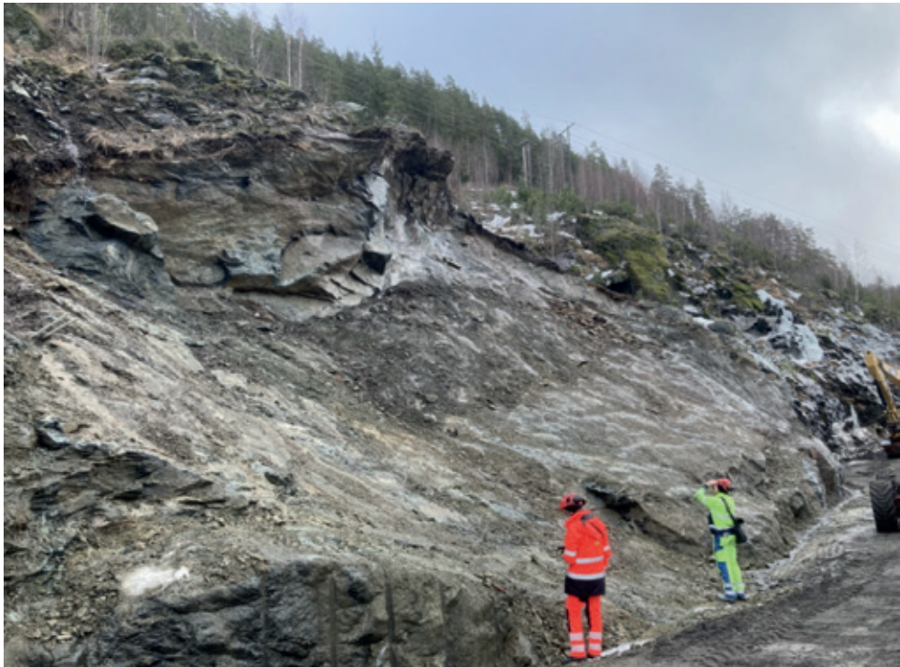
Figur 8. Skredområdet etter nedstrossing og rensk opp til bruddkanten. Foto B Nilsen 25.2.2025.
