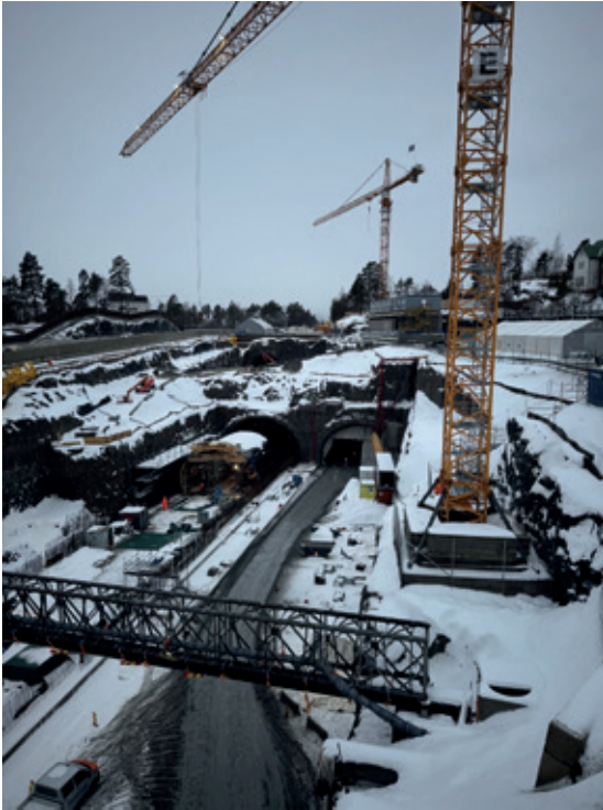
Figur 2 Oversiktsbilde over vestre del av byggegroppen Strand. Høviktunnelen ligger i nederste nivå, med Gjønneestunnelen over. I overkant av venstre bergskjæring ligger dagens E18.
