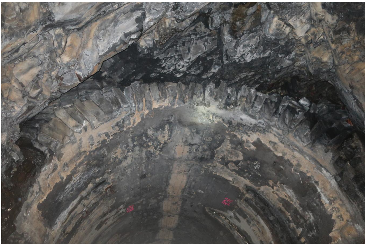
Enden av den gamle løsmassetunnelen, ca 45 m inne i tunnelen. Foto: Amberg Norge AS
