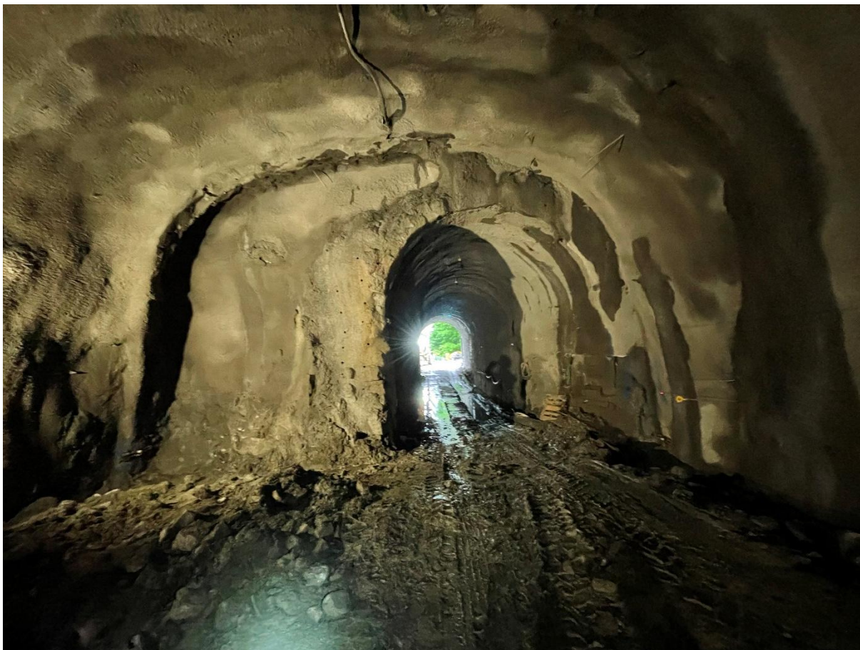
Under utvidelse fra jernbanetunnel til gang og sykkelvei. Foto: Amberg Norge AS
