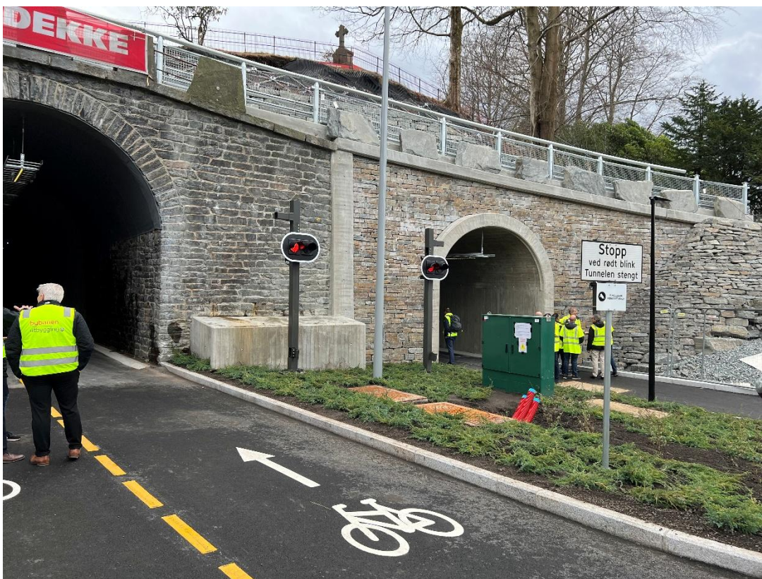
Fra det ferdige anlegget ved Møllendal kapell, den grå betongsøylen viser overgangen mellom gammel portal til venstre og ny til høyre. Foto: Amberg Norge AS
