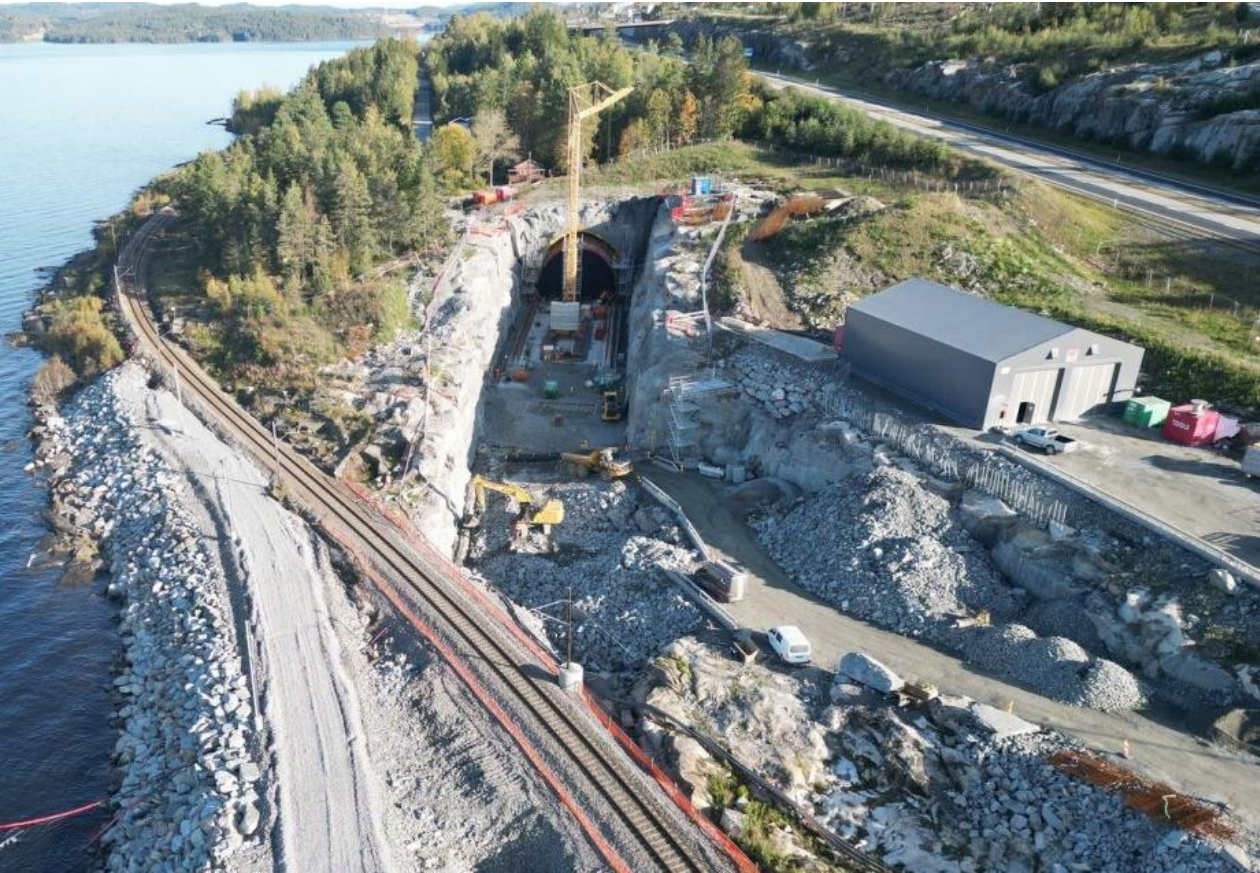
Dronefoto fra Hestnestunnelen
