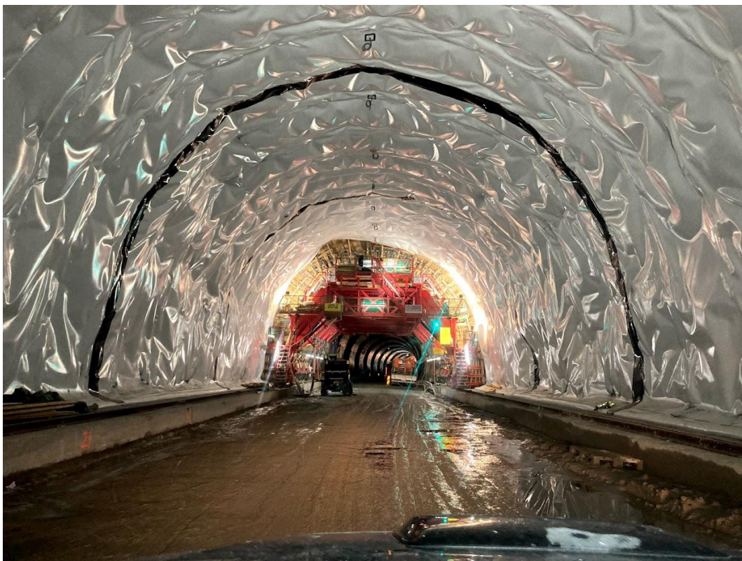
5 Montert membran med forskalingsvogn til betongstøp – UDK01 Drammenstunnelen
