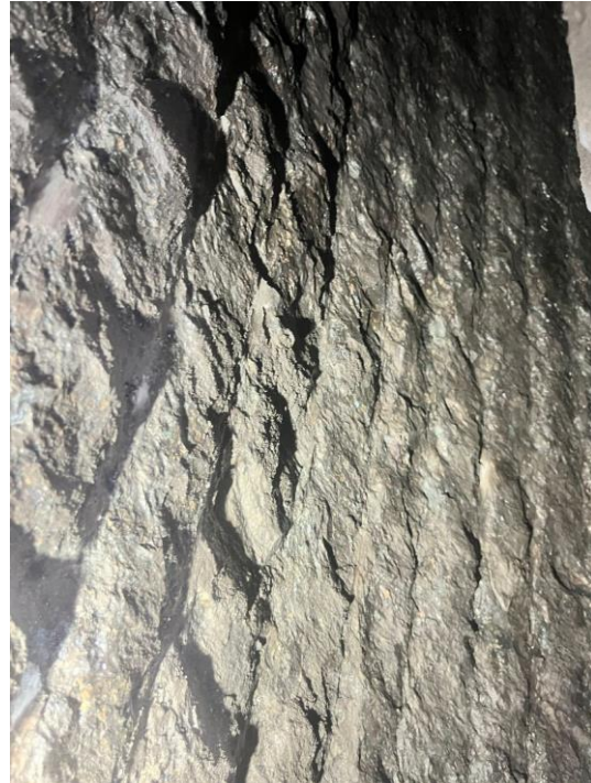
Stuff 01.02. Svært få sprekker, ingen forvitring. Høy Q-verdi
