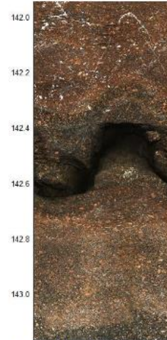
Eksempel på åpen sprekke i rombeporfyr, hammerborhull HB1719 ved Jonsrudtjern, Bærum
