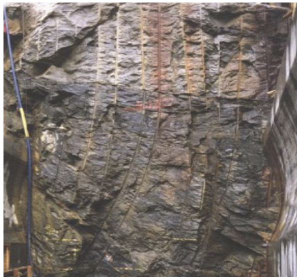
Figur 4.10. Eksempel på uheldig retningsavvik.
