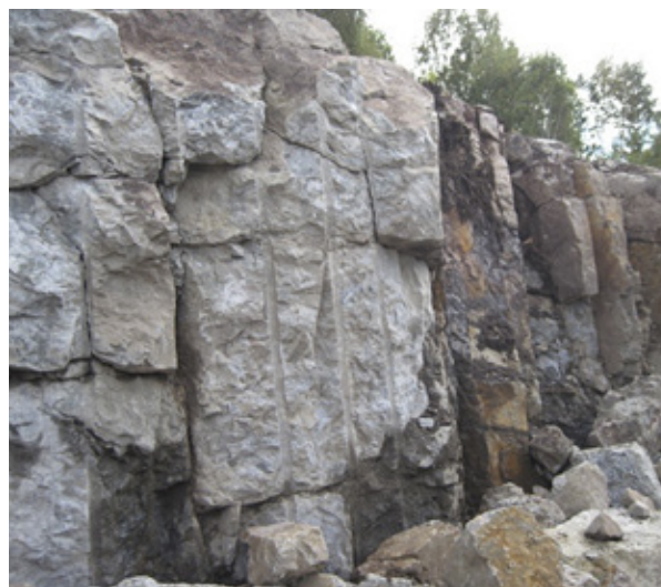
Figur 4.4. Kontursprengning. Foto: Jan Mehren.
