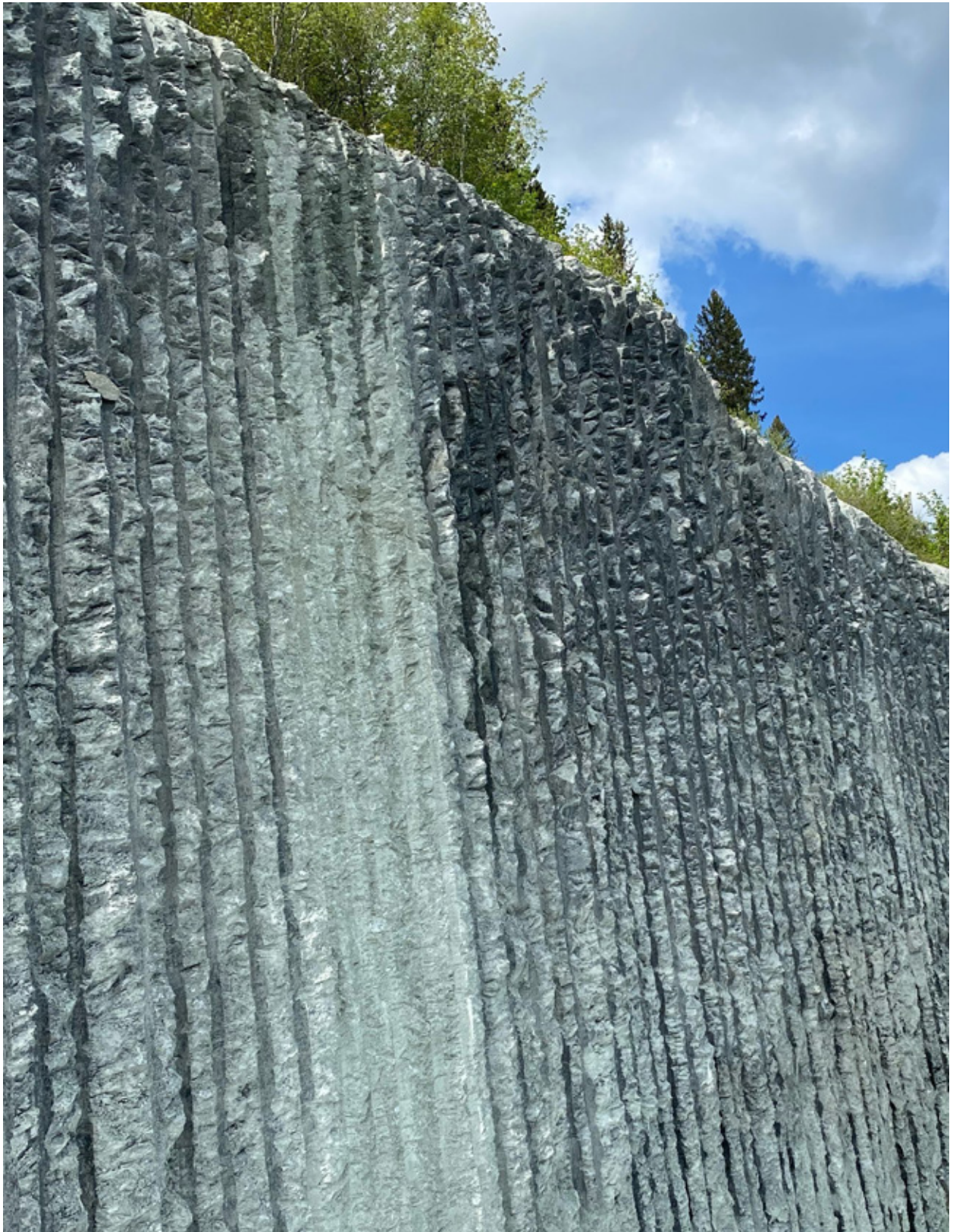
Figur 5.5. Sømboring. Foto: Letnes Fjellsprengning.
