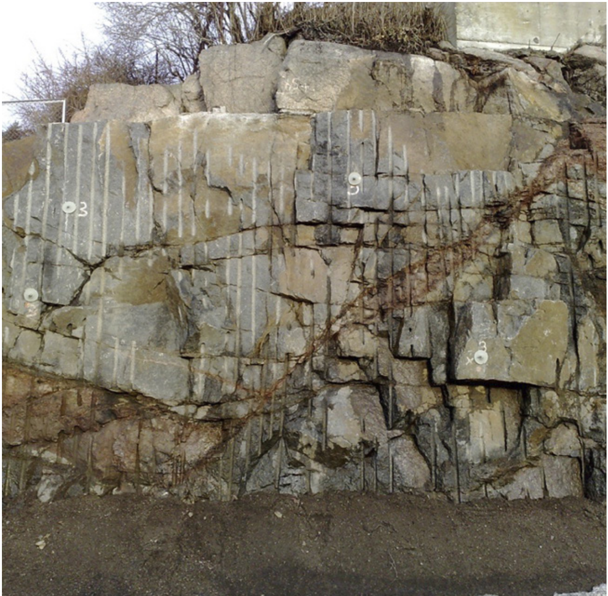
Figur: 5.6. Kombinasjon av sømboring og kontursprengning. Foto: Jan Egil Blix.
