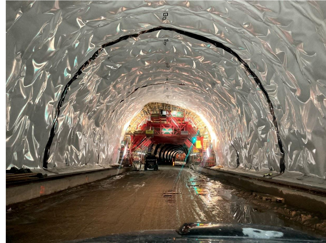
Montert membran med forskalingsvogn til betongstøp – UDK01 Drammenstunnelen
