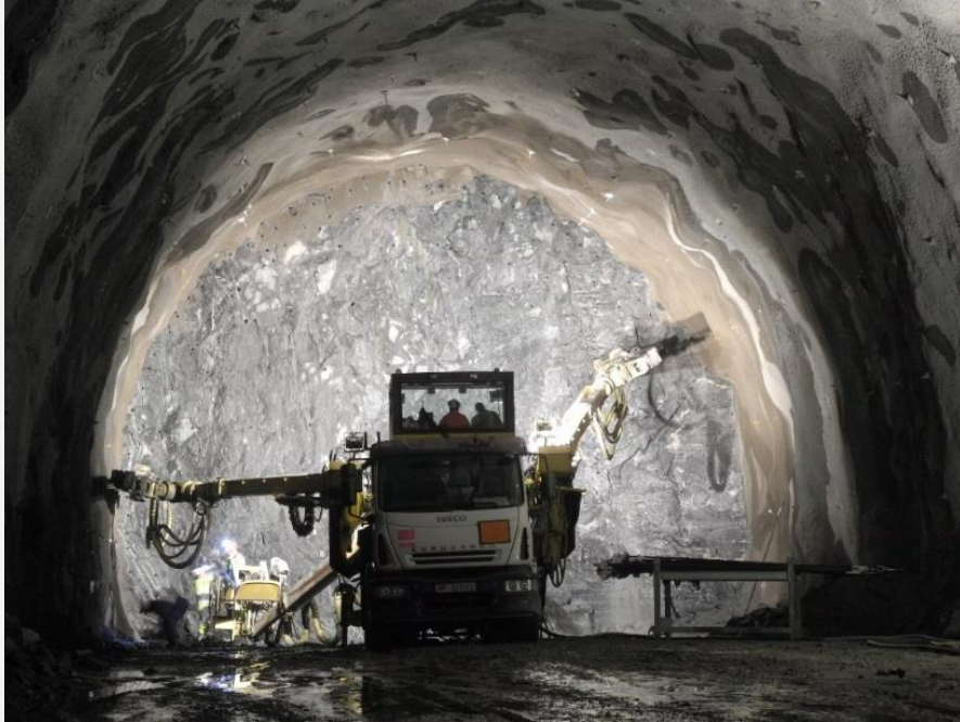
Ulvintunnelen under driving, desember 2012
