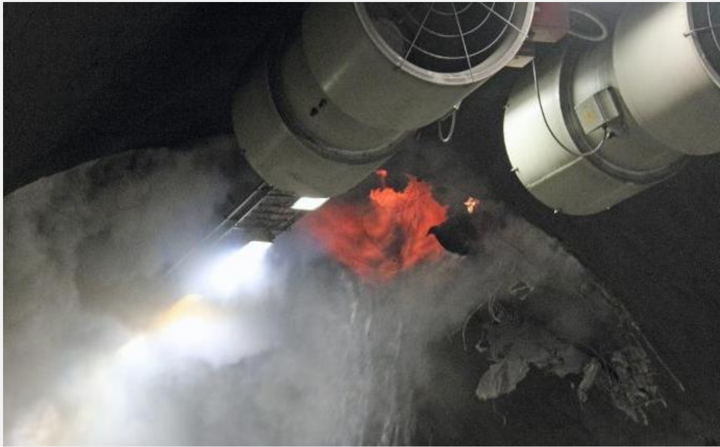
Brennende PE-skum, E6 Eidsvollstunnelen, februar 2012 (kilde: Statens Vegvesen)
