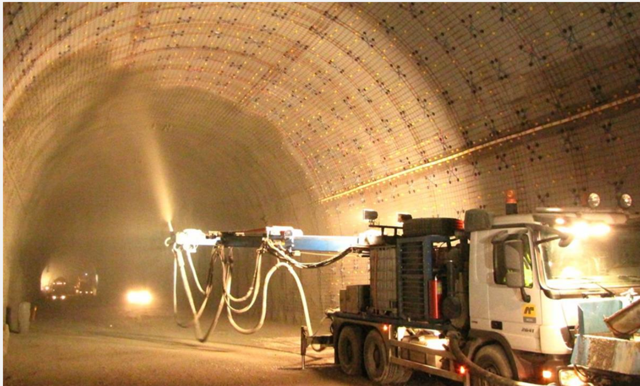
Gevingåstunnelen, fra byggingen av seksjon med PE-skum hvelv, mars 2009
