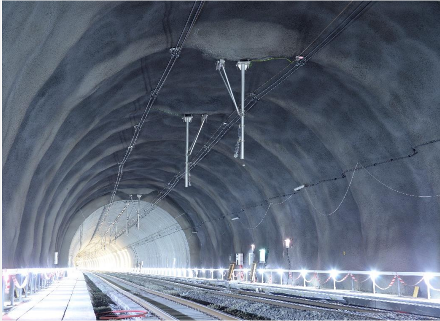
Holmestrandporten under bygging, mai 2016
