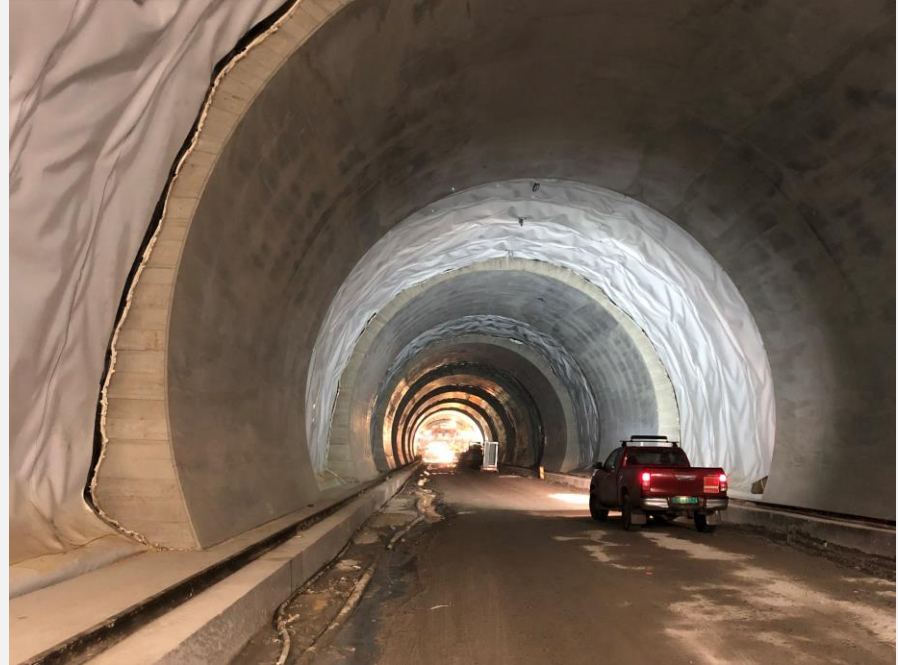
UDK01, dobbeltsporet jernbanetunnel Drammen-Kobbervikdalen, under bygging, april 2022
