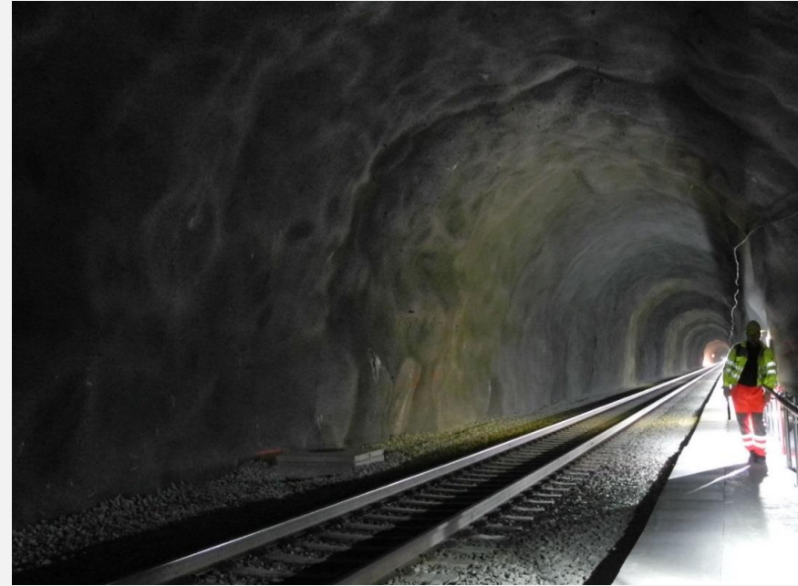
Gevingåstunnelen, april 2014 - Blir elektrifisert 2022-2023
