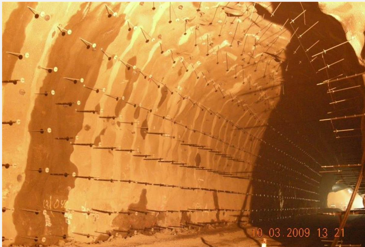
Gevingåstunnelen, fra byggingen av seksjon med PE-skum hvelv, mars 2009
