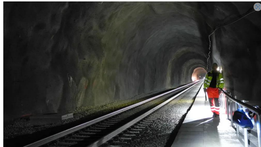
I den fire kilometer lange Gevingåstunnelen er cirka to kilometer dekket med sprøytetbetong og sprøytetmembran. Bilde: Karl Gunnar Holter
