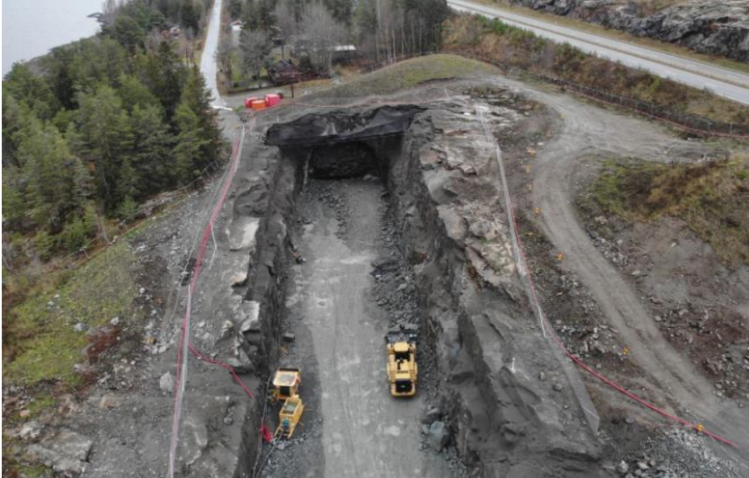
I GANG. I høst startet Veidekke drivingen av den 3,1 kilometer lange Hestnestunnelen langs Mjøsa. Når tunneldrivingen etter planen er i gang for fullt i desember, vil entreprenøren angripe tunnelanlegget fra tre stuffer. DRONEFOTO: BANE NOR.
