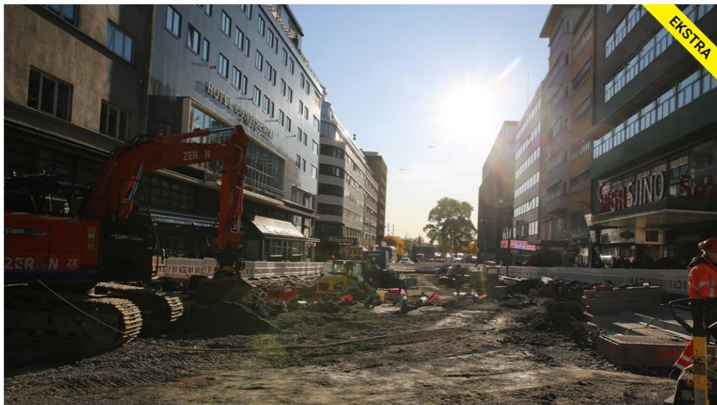
I Olav Vs gate i Oslo sentrum har Oslo kommune det de tror er verdens første utslippsfrie byggeplass. (Foto: Ida Oftebro/Teknisk ukeblad)
