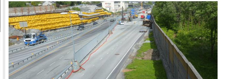
Fra byggingen av E39 Svevatjørn-Rådal. Foto: Statens vegvesen
