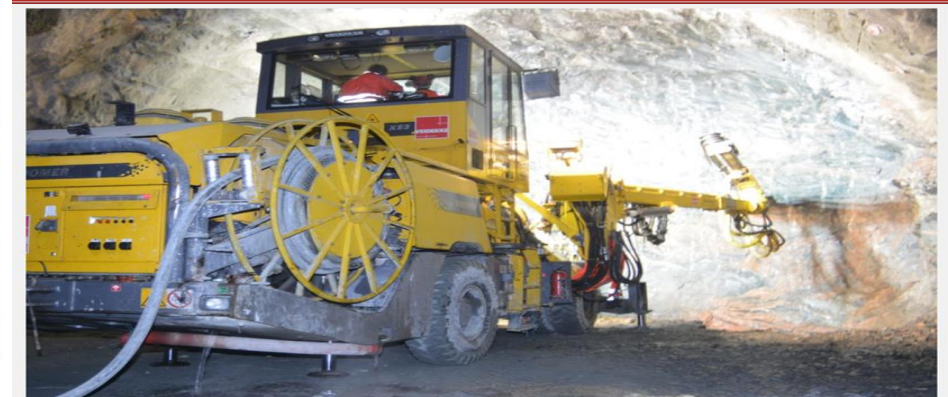
Veidekke tapte i lagmannsretten i saken om korte frister i Lyshorntunnelen. Foto: Geir Brekke / Statens vegvesen
