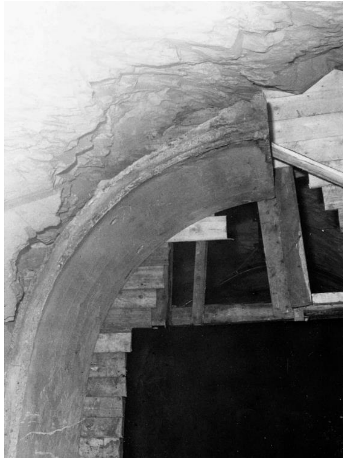
Arbeider med innstøping av betongbuer
