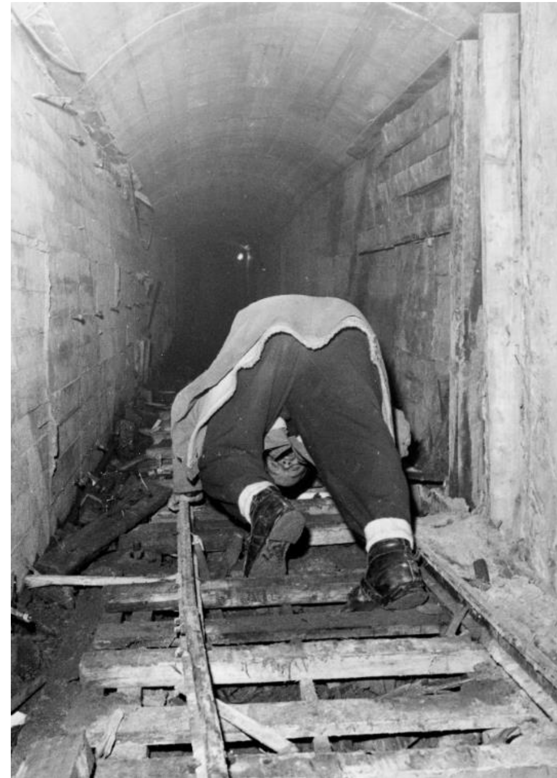
Innstøpt del av stigort
