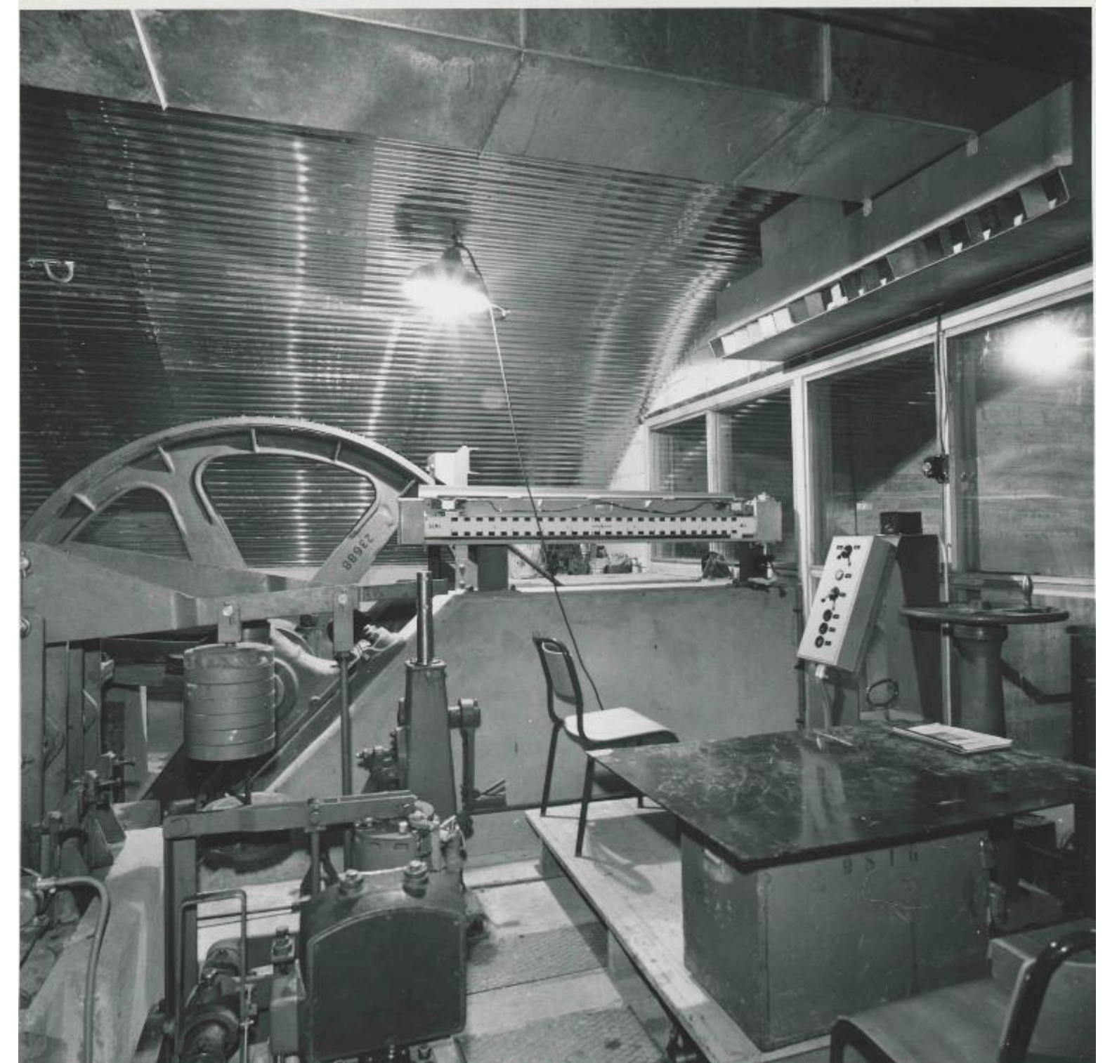
Drivverket i øvre stasjon
