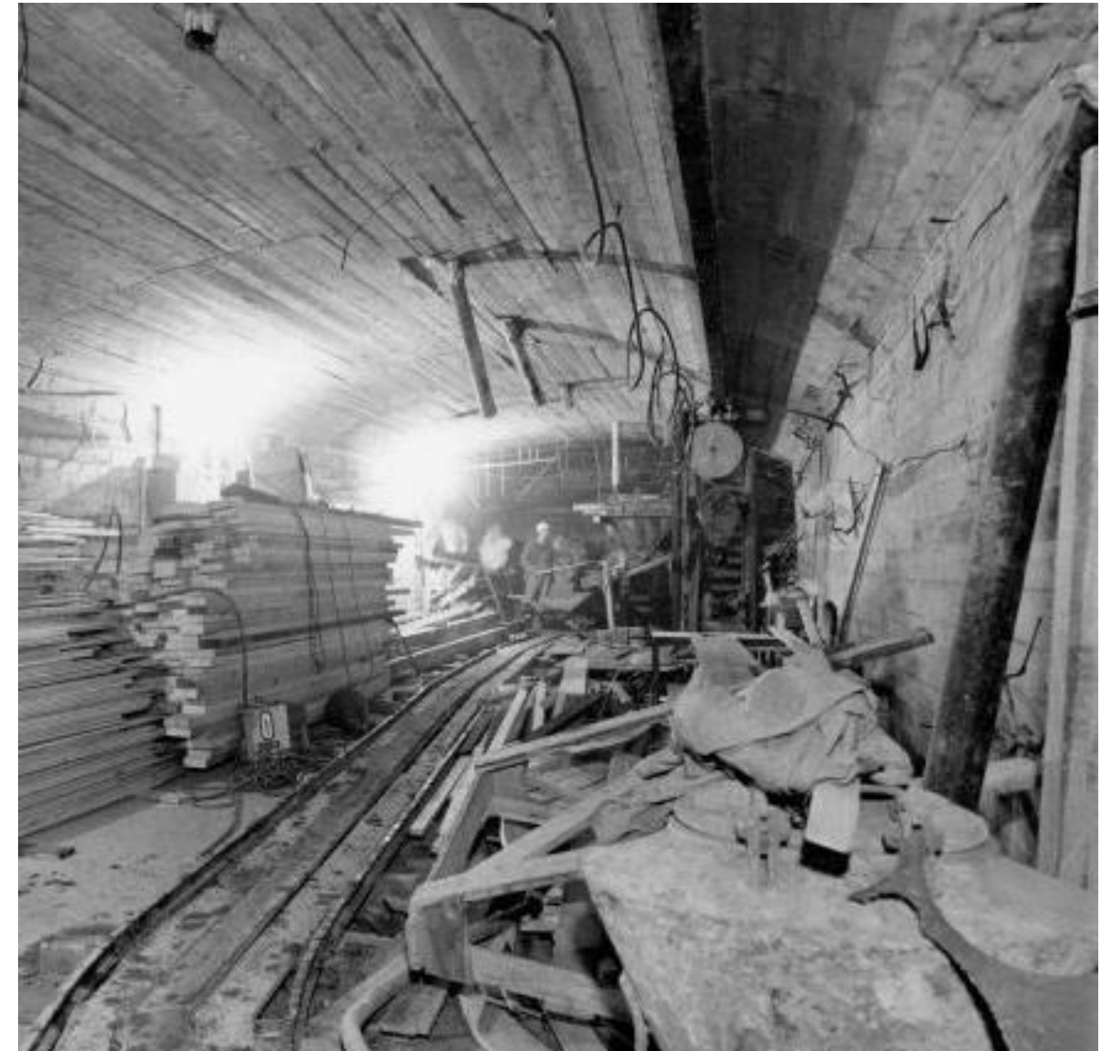
Betongarbeid med full innstøping av øvre stasjon
