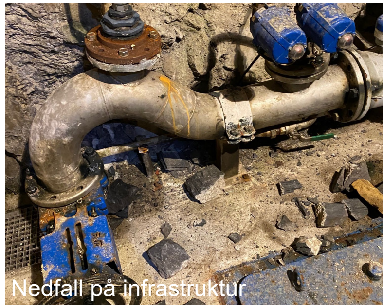
Bløkkeringsras i overvannstunnel
