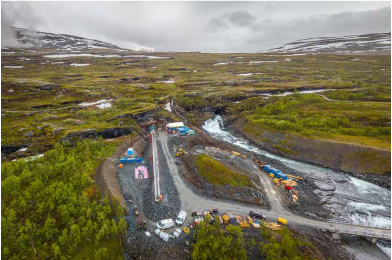
Riggplass, Salvasskardelva overføringstunnel. Foto: Kalle Punsvik/ The Robbins Company
