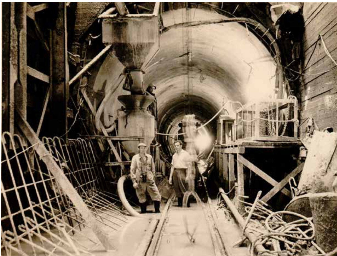
Arbeidskrevende tunneldrift Arbeidssikring tilpasset behov, fra stål, treverk til sprøytebetong Til venstre: stålbuer og treverk. Til høyre ferdig støpt. Alt arbeidskrevende!
