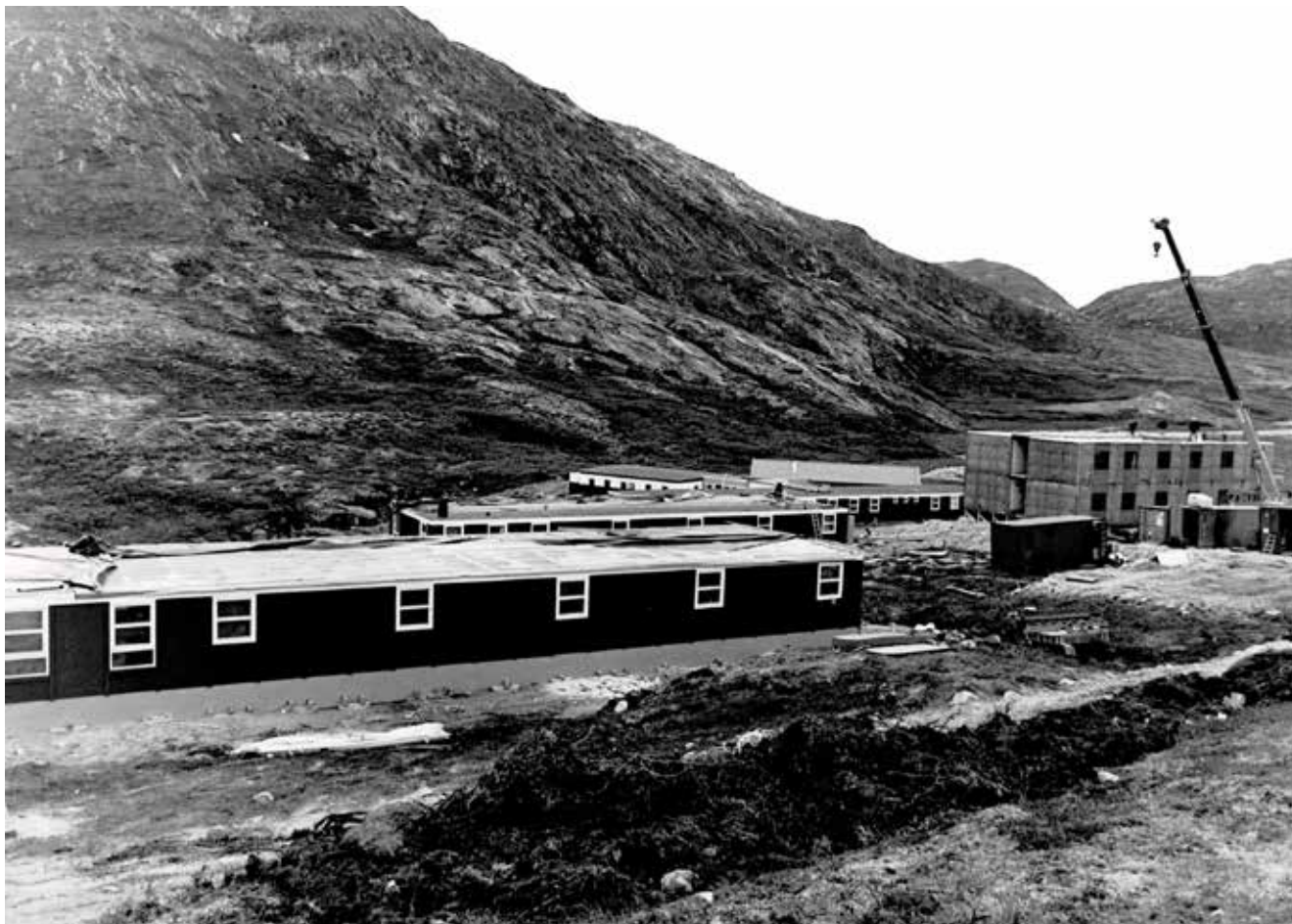
Brakkerigg monteres i kraftstasjonsområdet
