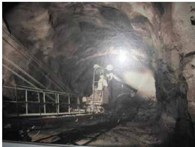
Tørrsprøyting. Kvalitet bra, men mye støv, stort prelltap og beskjeden fremdrift. Foto fra Ola Woldmos foredrag.
