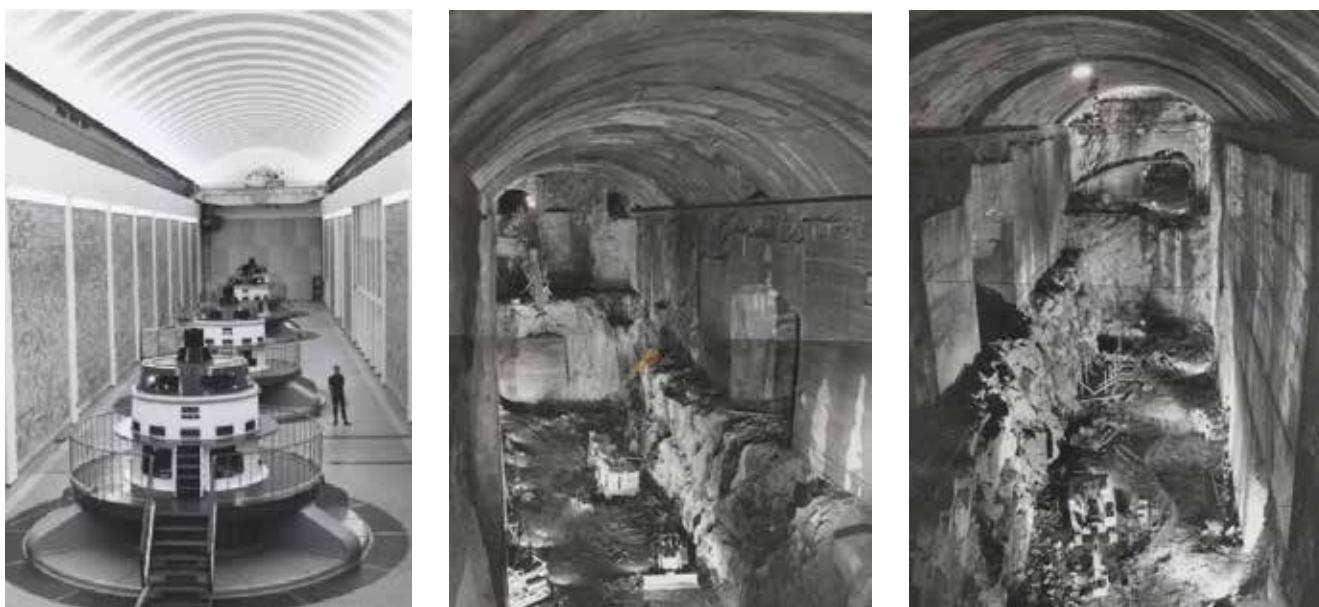
Tokke 1 som var den største stasjonen i prosjektet og fortsatt er blant dei største i Noreg med 450 MW kapasitet. Til venstre med sine 3 aggregat ferdig montert, dei andre to visar frå anleggsperioden. Foto Jostein Granli
