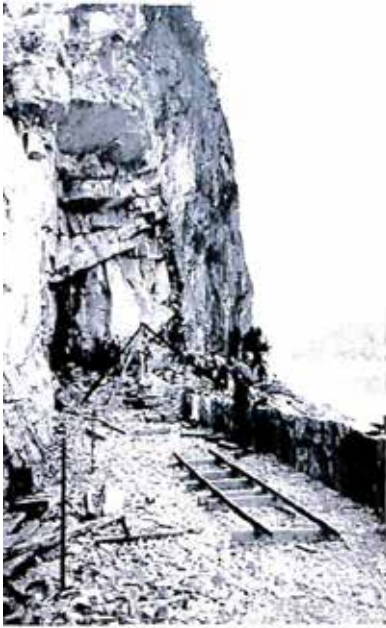
Påhugg for den lange Høgaberg tunnelen. I dag ville nok både Vegvesenet og entreprenør anse utførelsen for dristig.
