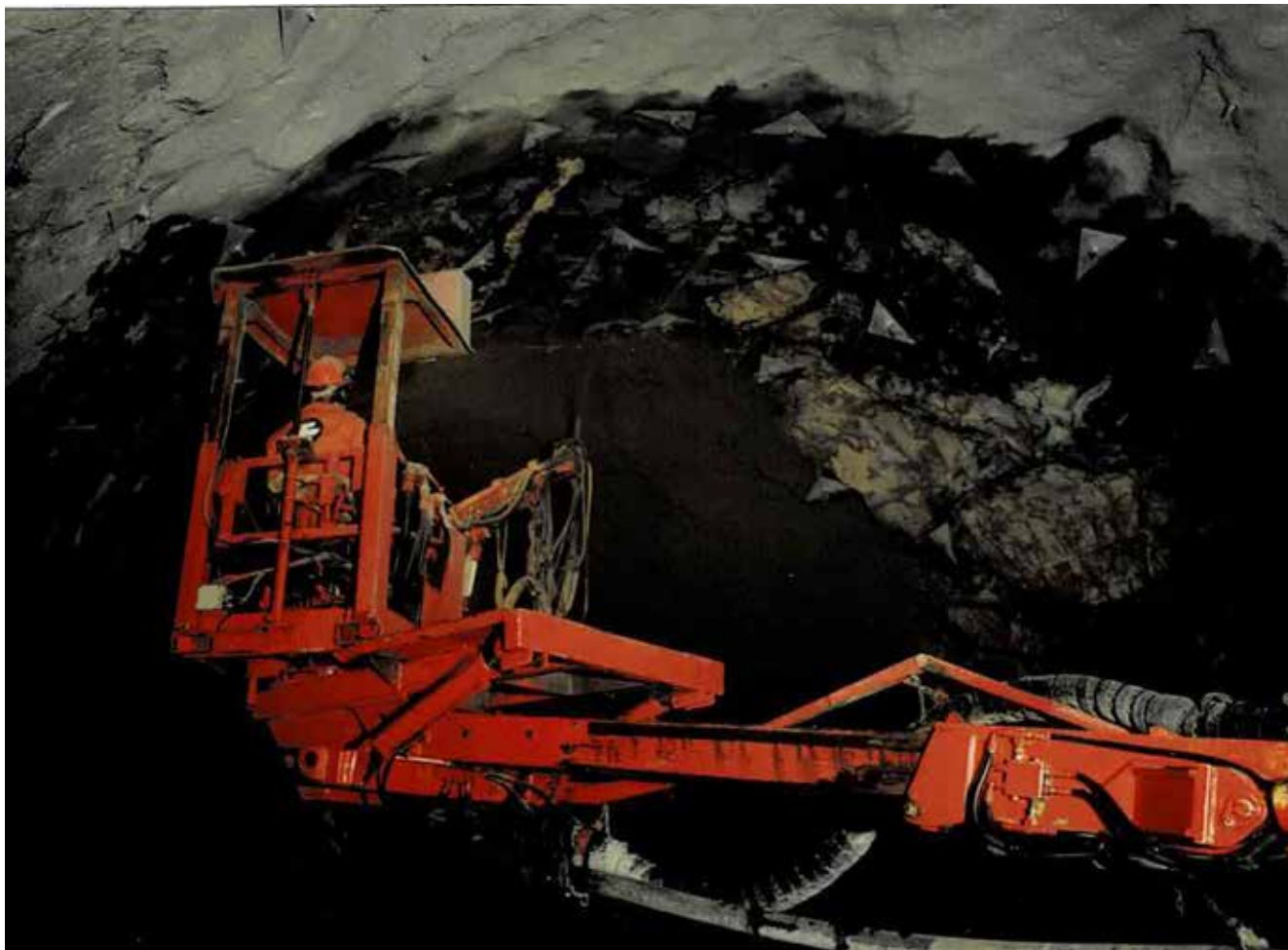
Bildet av Giraffen her montert på løftebukk til arbeidsplattform.
