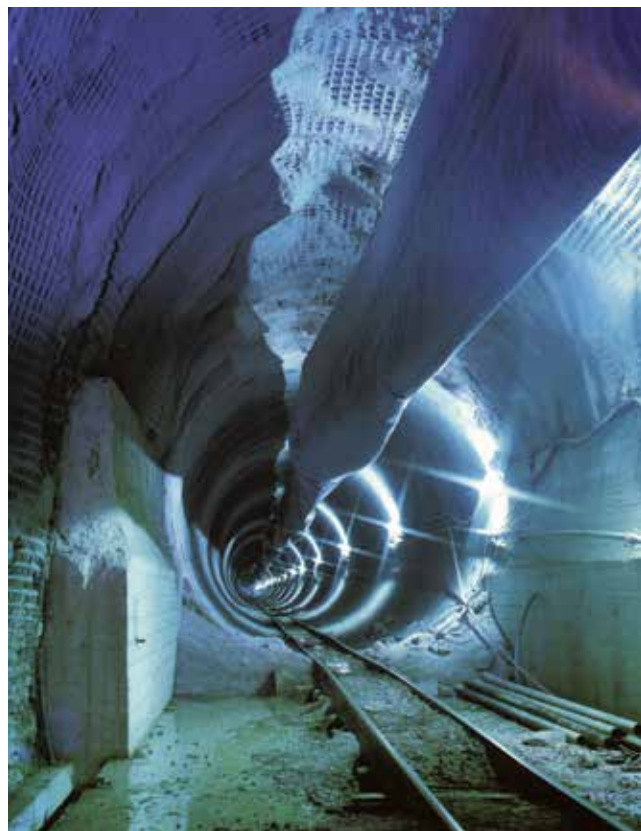
Startportal for åpen Hard Rock TBM. Foto: The Robbins Co.
