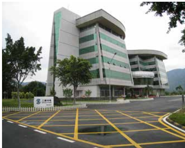
På kjempeanleggene i Yalong og Jinsha bygges det fasiliteter for administrasjon/eller som her hoteller. Standarden ligger milevis over det AGN møtte for 30-40 år siden.
