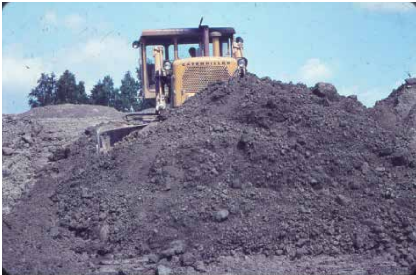
Den harde tørrskorpeleira smuldrer opp til fine masser for bygging av kvalitetsfylling når dozeren skjærer den ut i tynne lag.
