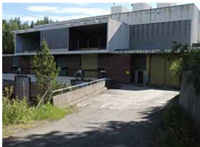
Skogfoss kraftverk. Foto Pasvik kraft
