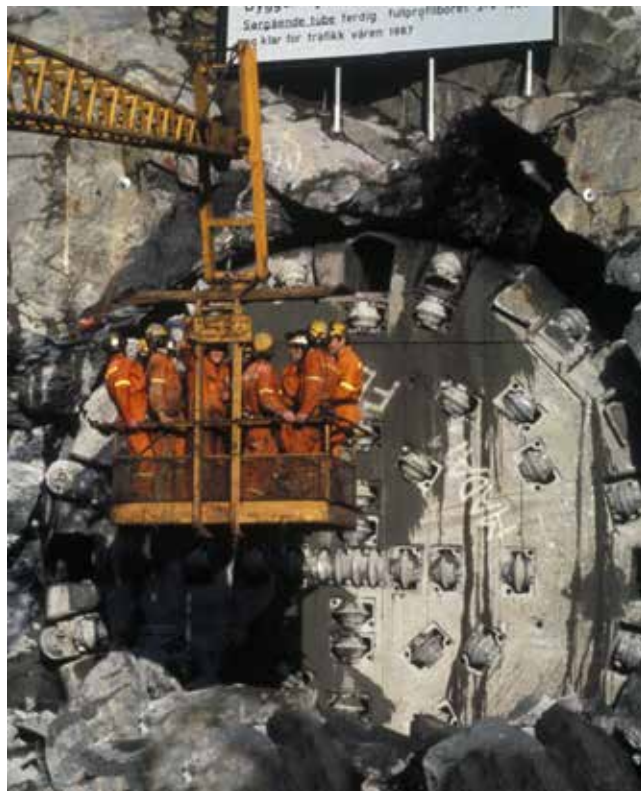
"Madam Felle" – gjennomslag på sørgående tunnel, Fløyfjellstunnelene. Foto: Arnulf M.Hansen
