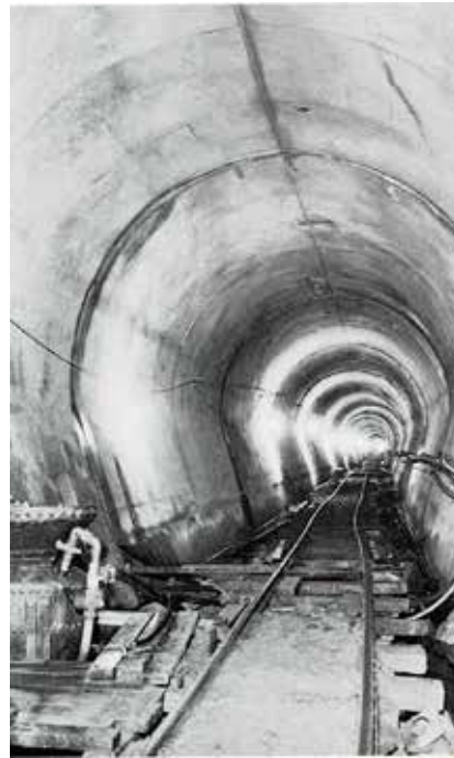
Arbeidskrevende tunneldrift Arbeidssikring tilpasset behov, fra stål, treverk til sprøytebetong Til venstre: stålbuer og treverk. Til høyre ferdig støpt. Alt arbeidskrevende!
