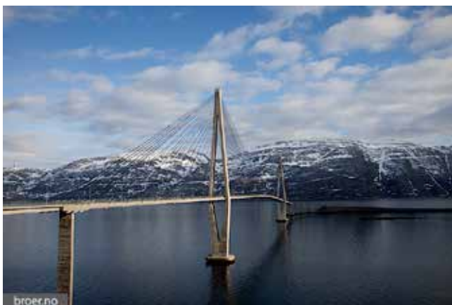
Foto: Aker Entreprenør
