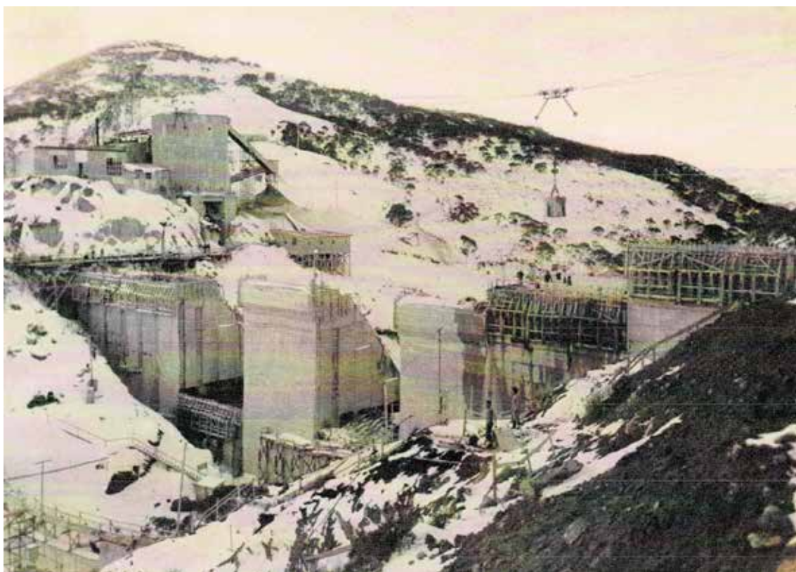
Damavsnittet hadde andre utfordringer. Mer masse bort, ca. 60% mer betong inn.
