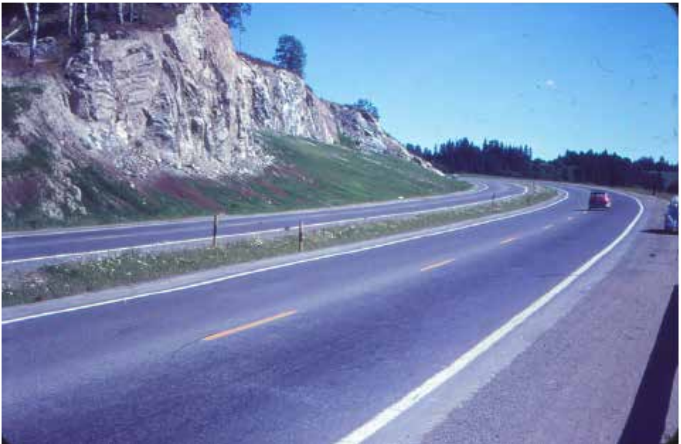
Anleggets eneste fjellskjæring, ved Brånås. Utvidet med sidetak, tilbakefylling av diverse blandingsmasser. Nå skogbevakst.
