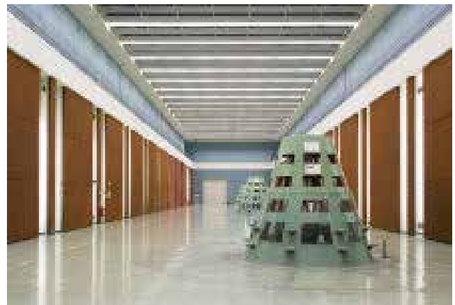
Aurland 1 kraftstasjon i Vassbygdi. 3 aggregater, hvert på 225 MW, senere ombygd til 280 MW. Aurland 1 er den største kraftstasjonen i Aurland og den tredje største i Norge. Tonstad i Sira-Kvina produserer mest kraft. Nr.2 er Kvilldal som til gjengjeld har størst effekt.
