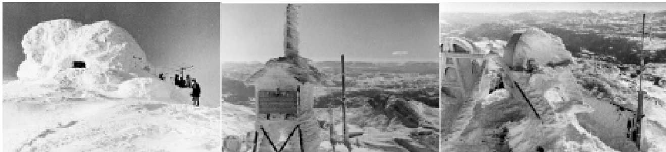
Vinterforhold på Gaustatoppen. Turisthytta med bare kjøkkenvinduet synlig, deler av værstasjonen og nediset antenneanlegg.
