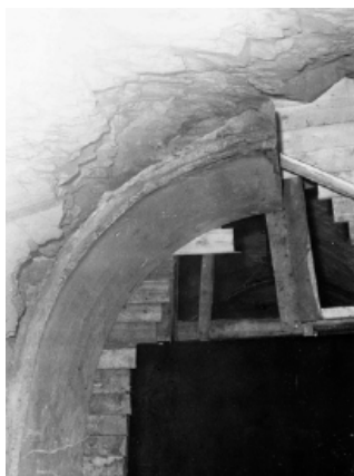
Arbeider med innstøping.
