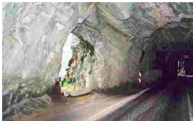
«Vindu» for lys, ventilasjon og tipp for sprengt masse i en lengre tunnel. Foto Liv Marit Rui / Statens vegvesen.
