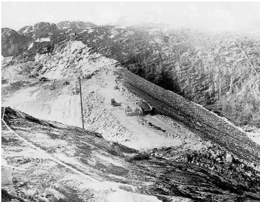
Foto: Dam Digeå i Sirdal Maskinkjøernes svar kunne i begynnelsen høres ut som rop i havsnød. Men dette førte til en formidabel kapasitet. Vi kom opp i 120.000 m 3 damfylling pr. uke, mens 80.000 m 3 var det mest optimistiske tallet i forvgen. Vi bygget slik den 2,9 mill. m 3 store hoveddammen nesten ferdig i den 6 måneder lange 1969 damsesonen, mens 1968 sesongen praktisk talt hadde regnet bort for oss på grunn av vanskelige morenemasser i det konstante regnet.
