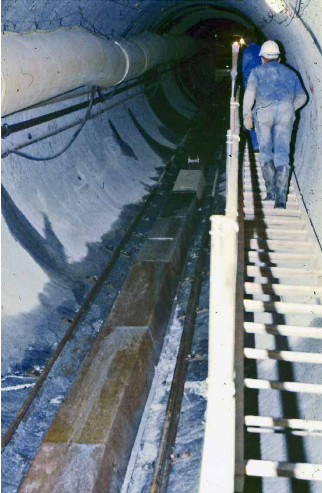
TBM-sjakt, 45 grader, Sildvika kraftverk. Foto: A/S Høyer-Ellefsen
