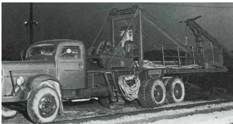
Bildet viser landets første sprøyterobot i 1963 på Tokke 2. Referanse: Dir. Arne Wabakken i boken «Sørvicen» fra 1997. Fotograf ukjent, trolig fra NVE eller ES.
