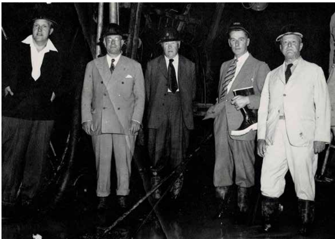
Fredrik Selmer i midten, her på inspeksjon i tunnelen sammen med representanter fra byggherren med anleggsle- der Hartvig Quale til venstre. Pent antrekk, kanskje ikke det man ville bruke i dag.
