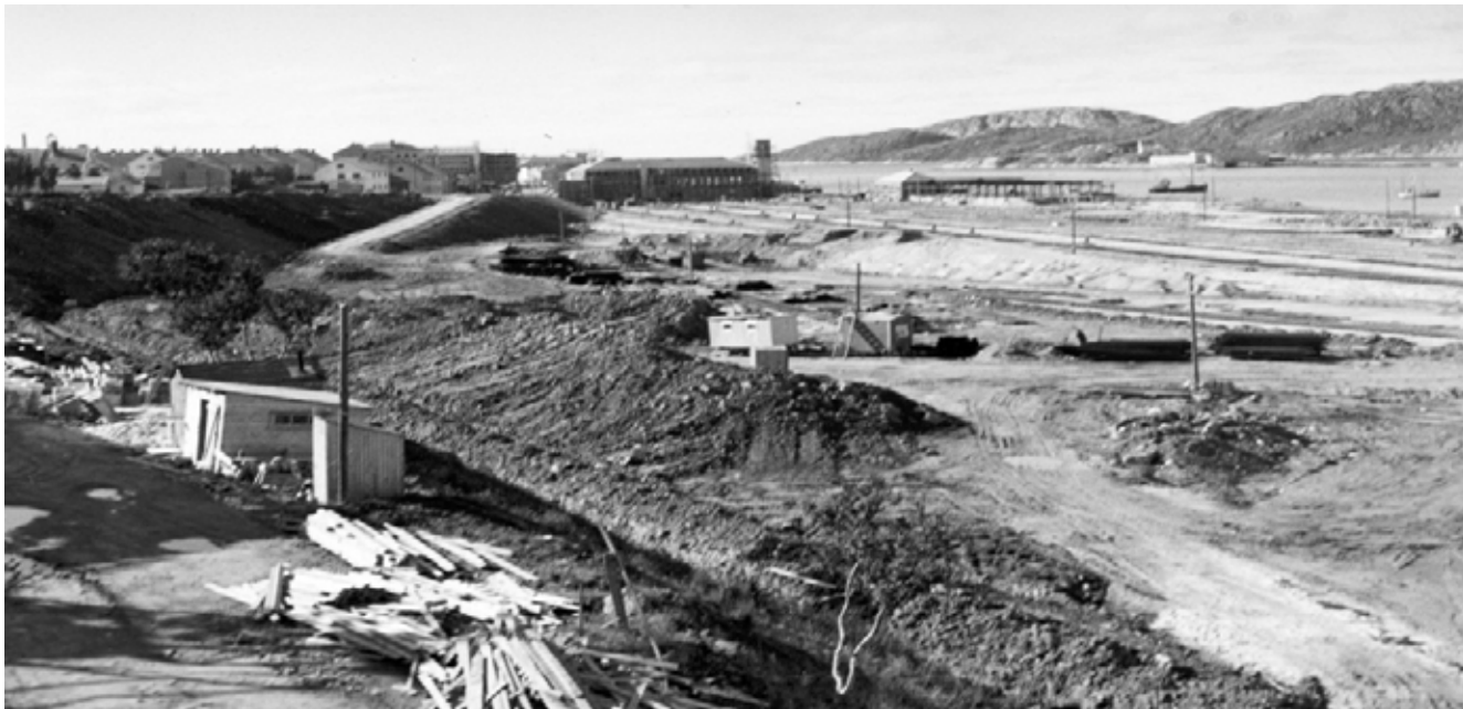
Anleggsarbeid på Bodø stasjon 1960-61. Norsk jernbane-museums samling.
