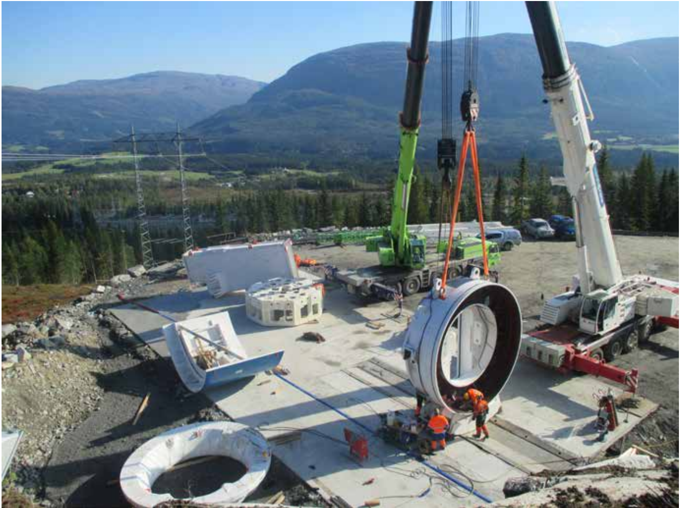
Montering av 7,23m diameter Robbins HP TBM. Foto: The Robbins Company
