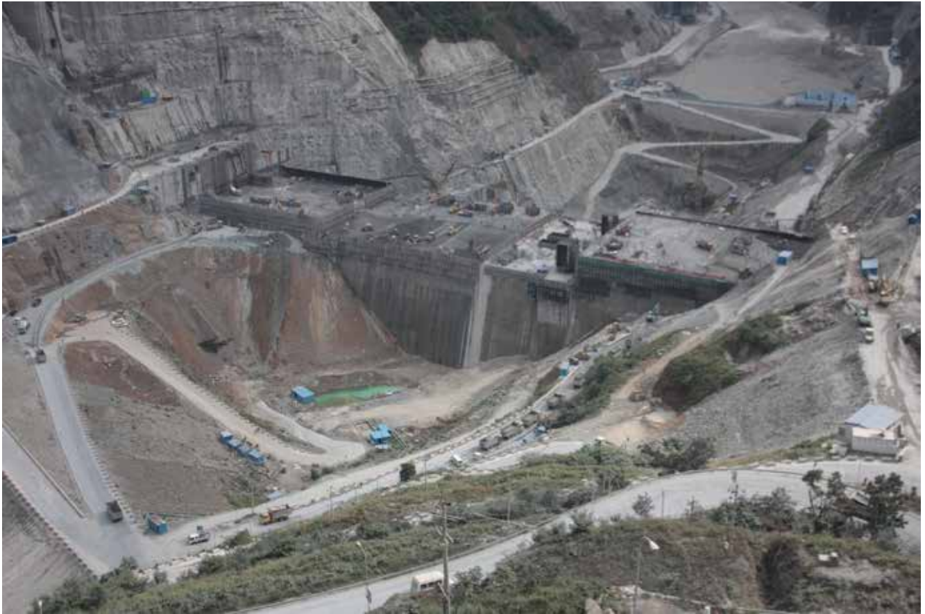
Jing Ping 1. Her bygges en betong buedam. Den har nå en høyde på 305 m. På bildet skimte de første 90 metrene. AGN hadde litt befatning med anlegget i tidlig fase. Bildet er tatt under et besøk 2010. Anlegget er for lengst fullført. Foto:Panos Galanos
