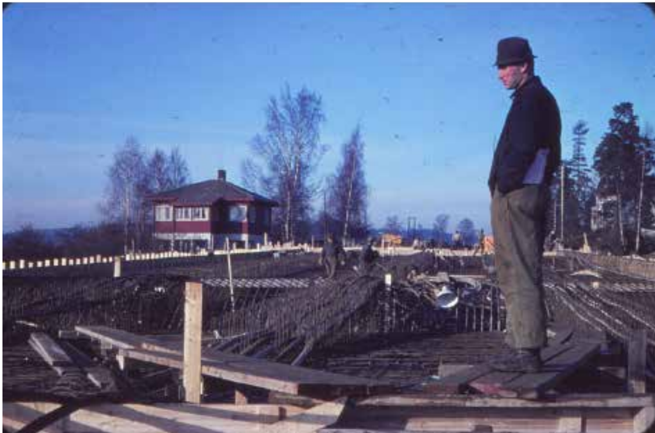
Ingeniør Lars Larson tar et overblikk på dekkearmeringen på Skedsmovollen bru, senhøstes 1964, ganske så få uker før veiåpningen 21. desember.
