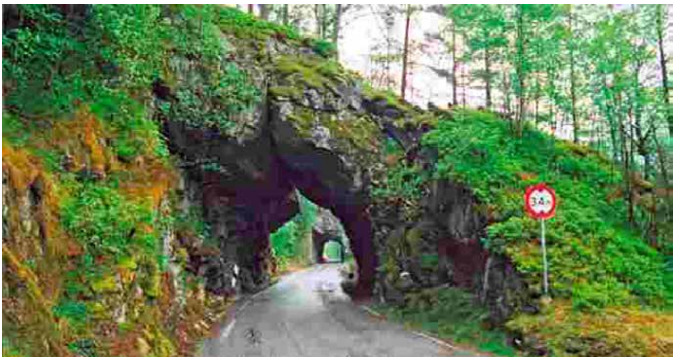
Eksempel på «kort» tunnel. Foto Liv Marit Rui / Statens vegvesen.
