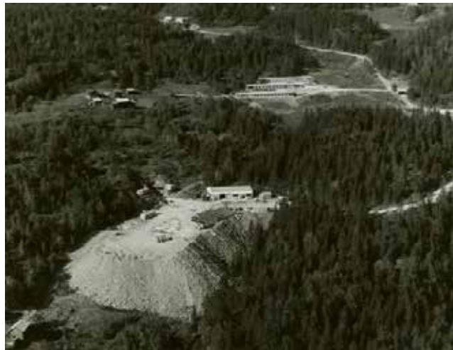
Tverrslag 4 frå Bakkane i Eidsborg ca.1959. Som Ordføreren sa vert det store inngrep i naturen, men og store fordelar for bygdane. Dette var før det var snakk om lenkegjengar og andre protestaksjonar. Foto Jostein Granli
