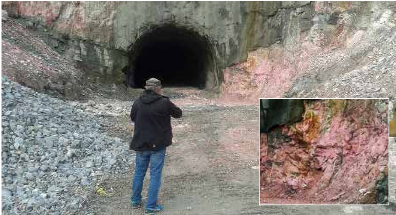
Foto 2: Thulitt i påhogget for tunnel på "laksevegen" til Hitra, Rv 703. Innfelt eit nærfoto av thulitt-veggen.
