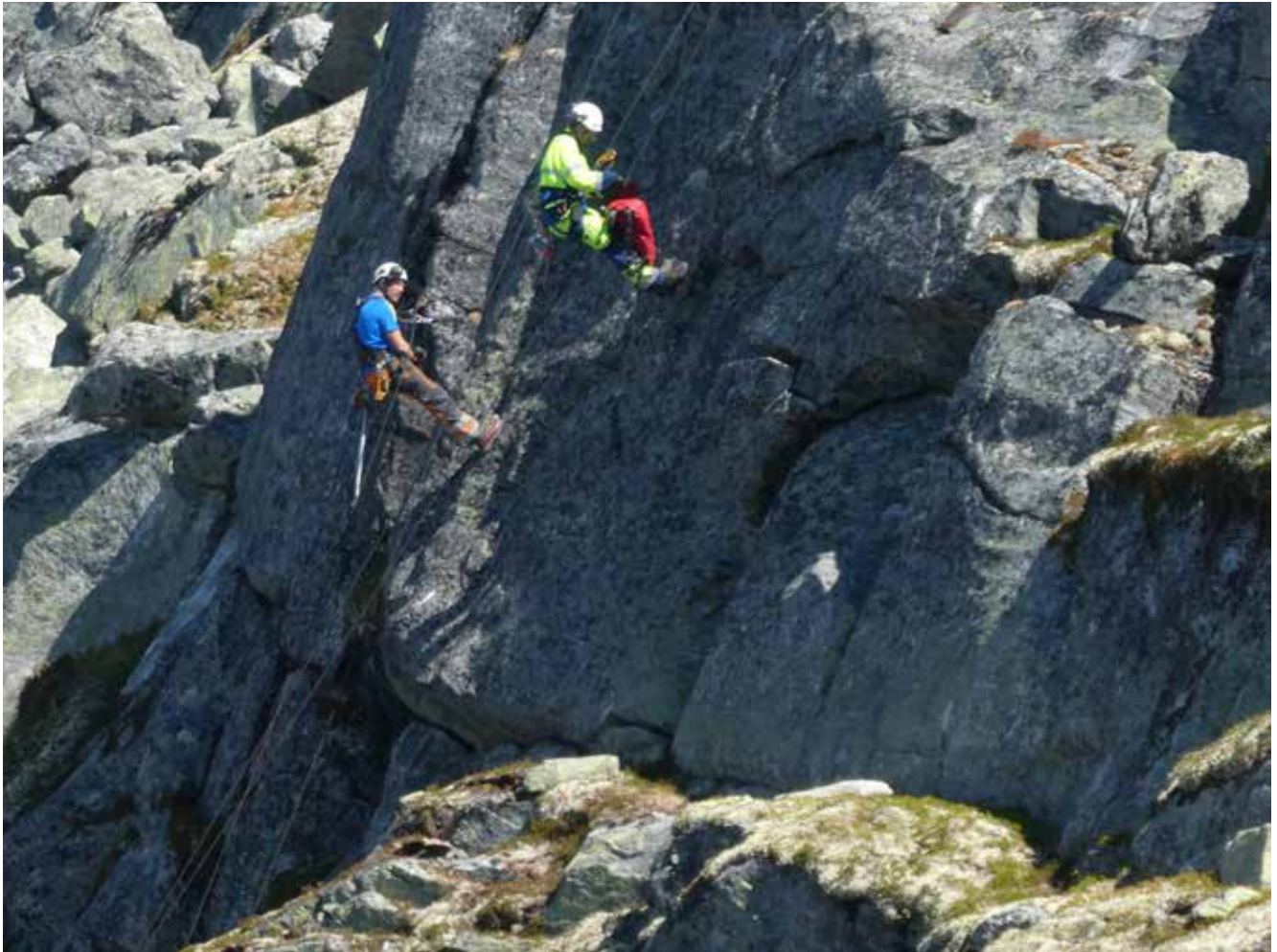
Mindre vanlig fjellsikring Hervaskår. OK i sommersonne.
