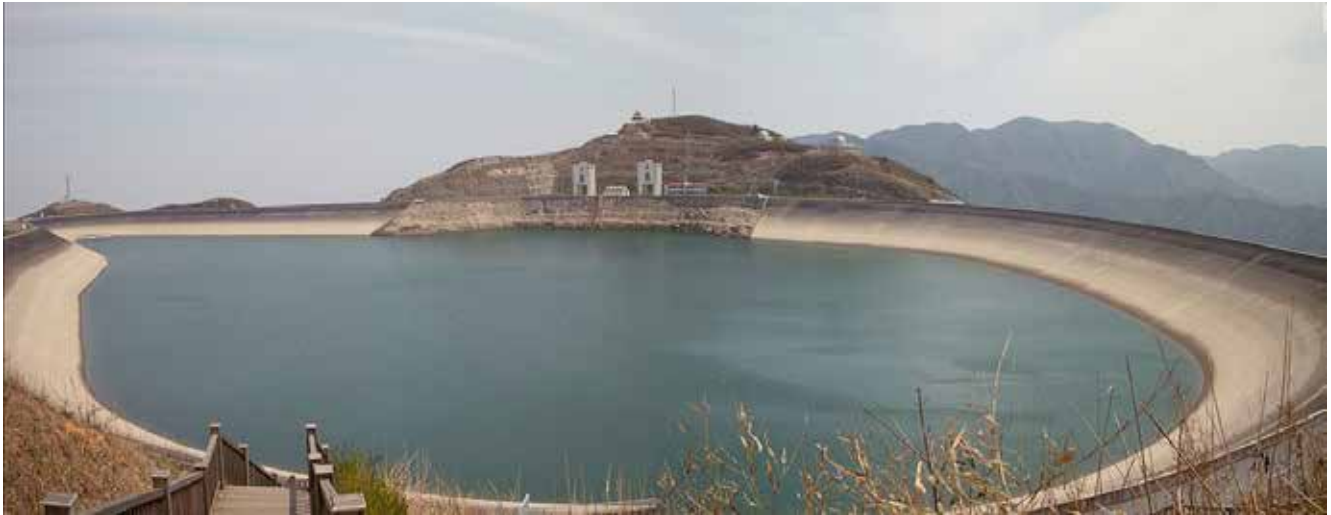
Øvre basseng på Tianhuanping klemte inn mellom tre bergtopper, mye gjort av FCB, de bitumenbelagte topplagene ble utført med assistanse av tyske Strabag. Foto: FCB
