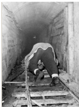
Innstøpt del av sjakten.
