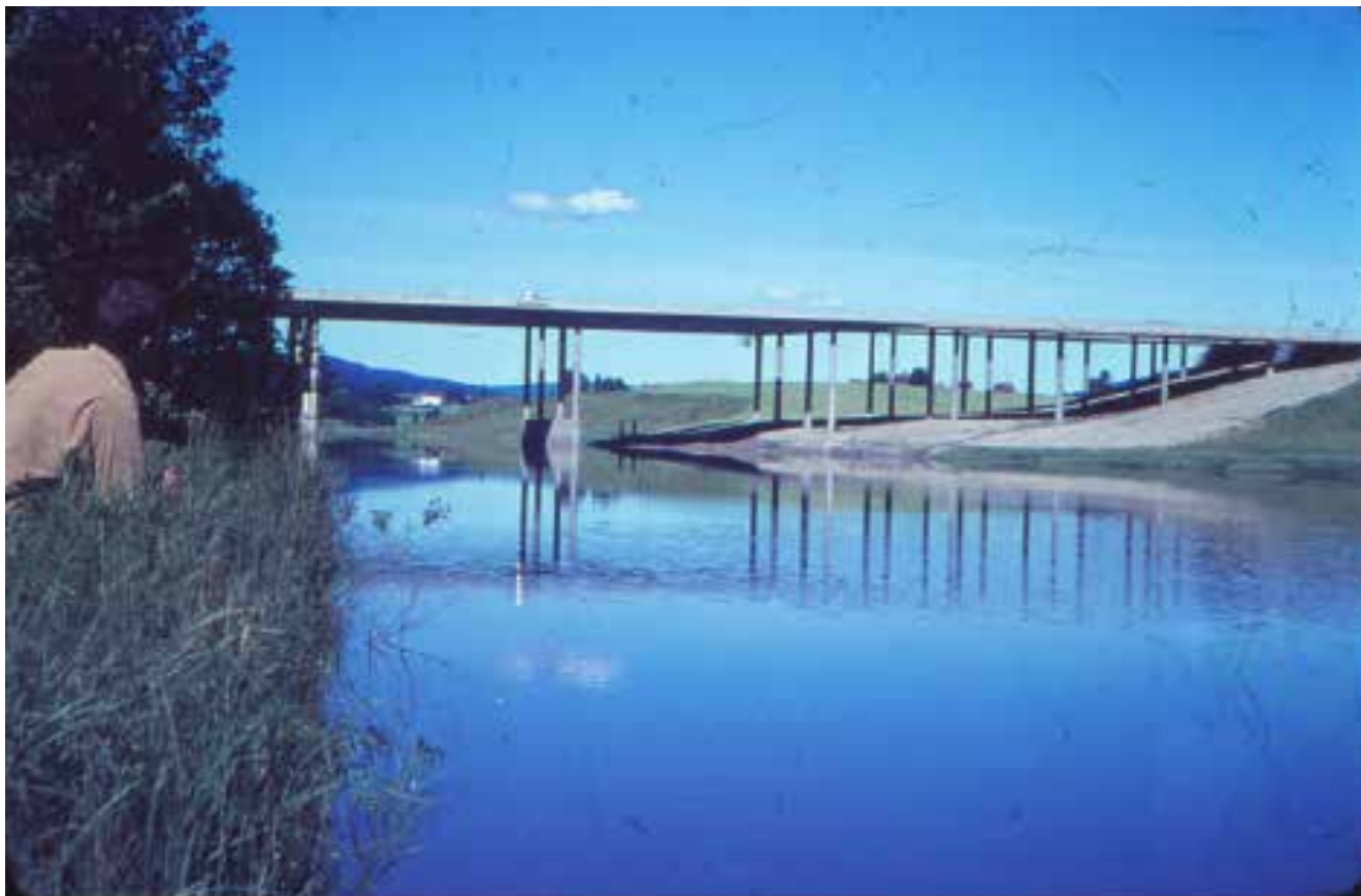
Nitelva bru - konstruktør Olav Olsen var kjent for sine slanke søyler direkte opp i bruplata.
