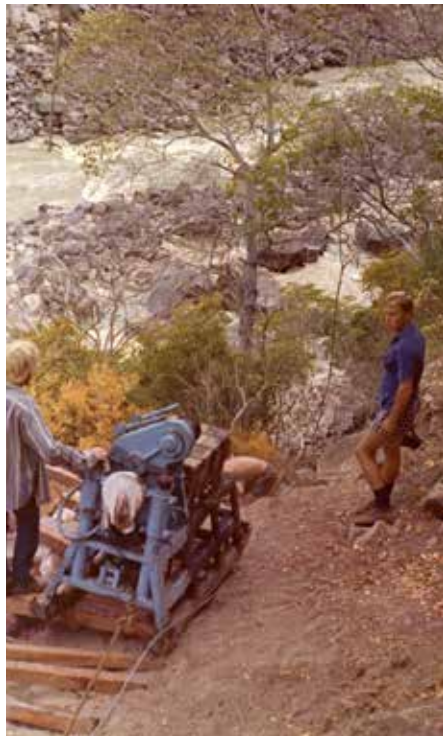
Kjernebormaskin på veg ned til damstedet.
