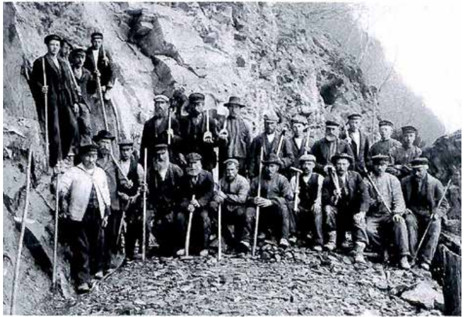
Arbeidsstokken i pent antrekk samlet til fotosesjon. Før 1940 manglet Vegvesenet stort sett maskinelt utstyr. Hjelpemidlene var håndholdt redskap, fysisk arbeid, komplett mangel på verneutstyr.
