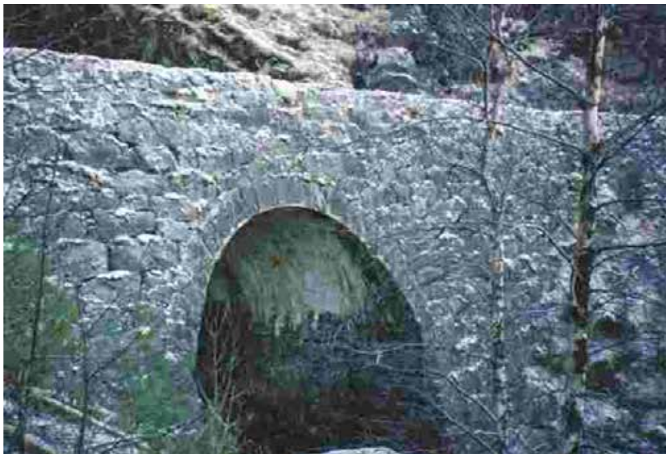
Natursteins hvelvbru med 10 m lysåpning. Foto Liv Marit Rui / Statens vegvesen.
