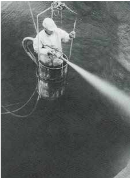
Sikrer et rasfarlig område for NSB, Dovrebanen ca. 1965. Ros fra Byggherren for utførelsen, Arbeidstilsynet noen år senere brukte bildet til skrekk og advarsel, «Kurven» var festet med kjerringknuter. Foto: Entreprenørservice
