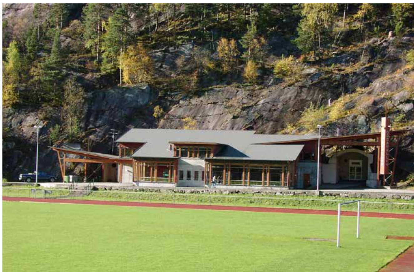
Oddahallen. Inngangsparti ved Odda stadion. Til høyre ser vi inngang til skyte- og løpebanen.
