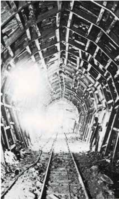
Arbeidskrevende tunneldrift Arbeidssikring tilpasset behov, fra stål, treverk til sprøytebetong Til venstre: stålbuer og treverk. Til høyre ferdig støpt. Alt arbeidskrevende!
