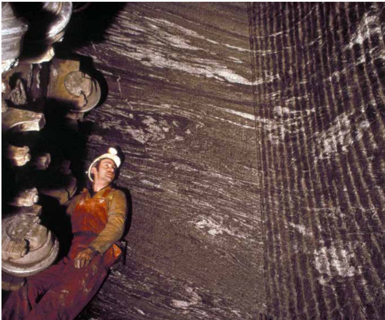
Overføringsstunnel 4,5 m diameter på Ulset kraft-verk med Robbins TBM 148-213. Foto: The Robbins Company
