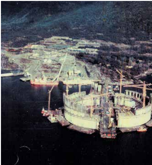
Ekkofiskveggen under bygging. Foto: Peconor
