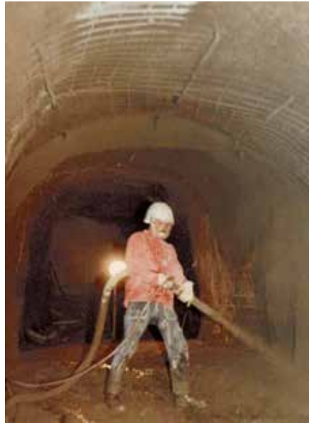
Sikrer et rasfarlig område for NSB, Dovrebanen ca. 1965. Ros fra Byggherren for utførelsen, Arbeidstilsynet noen år senere brukte bildet til skrekk og advarsel, «Kurven» var festet med kjerringknuter. Foto: Entreprenørservice
