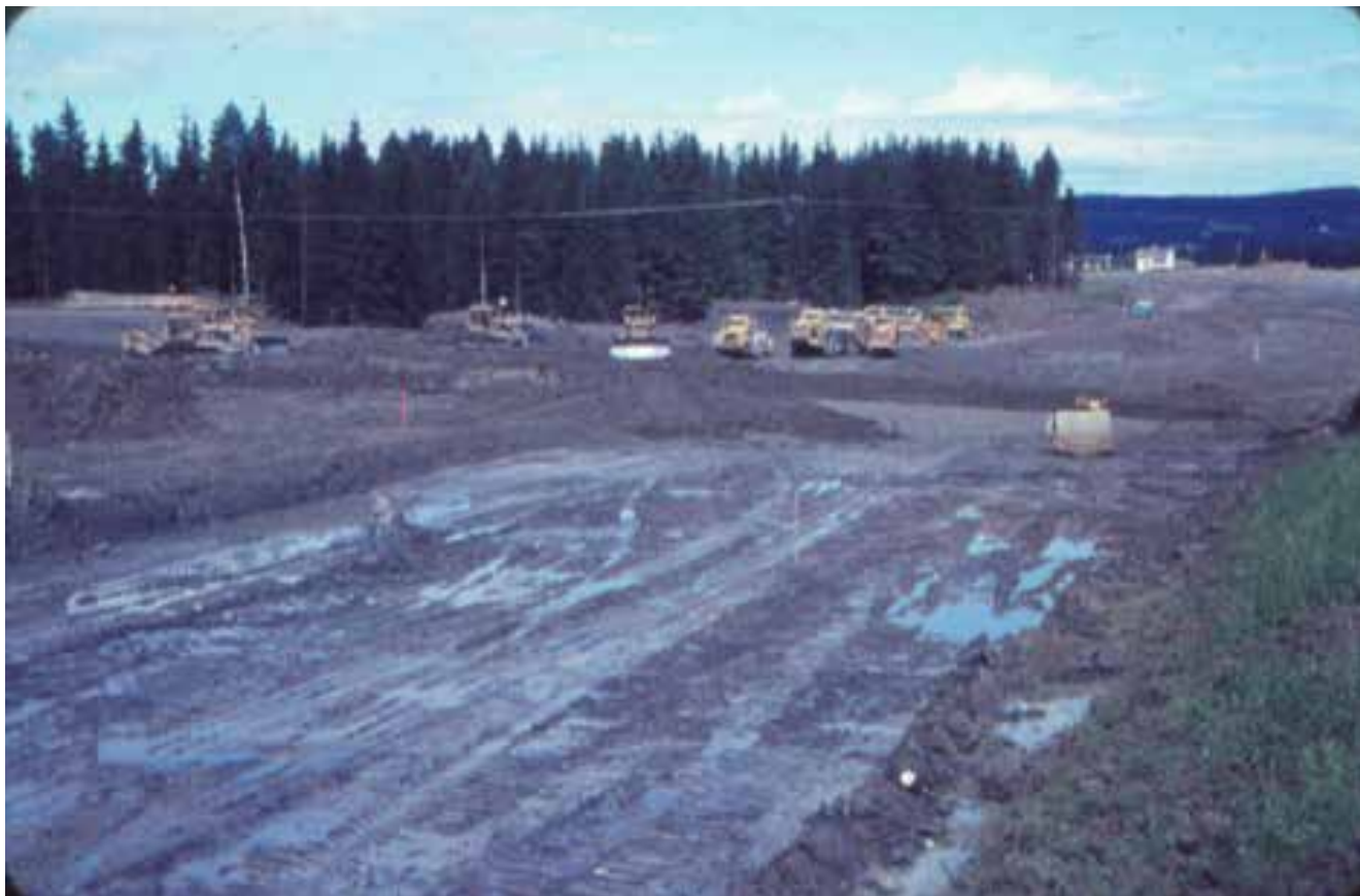
Det ble mange stopp i arbeidet på grunn av oppbløtt leire utover sensommeren og høsten.
