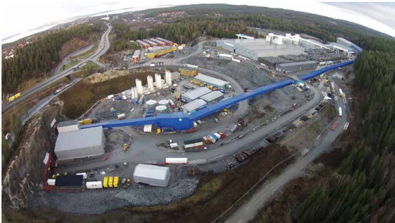
Dronebilde av anleggsområdet på Åsland. Foto: Bane NOR
