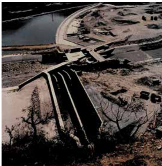
Foto: Sedimentkamrene ved inntaket for Jimruk kraftverk. Dette er sedimentkamre som tømmes ved hjelp av en slange over spalten i bunnen. Når den fylles med luft flyter den opp og åpner spalten. Kalt Sediment Sluicing System utarbeidet av Håkon Støle.
