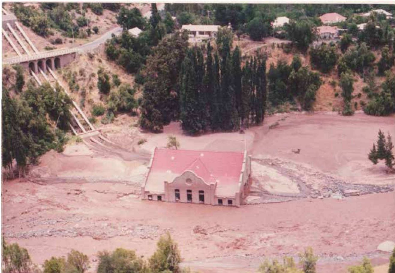
En eldre kraftstasjon nedstrøms Alfalfal begravet etter «aludd» i november 1987.
