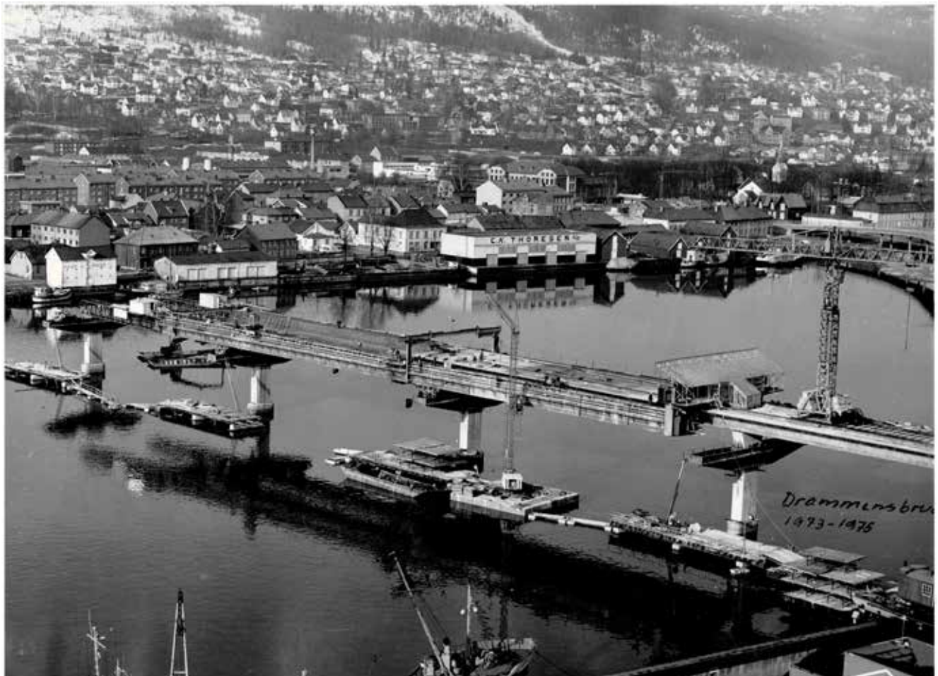
Bilde viser stillasvogn for framskyving. Den sentrale enheten for bygging av brobanen.
