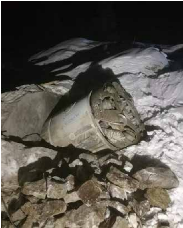
Gjennomslag på Holen kraftverk. Foto: Hardanger Maskin AS
