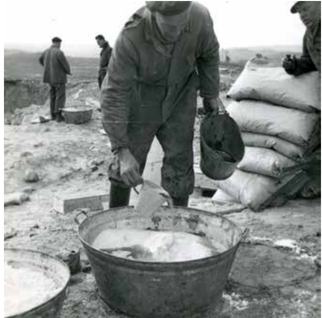
Bruk av Anfo i ein tidleg anleggsperiode. Ammoniumnitrat ispedd diesel kom i 50-åra. Foto Jostein Granli
