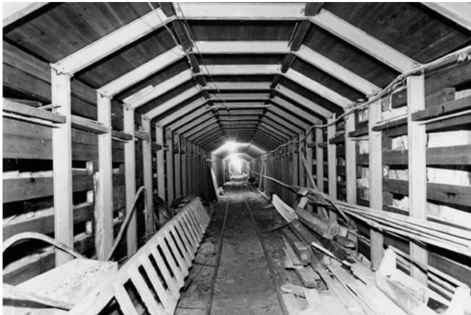
Tunnel ut til "Tuddalstippen" under bygging og i dag.
