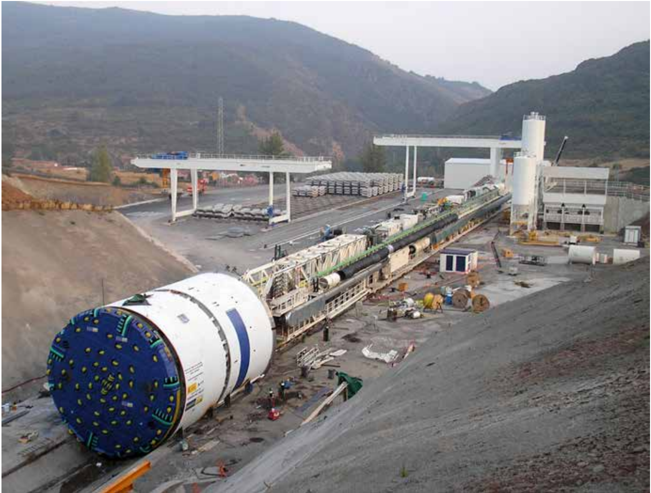
10,2 m diameter dobbeltskjoldmaskin med tilhørende bakrigg under montering. I bakgrunnen lager for betongsegmenter. Foto: Herrenknecht AG
