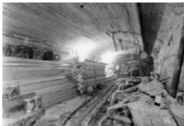
Betongarbeider med full innstøping av en av fjellhallene.
