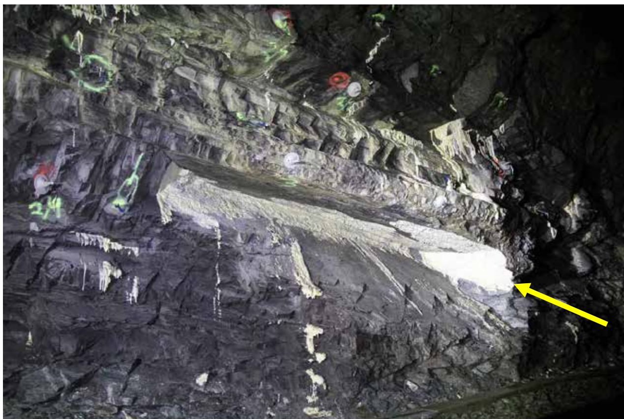
Figur 2: I dette partiet forekom det et nedfall av en stor blokk (gul pil). Den manglende blokken gir et innblikk i hvordan injeksjonsmasse er fordelt utover sprekkeplan. Fjellsikring ble utført først etter nedfall.
