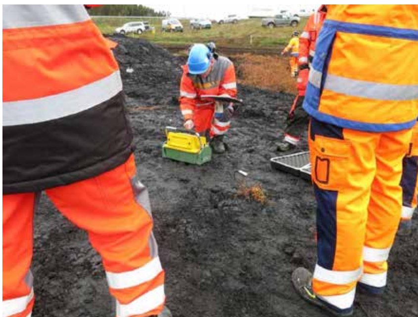
Fig. 9 Troxler-måling for kontroll av komprimeringsgrad
