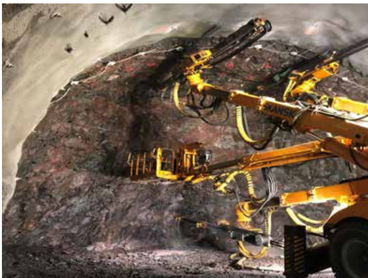
Fig 9. Boring på stoff.
