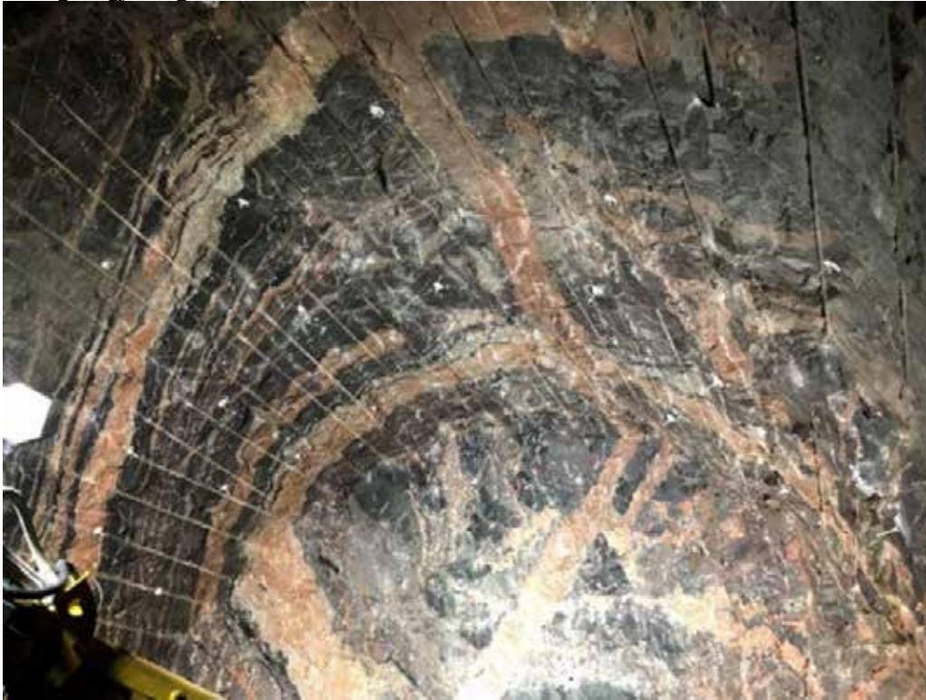
Figur 1 Kontur etter salve i skiftende berg. Foto: Torodd Kolbergsrud
