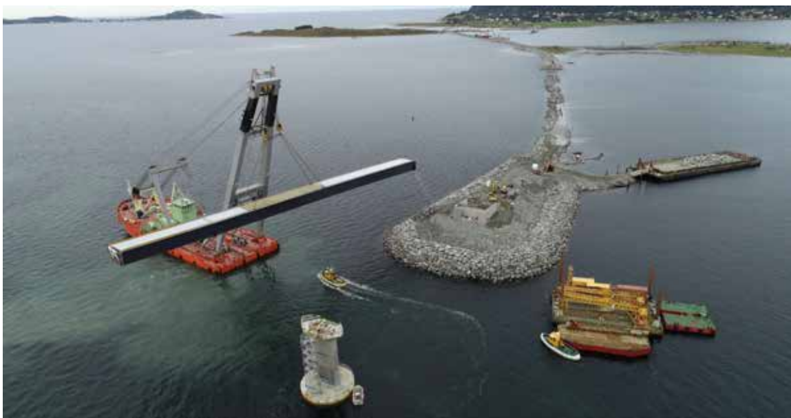
Fig. 3. Første stålelement på Lepsøybrua løftes på plass av kranlekter «Uglen»
