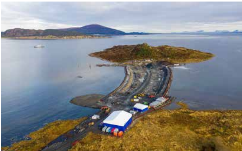
Fig. 8. Start på tunneldrivingen på Hestøya og rensk av havbunnen for etablering av fundament for de permanente demningene. (Foto:Skanska)
