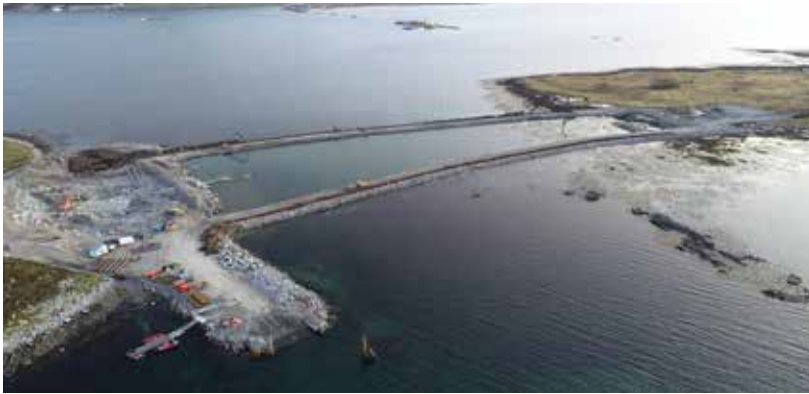
Fig. 7. Etablering av de midlertidige «spuntede kofferdammene».
