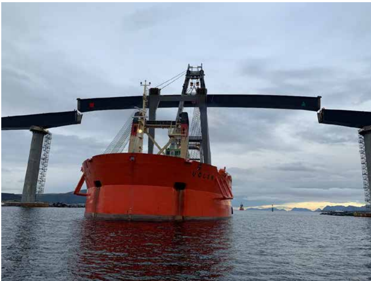
Fig. 4. Siste og syvende seksjon straks på plass.
