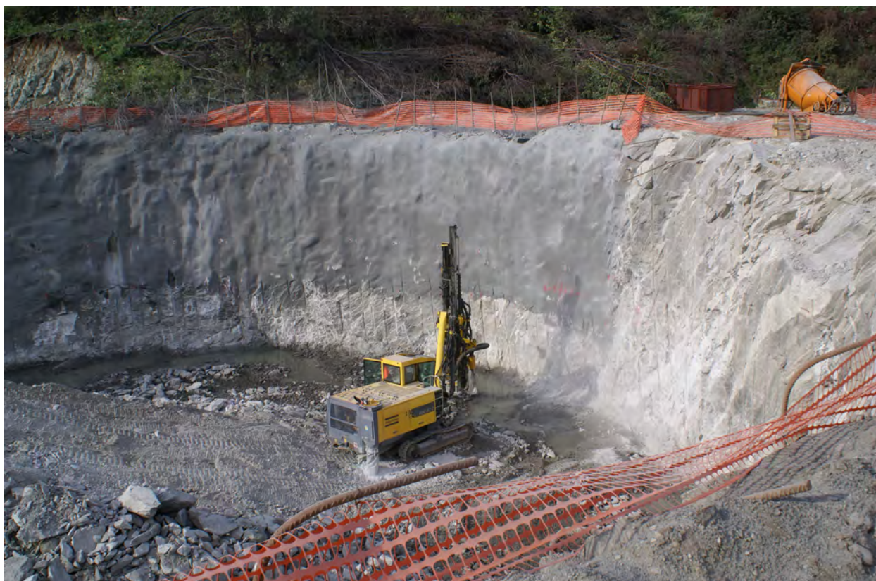
Bilde19.1 Boring av synk (Foto: LNS AS)
