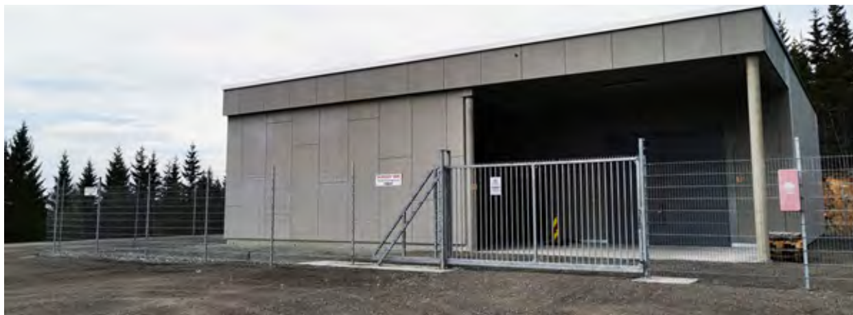
Bilde 8.2. Lager med riktig gjerde og skilting (Foto: Letnes Fjellsprengning)
