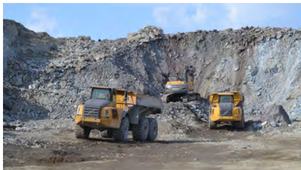
Bilde 18.1 Lasting av salve (Foto: LNS AS)
