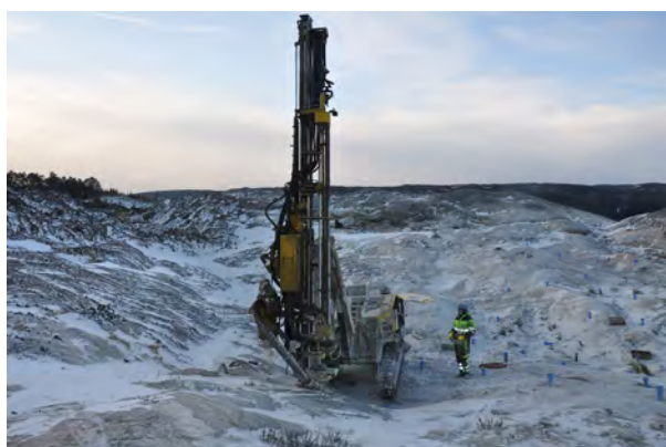
Bilde 13.1 Boring (Foto: Glenn Seland)
