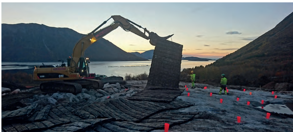
Bilde 16.1 Dekking av salve (Foto: Austin Powder)
