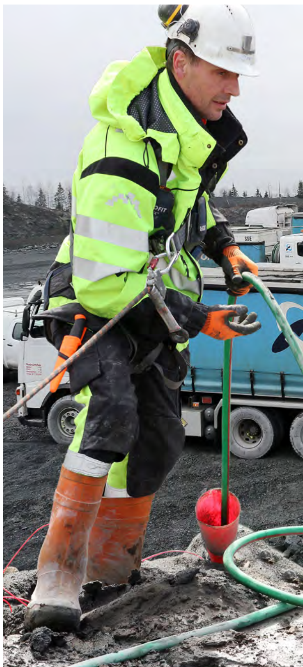
Bilde 15.1 Lading med emulsjon (Foto: Orica)
