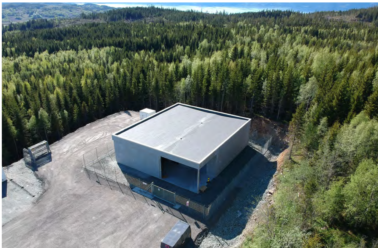
Bilde 8.1. Lager med riktig avstand til vegetasjon (Foto: Letnes Fjellsprengning)
