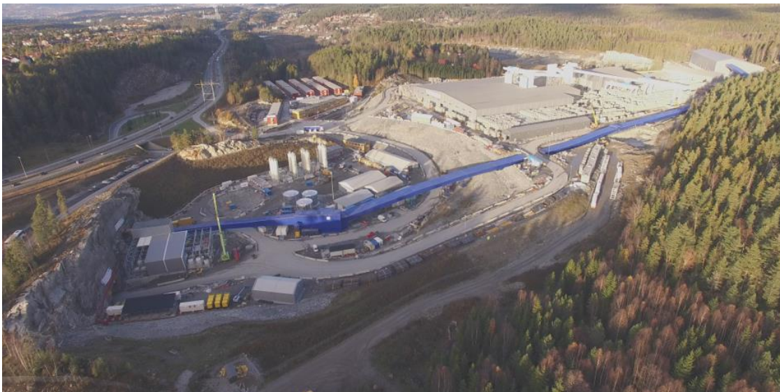
Figur 10. Oversikt over riggområdet hvor det tildekkede transportbåndet (blått) går fra tunnelmunningen ved E6 til Spoil shed lengst til høyre i bildet (bilde: Bane NOR).
