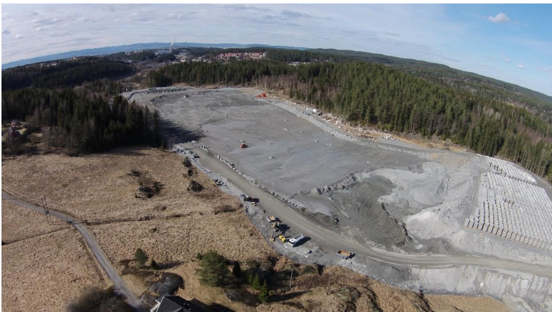
Figur 9. Oversiktsbilde av fylling ved Follobanen (bilde: Bane NOR).
