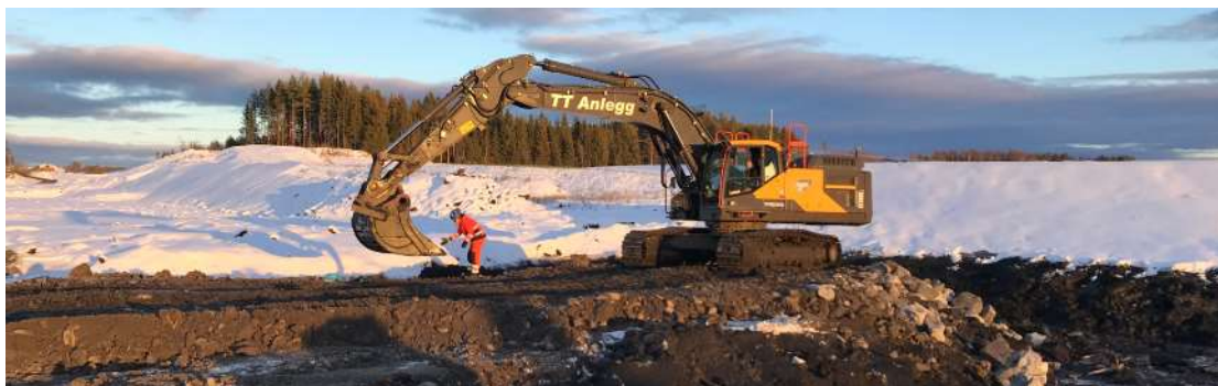
Fig. 4 Innhenting av graveprøver før uttak av en skjæring
