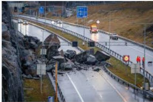
Raset på E18 ved Larvik: Motorveien stengt på ube... veier24.no
