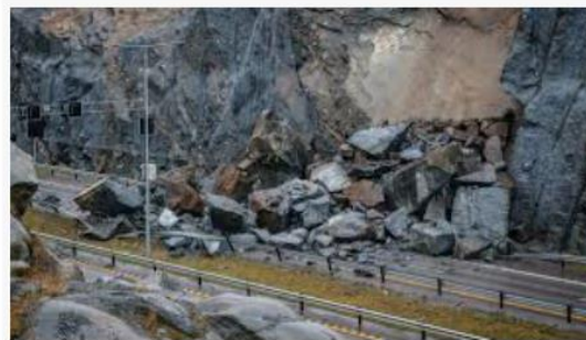
E18-raset: Politiet skal undersøke om det har skjedd ... agderposten.no
