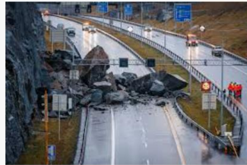
Mangelfull sikring var årsaken til raset på E18 i Lar... vg.no
