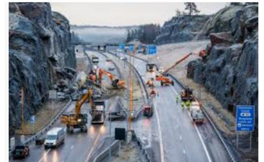
Fjellskjæringer langs E18 sjekkes etter ras fvn.no
