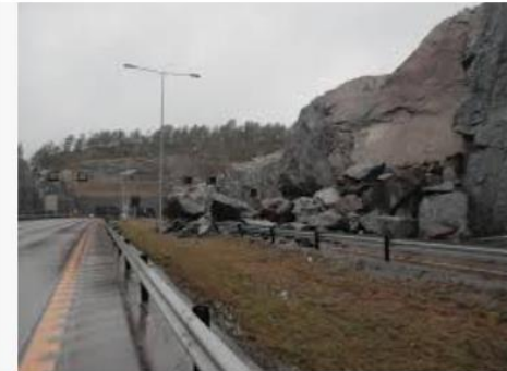
Raset på E18: Veien åpner trolig ikke før i slutte... vg.no
