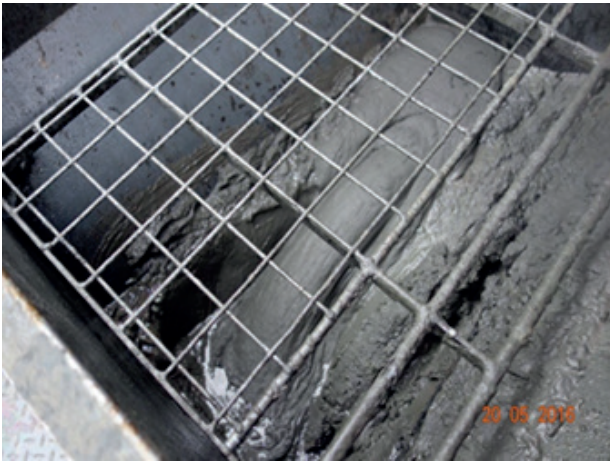
Figur 4.11 Riktig blandet gysemasse i blandekar til gysepumpe, foto Terje Kirkeby
