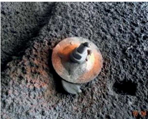
Figur 4.12 Full oppfylling av hull og kombinasjonsbolt, foto Terje Kirkeby
