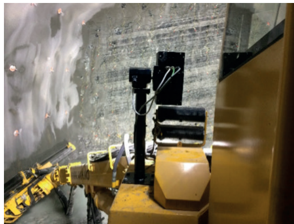
Figur 7.13. Det kan dokumenteres enten med et håndholdt kamera, her et nettbrett (t.v) eller med et fastmontert kamera på en bore- eller sprøyterigg (t.h).
