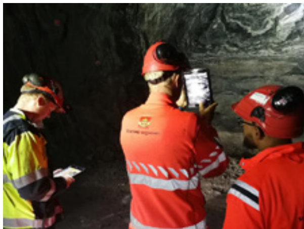
Figur 7.13. Det kan dokumenteres enten med et håndholdt kamera, her et nettbrett (t.v) eller med et fastmontert kamera på en bore- eller sprøyterigg (t.h).
