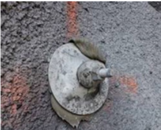
Figur 4.13 Bolt i skjæring før plate er strammet til, dette skjer etter at mørtelen er herdet, foto Terje Kirkeby
