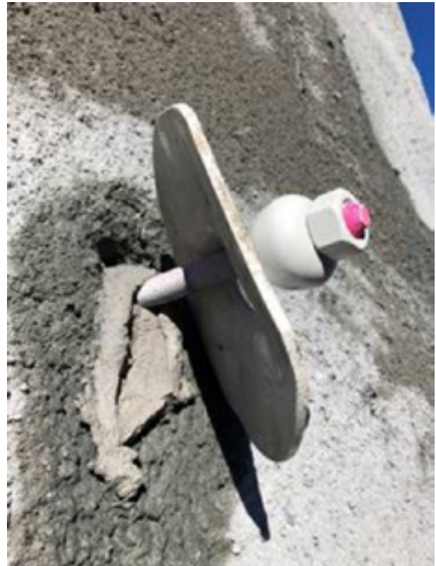
Figur 4.13 Bolt i skjæring før plate er strammet til, dette skjer etter at mørtelen er herdet, foto Terje Kirkeby
