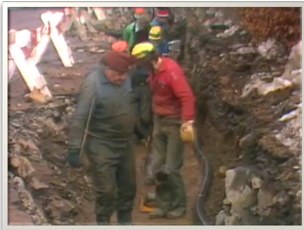
Kabeltrekking i grøft i Oslo for 60 år siden
