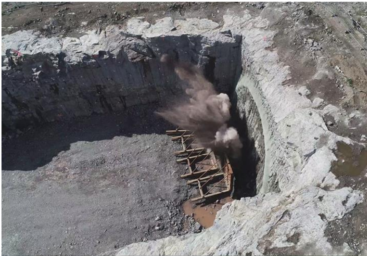
Første tunnelsalve gikk som planlagt ved Gråmunktunnelens søndre portal. Foto: Jan Morten Roberg
