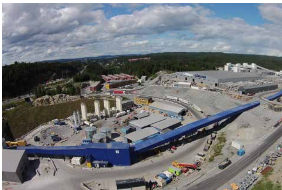
18,5 kilometer av den lange tunnelen produseres fra dette anleggsområdet på Åsland, der tunnelmasse gjenbrukes som del av byggegrunn for en ny bydel Gjersrud-Stensrud.
