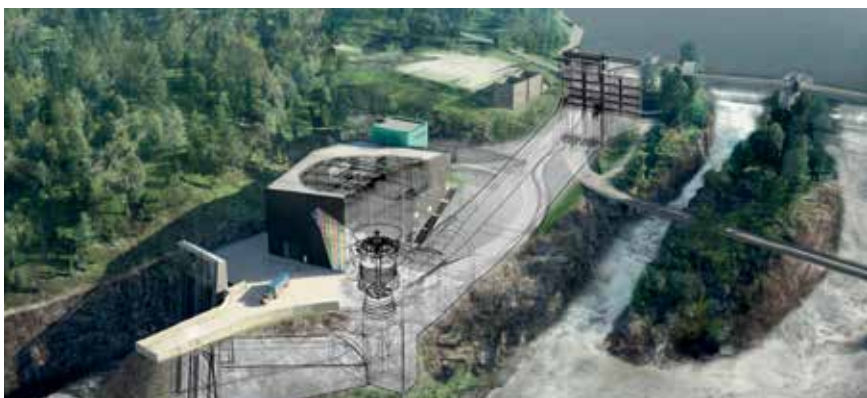
BIM brukes på utvidelsen av Vamma kraftverk i Østfold.
