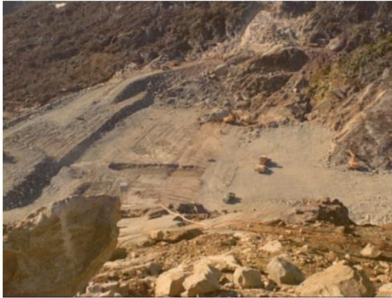
Figure 16 : Construction of the Forsvæn Dam 1976-1979 (J. Rohde 1977).
