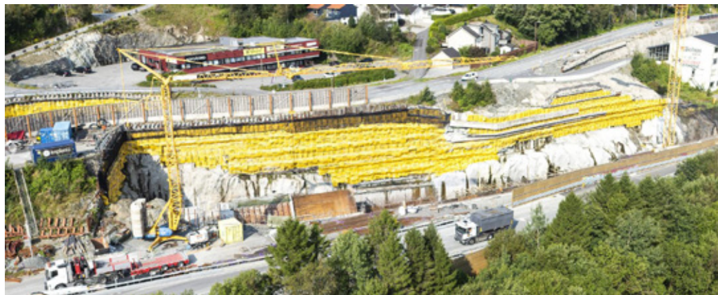
Figur 11: Ferdigstilt utgraving. Bilde tatt 2019-08-27 (foto: Statens vegvesen)
