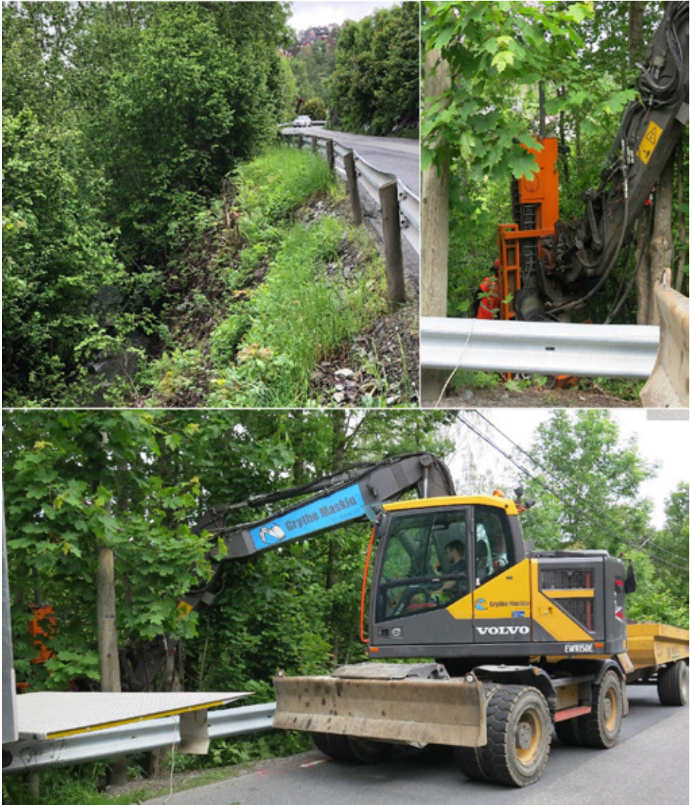
Figur 11 Bildene er fra Fv. 8 Bødalen. Bildet øverst til venstre viser fyllingen som skulle undersøkes for mulig etablering av mur. De andre bildene viser undersøkelsene.
