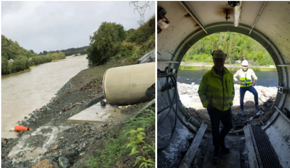
Figur 30: Ferdigpresset rør. Utløpet er ikke ferdigstilt.
