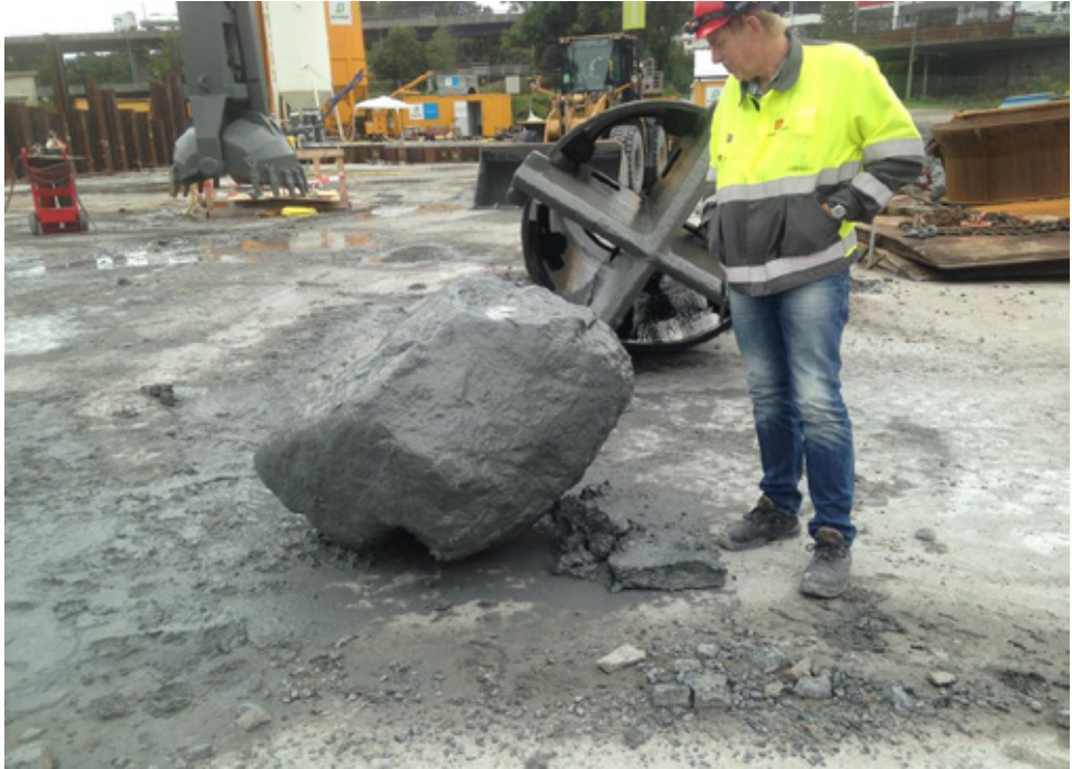
Figur 14: Blokk som er tatt opp i akse 7. Foto: Statens vegvesen
