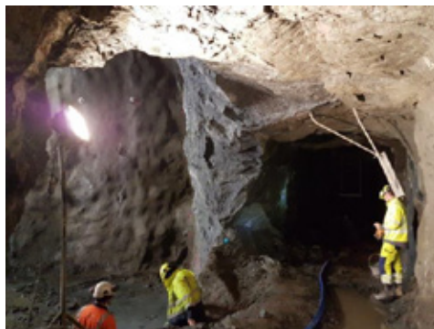
Figur 15: Rømningsstunnelen hadde et tverrsnitt på ca. 8m 2 .
