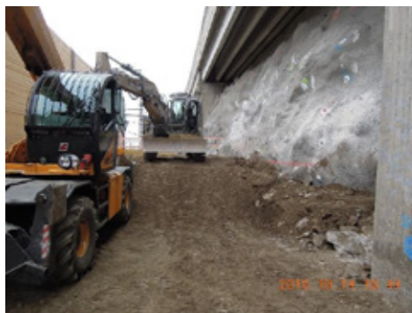
Figur 17: Sikring av fjellet under E18.
