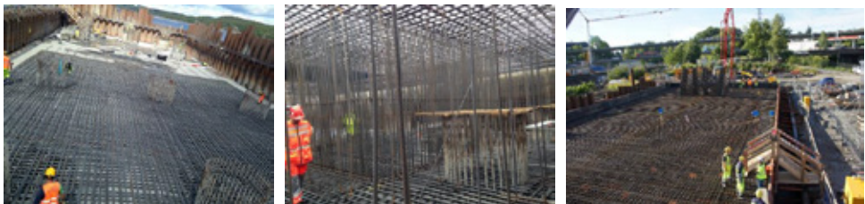
Figur 15: Fundament akse 7. Foto: Statens vegvesen
