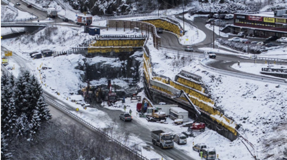
Figur 6: Forskjæring under utførelse pr. 2017-12-12 (foto: Statens vegvesen)
