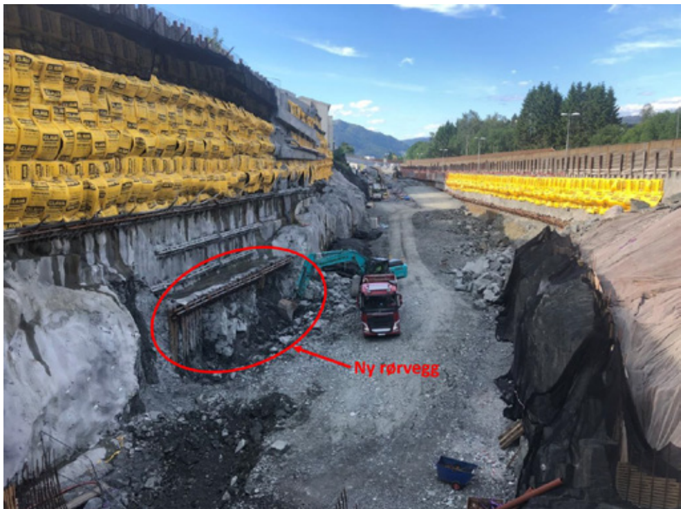
Figur 10: Ferdig etablert rørvegg (foto: Jarl H. Christensen, Implenia)
