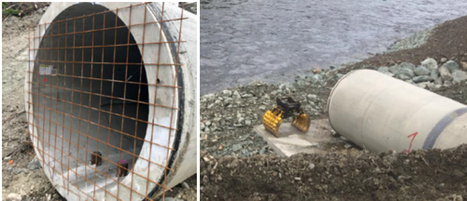
Figur 29: Utløp med betongplate og bolter. Bilder mottatt fra Steg entreprenør 20.09.19
