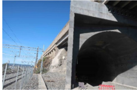
Figur 19: Søndre Portal ferdigstilt.
