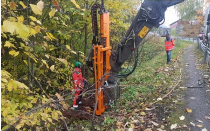
Figur 7 Asdøla bru borpunkt 1007.
