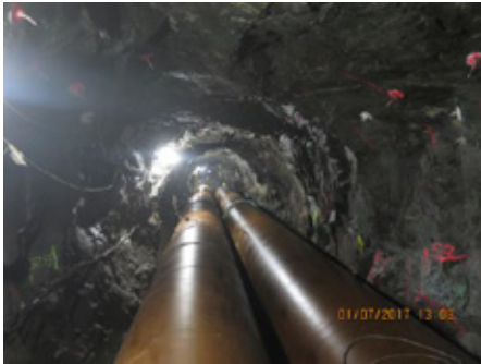
Figur 6: Rørene er installert over Inngående og Utgående Follobane.
