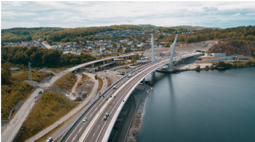
Figur 19: Oversiktsbilde Farrisbrua. Foto: Rambøll/Aleksander Ribe
