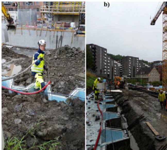
Figur 6: a) Viser installasjon av en av SAAF instrumentene (INC3) hvor det føres av trommelen og ned i inklinometerkanalen på spunt. b) Viser pågående koblingsarbeid i loggerskap 13. september 2017. Foto: Cautus Geo
