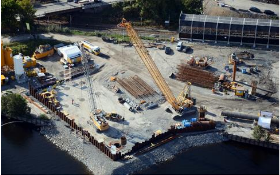
Figur 9: Anleggsområdet for akse 7 (og 8). Foto: Statens vegvesen
