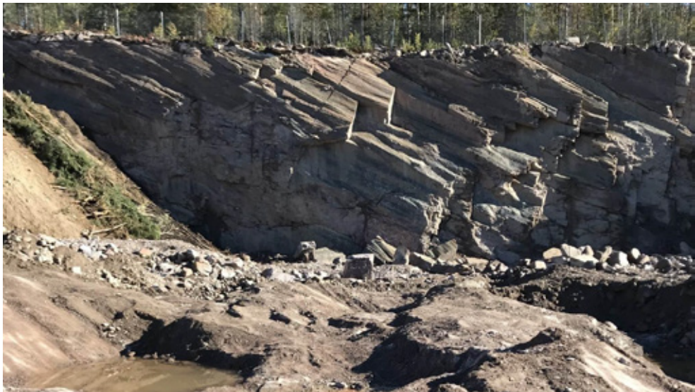
Figur 3. Eksisterende skjæring i steinbruddet. Sprengingsområdet er i front på bildet. Bygningene ligger utenfor bildet til venstre.
