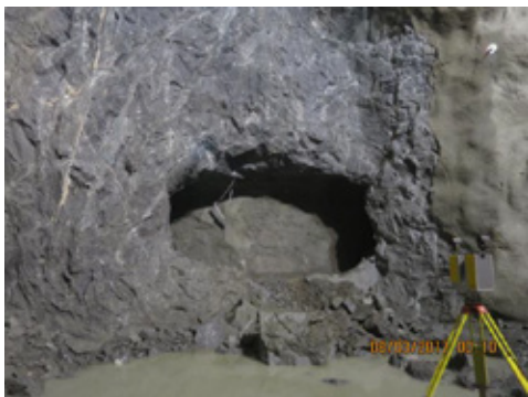
Figur 14: Det ble sprengt forsiktig forbi rømningsstunnelen.
