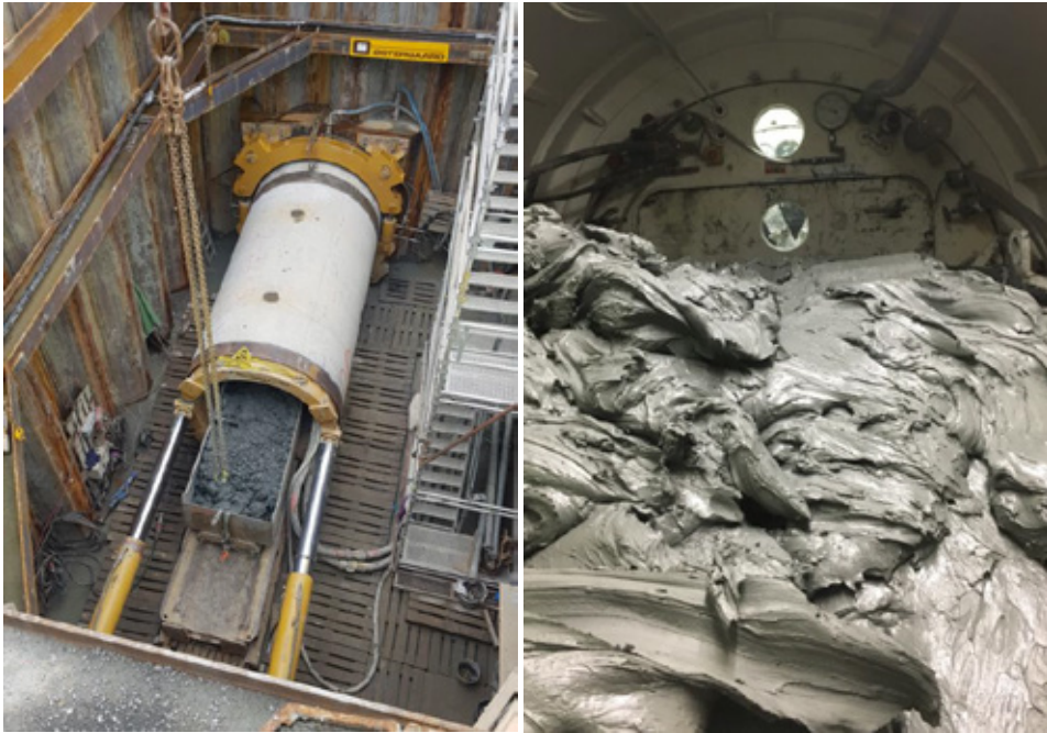
Figur 17: Vogn med utgravde masser, fra utsiden og fra slusekammer på innsiden
