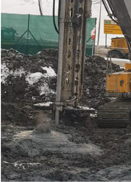
Figur 12: Injisering av multicem, visp med Ø800
