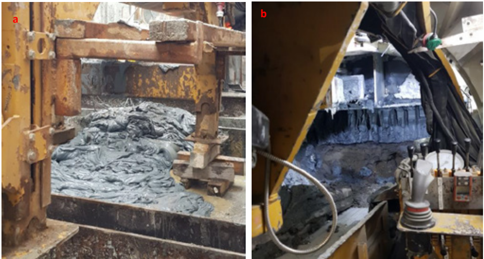
Figur 22: a) Stedlige masser fra område med pilotboring, b) Fra bløt, til lagdelte og harde masser under tunnelering
