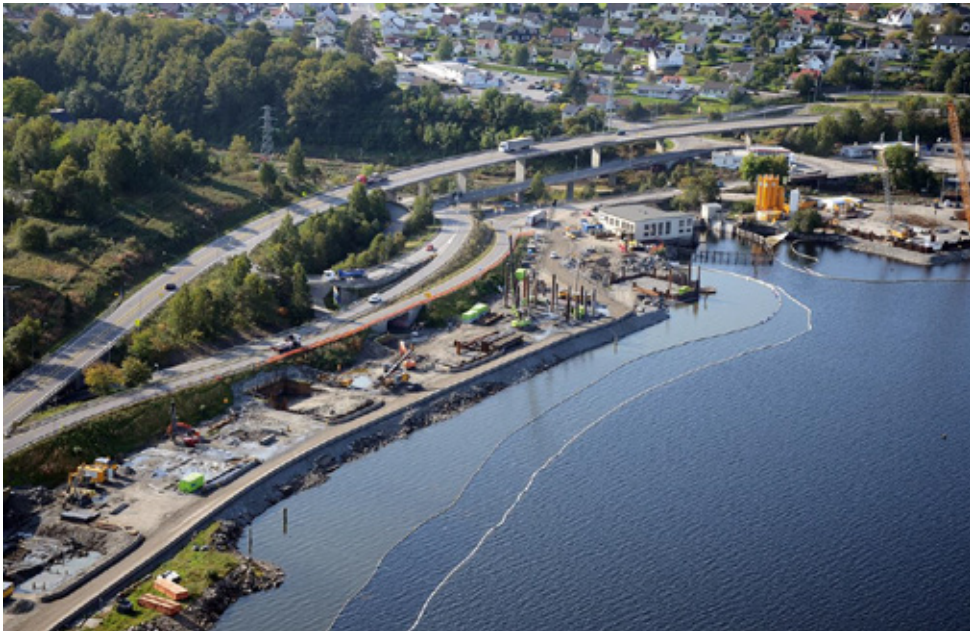
Figur 8: Anleggsområdet med siltgardiner. Foto: Statens vegvesen
