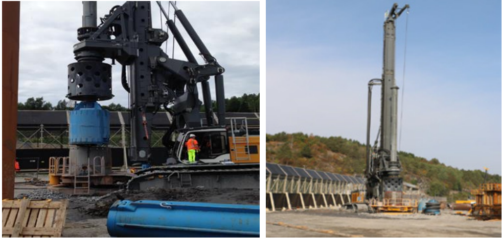
Figur 18: Borerigg som ble benyttet i akse 8. Foto: Statens vegvesen
