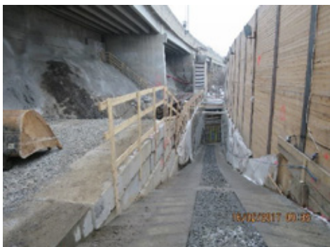
Figur 16: Adkomst vei til Søndre Portal.
