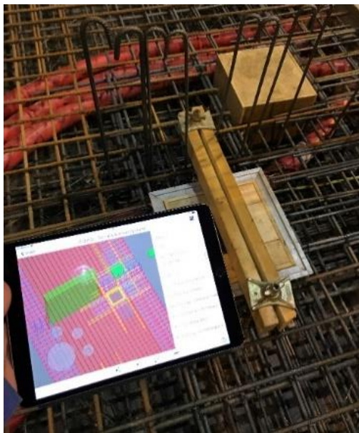
Figur 6: Kontroll av armering med modell på iPad før støp
