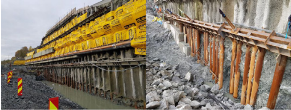
Figur 8: Rørveggen under utførelse (foto: S. Schanke, Norconsult)
