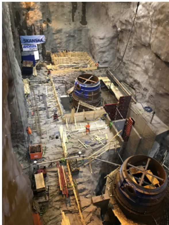
Figur 10: Fra byggin av sugerør i bunn av kraftstasjon. BIM-kiosk står i kontainer under bannere.
