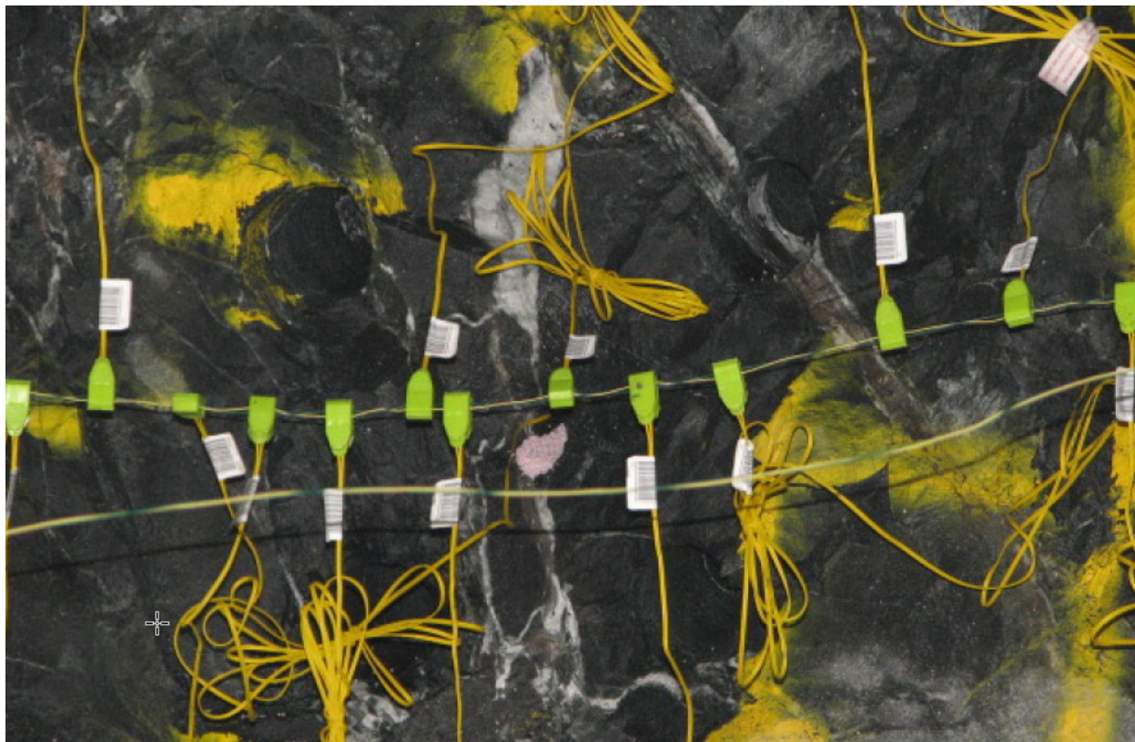
Figur 13. Tenner kobles til harness-wire med en koblingsblokk
