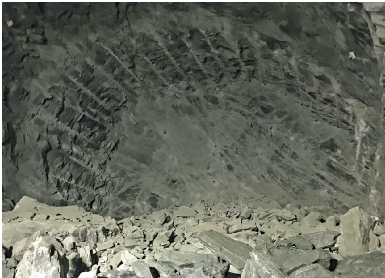
Figur 28. Et godt sprengningsresultat med elektroniske tennere i dårlig berg med varierende sprengbarhet (Nedre Otta Kraftverk)
