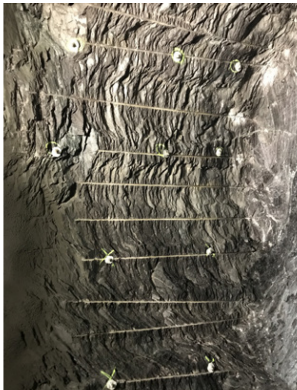
Figur 24. Kontur skutt med elektroniske tennere etter rensk [13].
