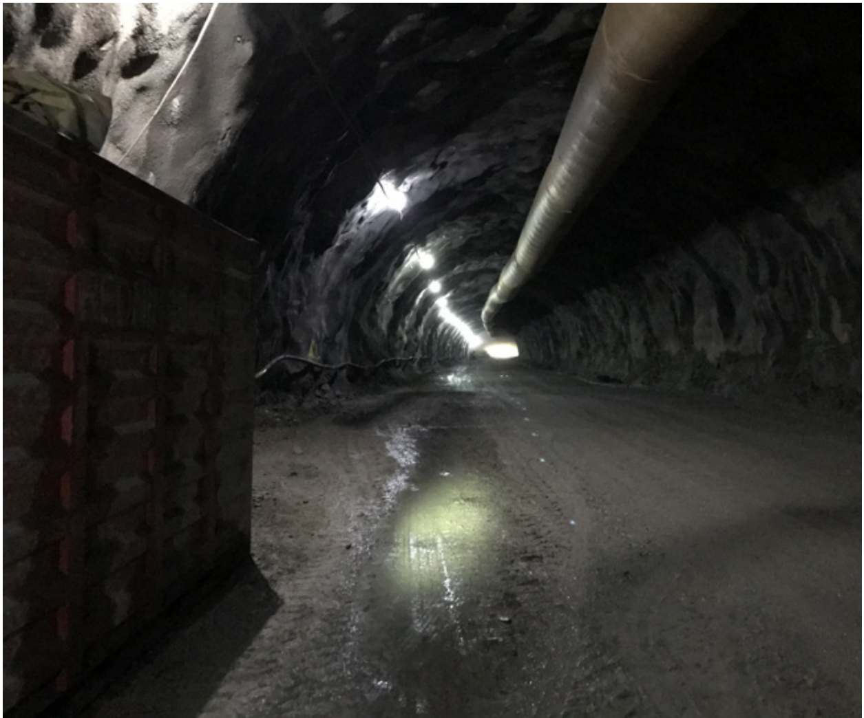
Figur 22. God sikt fem minutter etter avfyring av salve med elektroniske tennere i en avstand av 400 meter. Bagn-Bjørge [13].
