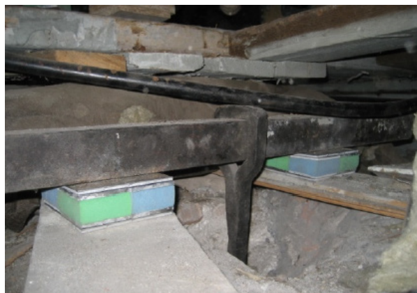
Figur 31. Damping av vibrasjoner ved hjelp av sylomer (Orica/Nitro Consult)
