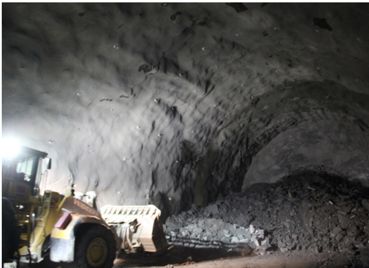
Figur 26. Godt berg og kontursprengning med eDev™ II elektroniske tennere gir flott kontur [13].
