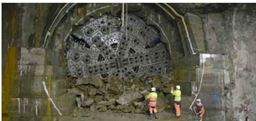
Figur 22 TBM som boret Hallandsås i Sverige er en kombinasjonsmaskin (Slurry/Enkeltskjold)
