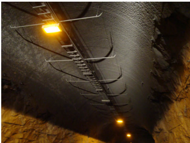
Figur 3 Boret heng og sprengte vegger i Fløyfjelltunnelen (Foto Pål Drevland Jakobsen).
