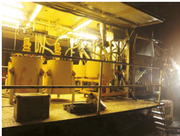
Bildet viser tømming av storsekk i silo på injeksjonsbil. Sementstøv kan skimtes til høyre i bildet.
