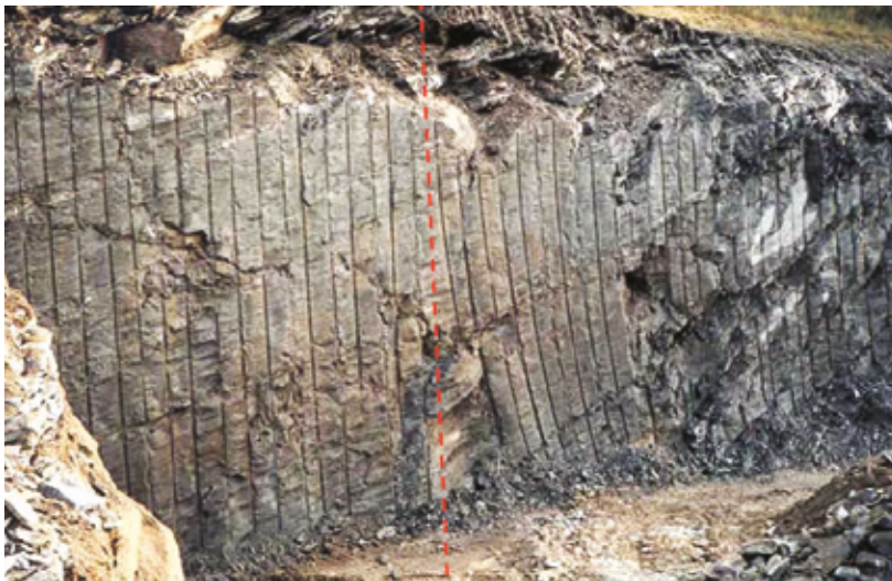
Figur 8 Boring med styrerør til venstre, uten styrerør til høyre (Foto: Sandvik).
