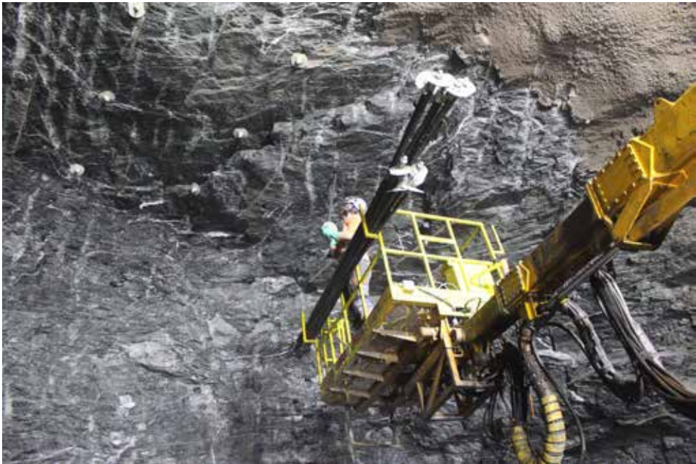
Bilde 9: Bolting (Foto: Skanska Norge)
