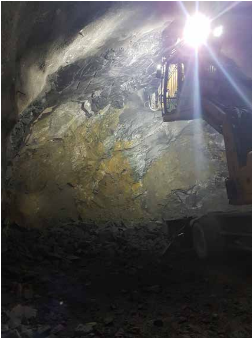
Bilde 7: Maskinrensk (Foto: Veidekke Entreprenør)
