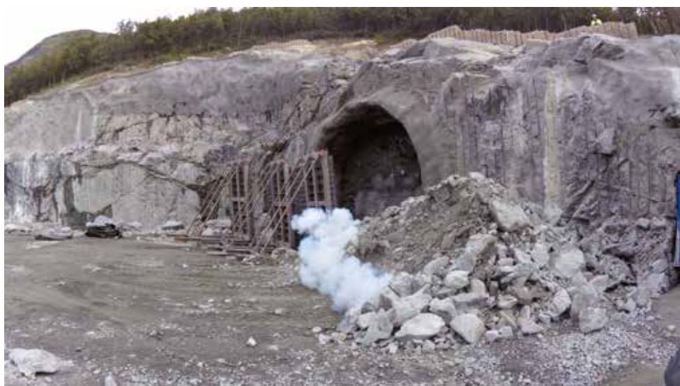
Bilde 2: Påhugg (Foto: Hæhre Entreprenør)
