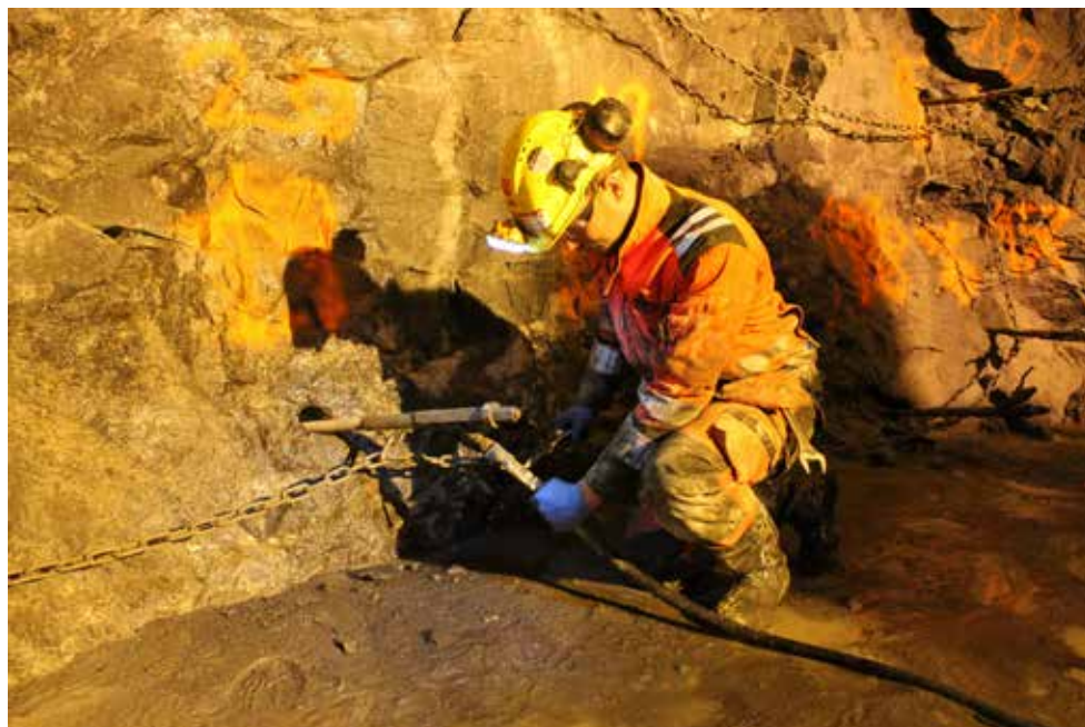
Bilde 3: Injeksjon (Foto: Veidekke Entreprenør)
