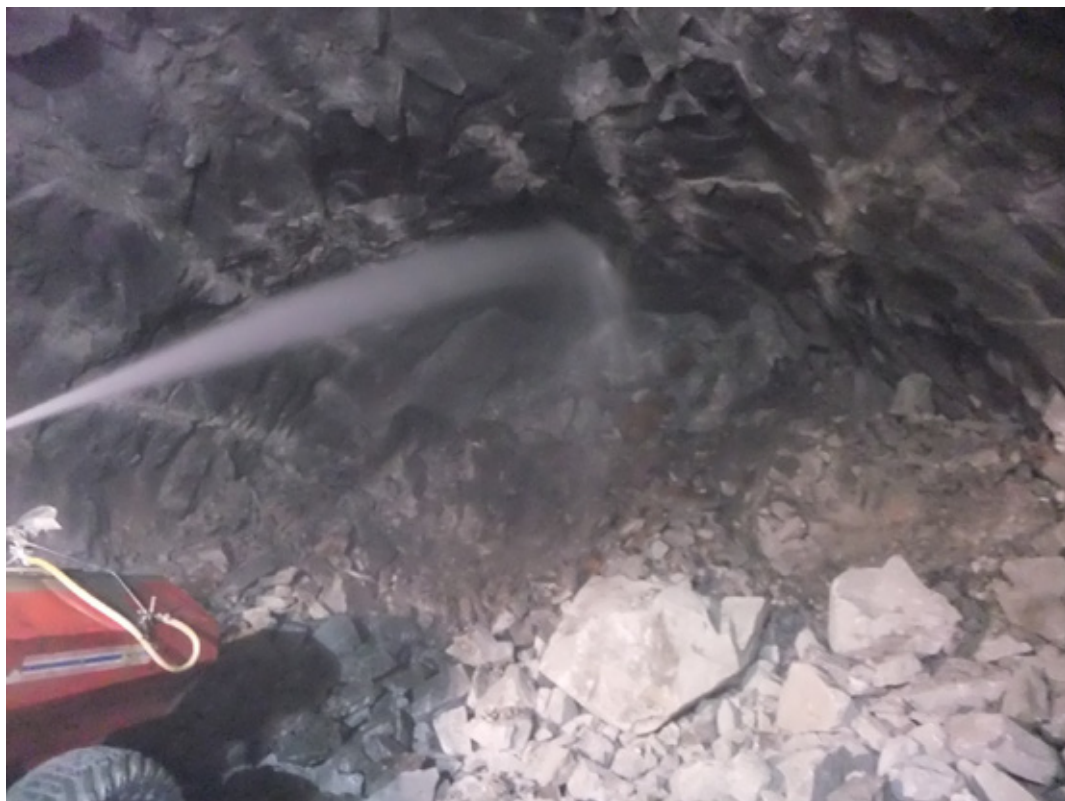
Bilde 2: Vannspyling på røys. Foto: Veidekke
