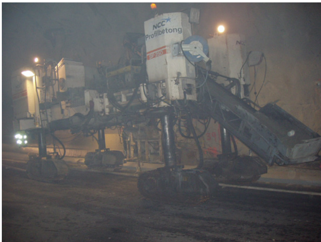
Bilde 6: Støp av rekkverk. Foto: AF Gruppen
