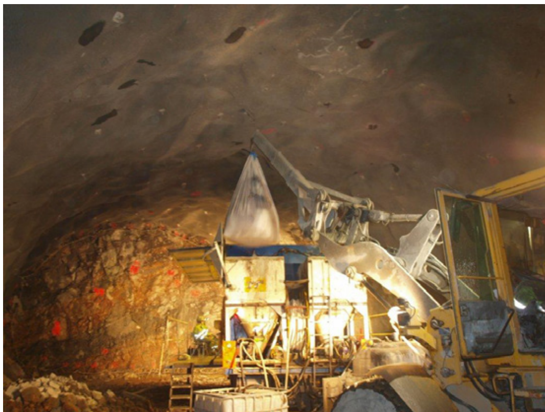
Bilde 1: Påfylling av sement i storsekk på injeksjonsrigg. Foto: Veidekke
