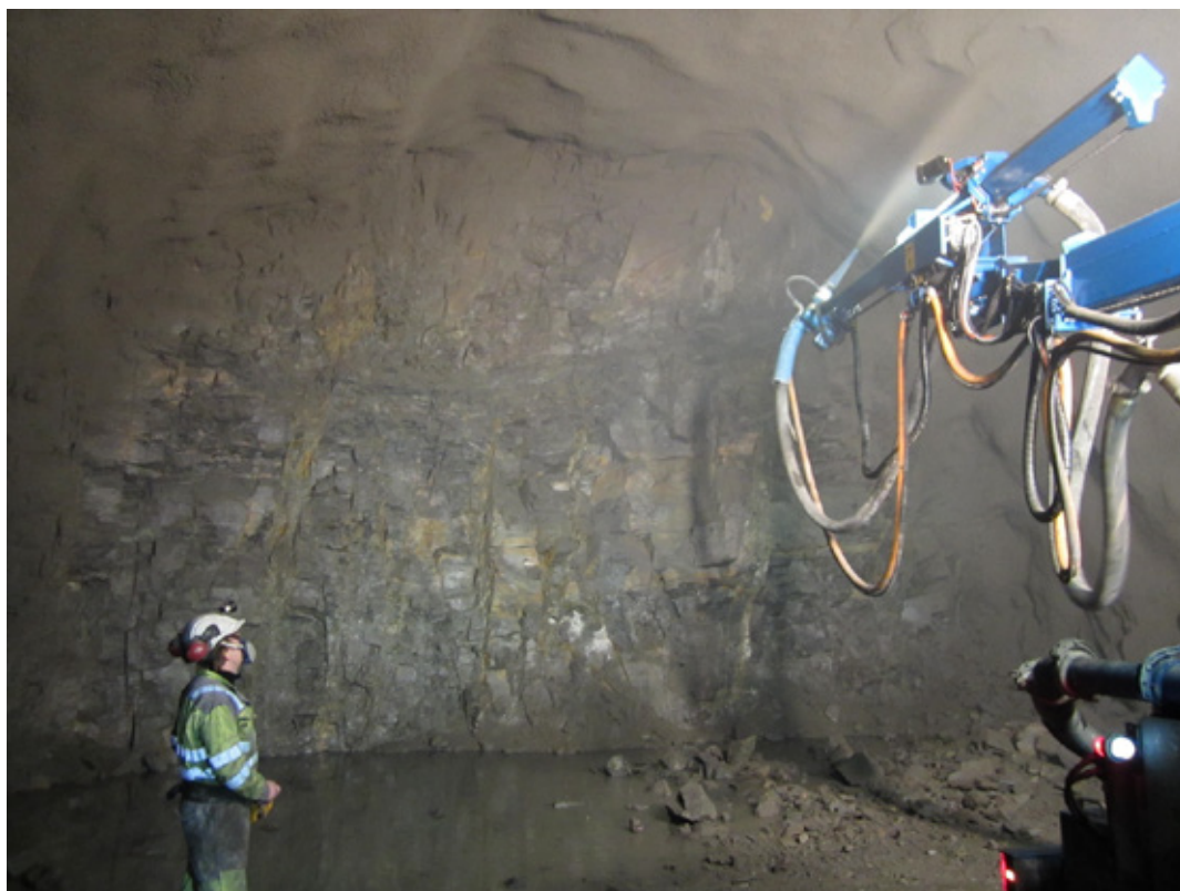
5: Sprøyterobot betjent med fjernstyring. Foto: AF Gruppen
