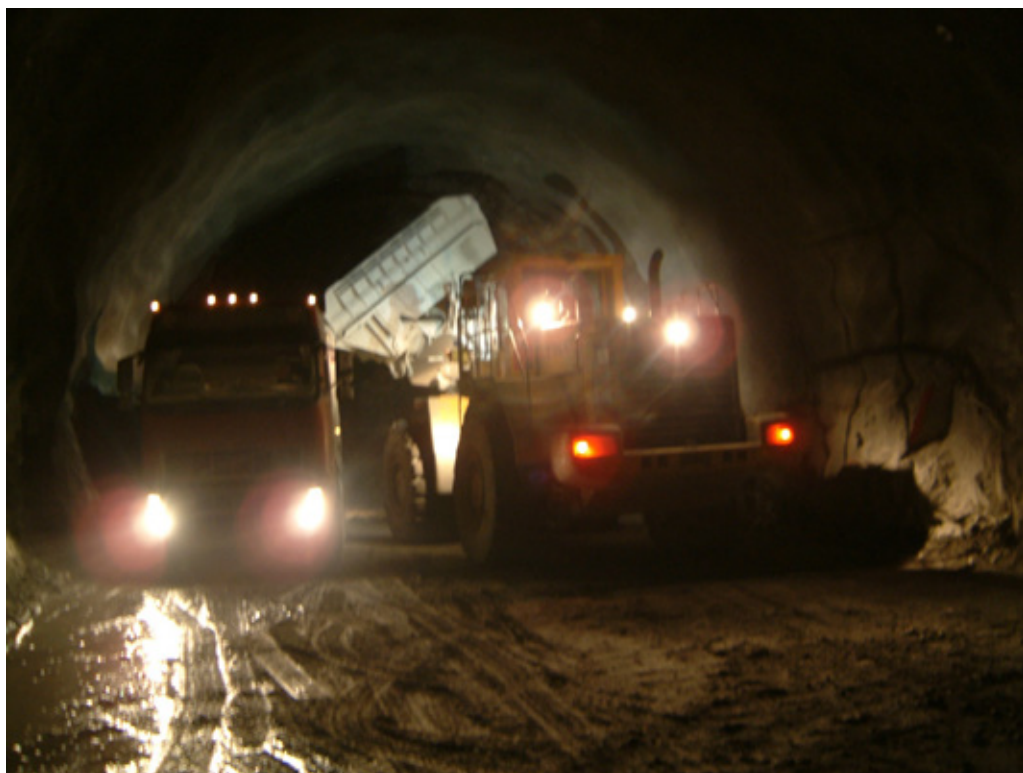
Bilde 3: Lasting på stoff uten støvdannelse. Foto: AF Gruppen
