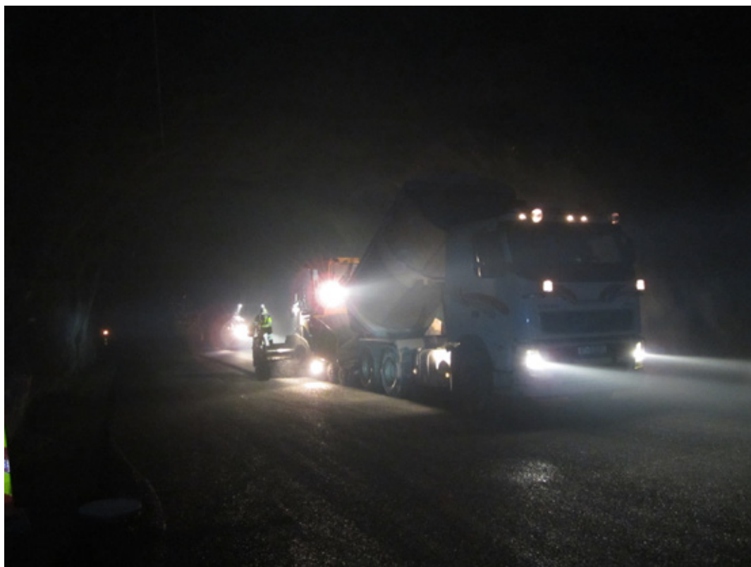
Bilde 7: Legging av asfalt. Foto: AF Gruppen
