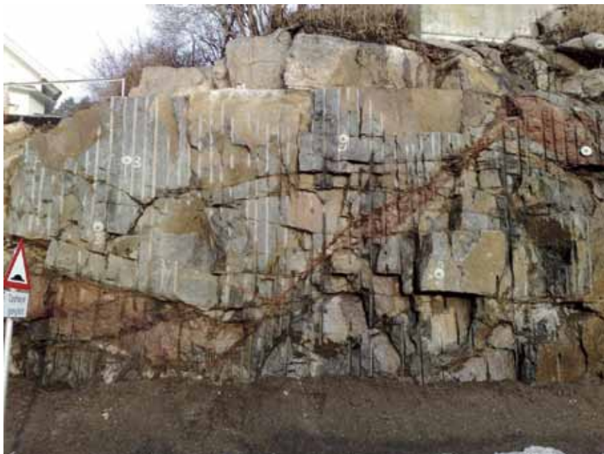
Figur: 5.6. Kombinasjon av sømboring og konturspregning. Foto: Jan Erik Blix
