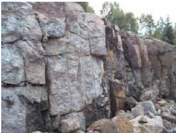
Figur 5.4. Kontursprengning
