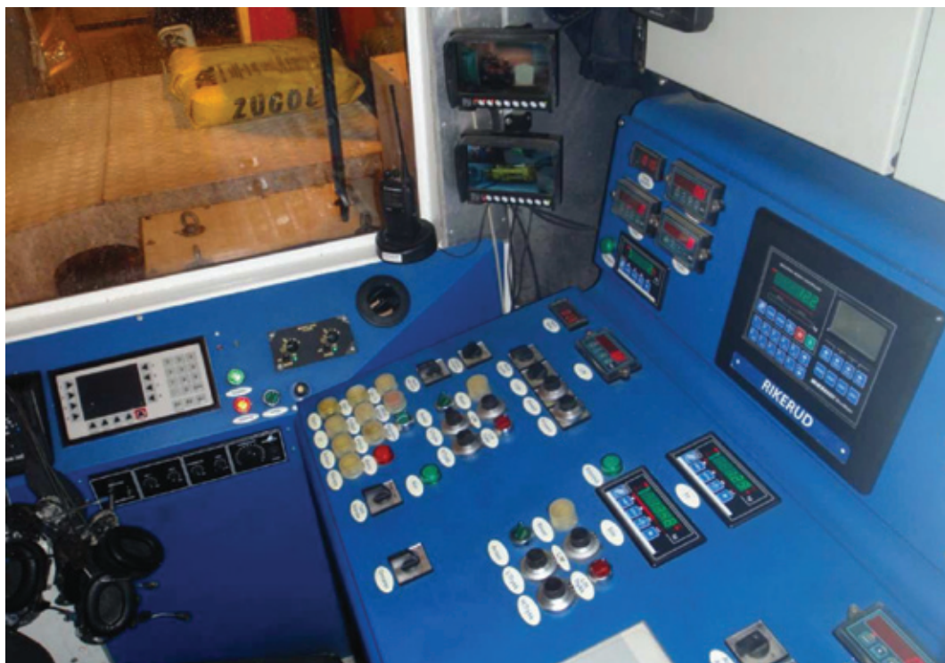
Figur 8 Eksempel på styringsenhet på en moderne injeksjonsrigg
