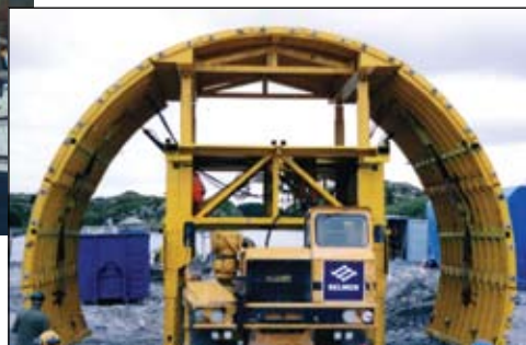
Figur 20. Eksempel på støpeskjold montert på dumper som ble benyttet på Frøyatunnelen
