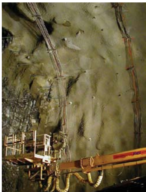
Figur 14. Armerte sprøytebetongbuer fra Tanumtunnelen og Nationaltheatret stasjon
