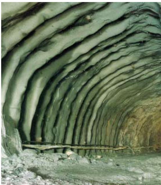
Figur 14. Armerte sprøytebetongbuer fra Tanumtunnelen og Nationaltheatret stasjon
