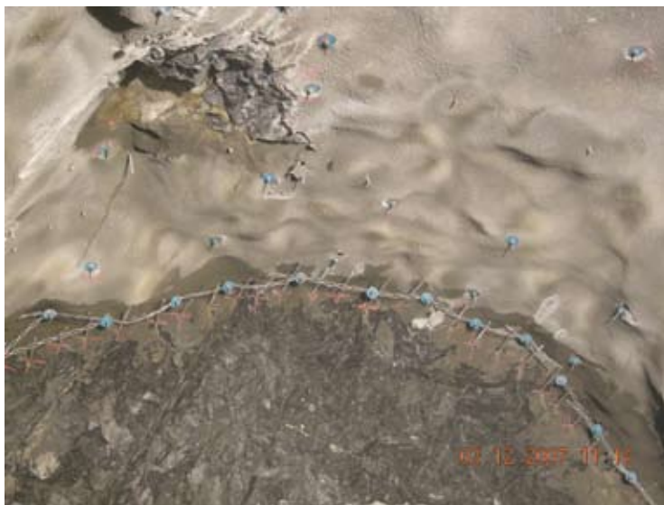
Figur 11. Eksempel på "oppheng" av forbolter fra Bærumstunnelen, foto Jernbaneverket
