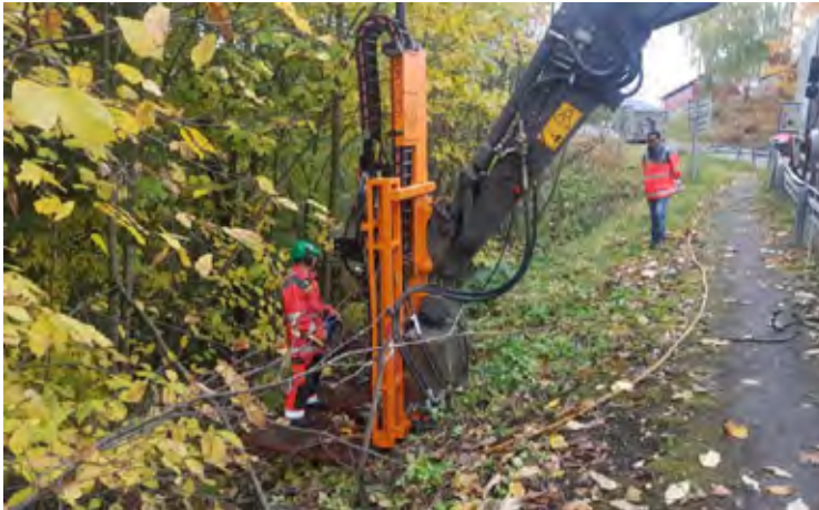
Figur 7 Asdøla bru borpunkt 1007.
