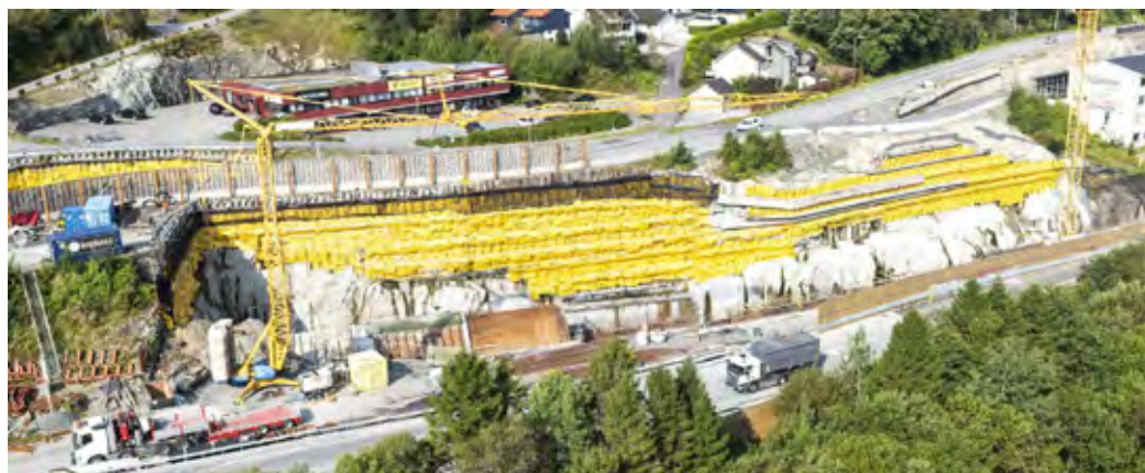
Figur 11: Ferdigstilt utgraving. Bilde tatt 2019-08-27 (foto: Statens vegvesen)
