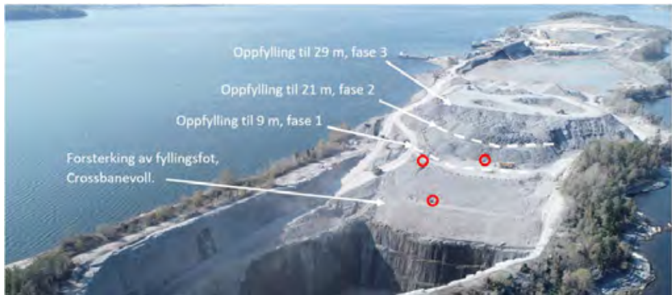
Figur 7 Bildet viser Crossbanevollen og oppfyllingstrinnene i Seksjon 4. Poretrykksmålerene og inklinometermålepunktene er vist med røde ringer.
