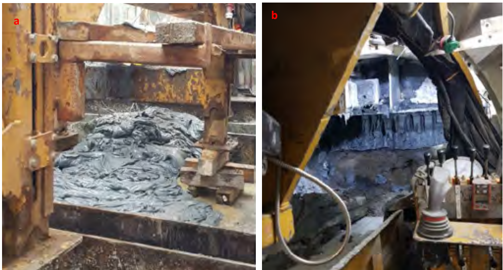
Figur 22: a) Stedlige masser fra område med pilotboring, b) Fra bløt, til lagdelte og harde masser under tunnelering
