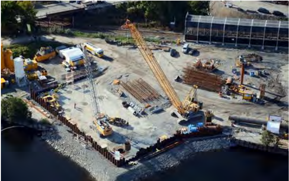
Figur 9: Anleggsområdet for akse 7 (og 8). Foto: Statens vegvesen
