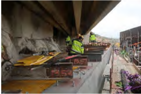
Figur 18: Forlengelse av H-bjelkene.
