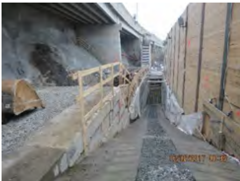
Figur 16: Adkomst vei til Søndre Portal.
