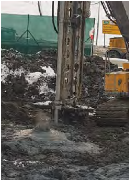
Figur 12: Injisering av multicem, visp med Ø800
