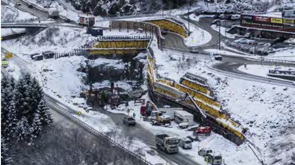
Figur 6: Forskjæring under utførelse pr. 2017-12-12 (foto: Statens vegvesen)
