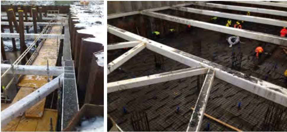
Figur 7: Spungtropa med stålkjernepeler til venstre og stålrørspeler til høyre. Foto: Rambøll
