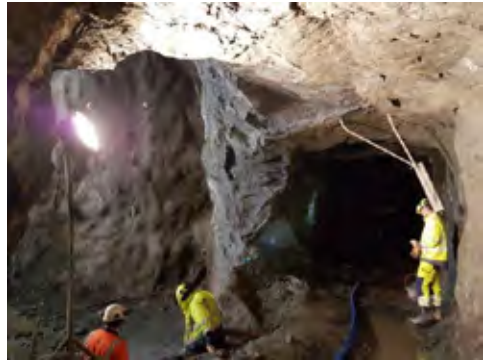
Figur 15: Rømningsstunnelen hadde et tverrsnitt på ca. 8m 2 .
