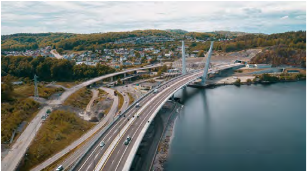
Figur 19: Oversiktsbilde Farrisbrua. Foto: Rambøll/Aleksander Ribe
