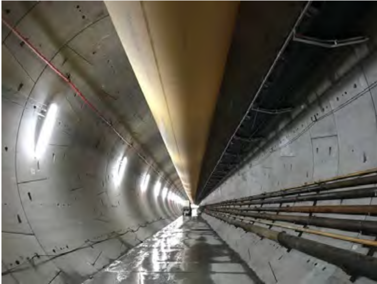
Figur 5 Typisk tunnelverrsnitt for en betonglinet tunnel illustrert ved foto fra Follobanens tunnel.
