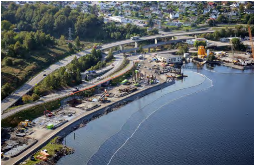
Figur 8: Anleggsområdet med siltgardiner. Foto: Statens vegvesen
