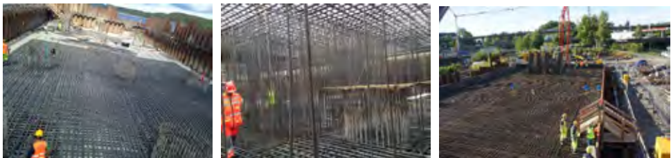
Figur 15: Fundament akse 7. Foto: Statens vegvesen
