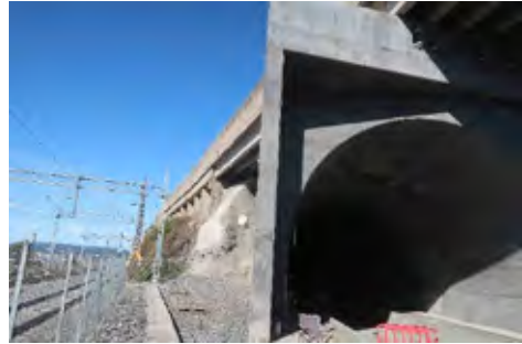
Figur 19: Søndre Portal ferdigstilt.
