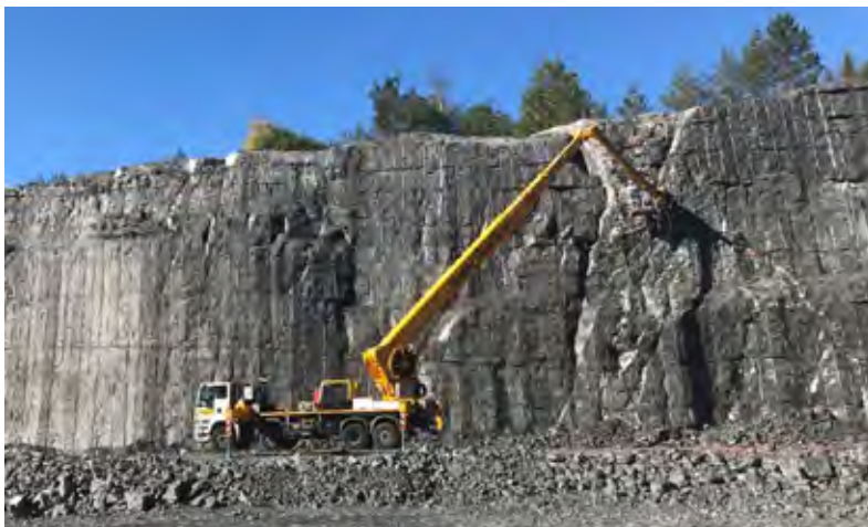
Figur 3 Inspeksjon av fjellsikring etter at deler av mellomlageret var fjernet
