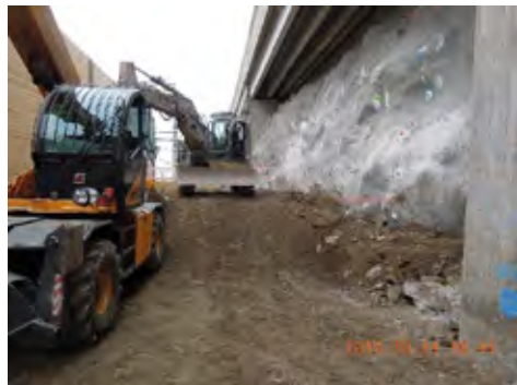
Figur 17: Sikring av fjellet under E18.
