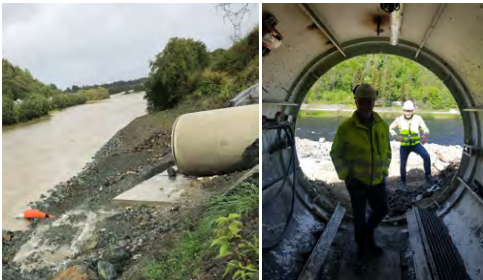
Figur 30: Ferdigpresset rør. Utløpet er ikke ferdigstilt.
