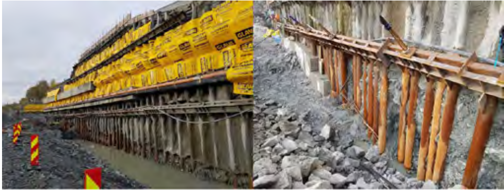
Figur 8: Rørveggen under utførelse (foto: S. Schanke, Norconsult)
