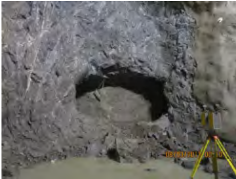
Figur 14: Det ble sprengt forsiktig forbi rømningsstunnelen.
