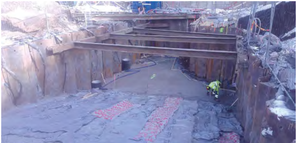
Figur 27: Grop for påkobling av teknisk kulvert ferdig utgravd.
