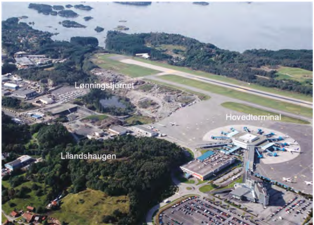
Figur 1 Bergen lufthavn Flesland, med Lilandsåsen og Lønningvatnet før prosjektstart. Sett fra nord-øst.
