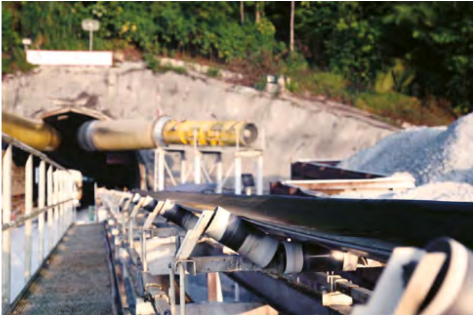
Figur 5 Massetransporten fra tunnelen vil gå på conveyorbelt som vist på fotoet.
