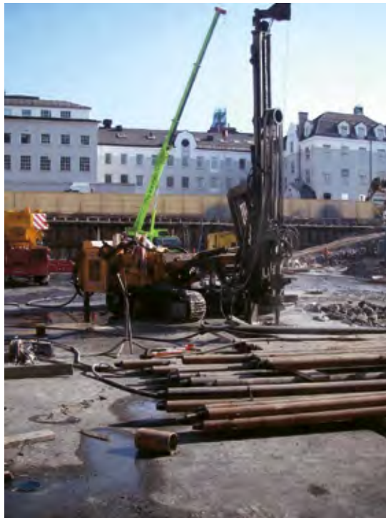
Figur 10. Boring av stålkernepeler ved Stiklestadkvartalet på Grønland i Oslo (foto NGI).
