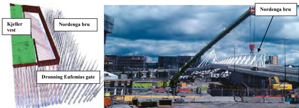
Figur 4: BIM-modell av byggegrøpen, «as-built» (t.v.) Tverrspunten deler byggegrøpen i to. Tverrspunten måtte ha tilstrekkelig avstand fra bru i øst, samt at den måtte tilpasses planlagte bygg over terrengnivå. Bilde (t.h.) Gravefase 1 - Innvendig avstiving mellom støpt kjeller vest og spunt øst.
