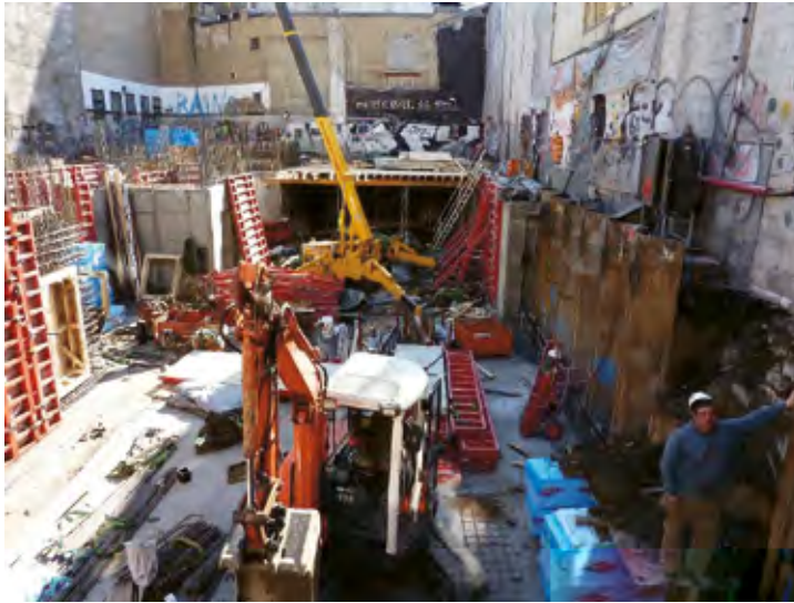
Figur 2. Fundamenteringsarbeider i St. Olavs gate (foto NGI).
