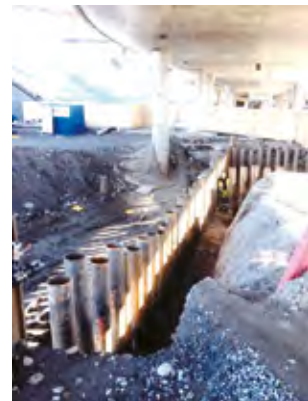
Figur 5: Rørspunt under bro.
