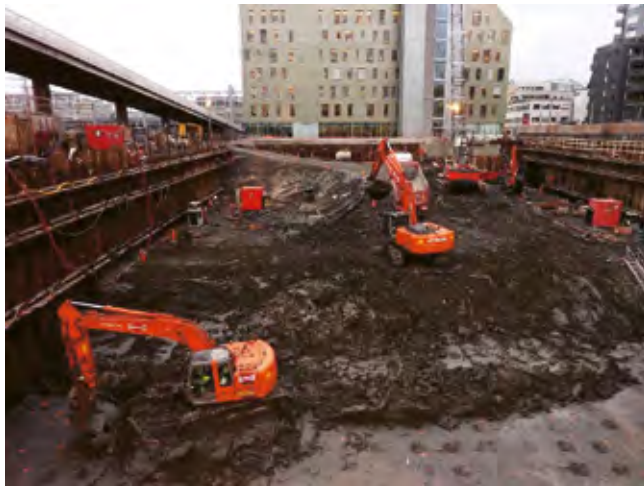
Figur 8. Grunn- og fundamenteringsarbeider i Schweigaardsgate 21-23 (foto NGI).
