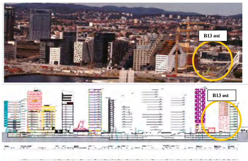
Figur 1: (Øverst) Prosjektområdet - "Barcode-rekken" – Operakvarteret – sett fra sjøsiden pr oktober 2013, byggelinje ca. 350 m. (webkamera fra osu.no ). (Nederst) Lengdesnitt gjennom «Barcodekjelleren» (DARK arkitekter). Utgraving for kjeller B13 øst er avmerket.
