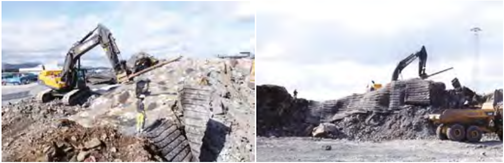
Figur 7 Dekking med tunge skytematter med gravemaskin påmontert jibb. Primo september 2013 – Fase 7. Steinmasser lagt opp langs foten av salven, t.h.
