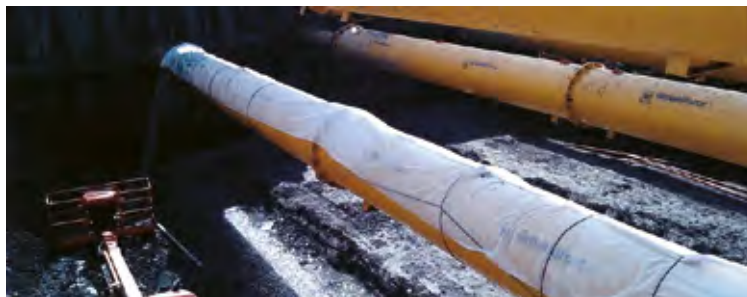
Figur 11: Kjøling av stiver vha. svetteslange og filterduk – konstant målt kraft ca. 2.700 kN.
