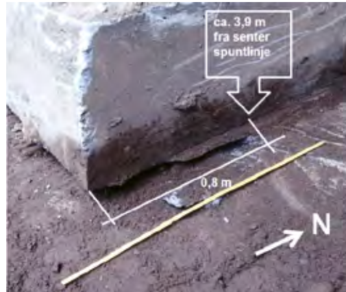
Figur 12: Fundament akse 23/AL.
