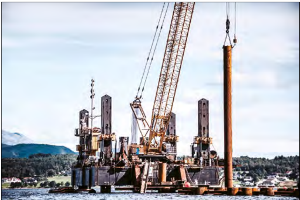
Figur 9 Pågående peling på Tresfjordbrua med peleriggen «Anne-Gret» Bilfinger er markedsledende på fundamentering på store dyp. /Foto David Zadig/
