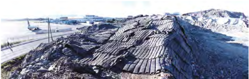
Figur 8 Salve ferdigdekket. Primo september 2013 - Fase 7.
