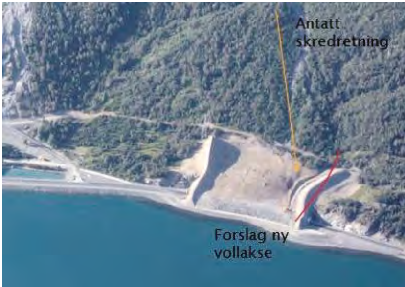
Figur 20.7 . Eksempel på feil utformet ledevoll.
