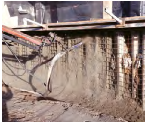
Figur 14: Armeringsnett og sprutbetong.
