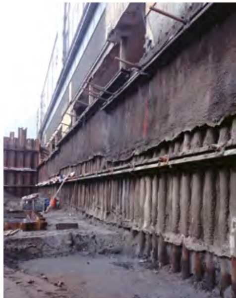
Figur 13: Deler av spuntvegg mot Pir vest.
