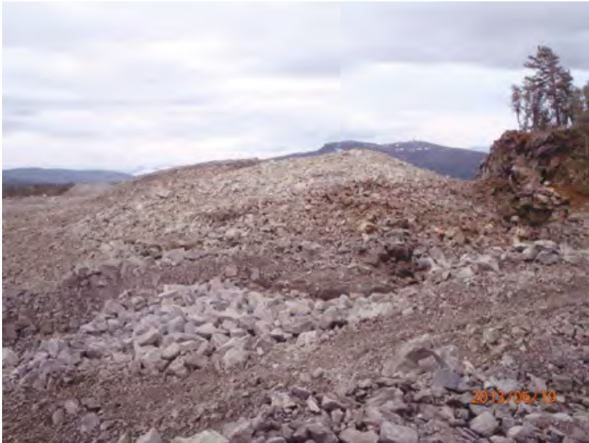
Figur 6. Røysa og fremkast fra endelig vegg til høyre på bildet.
