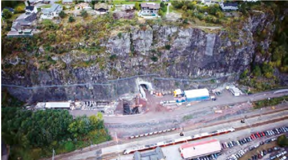
Fig. 3.13 Riggområde v/R7: tverrslag R7, adkomst/kulvert A7, dagen stasjon
