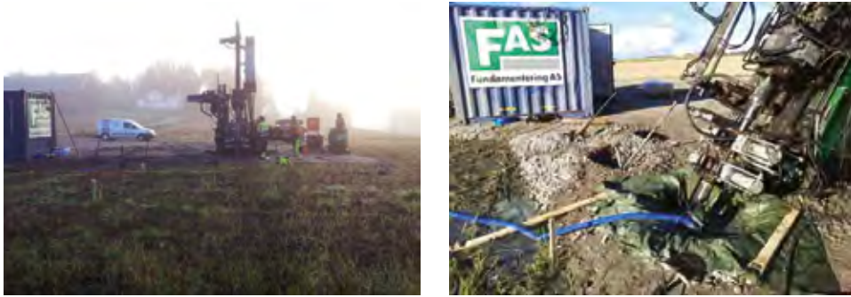
Figur 7. Boring Ischebeck-stag ved forsøksfeltet, utført av FAS i september 2013 (foto NGI).
