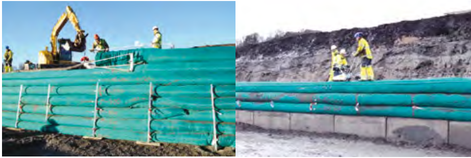
Figur 11 a) innblåsing av Leca i tube, Rælingen. b) Komprimering av tube.
