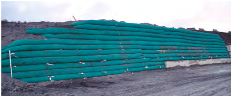
Figur 13 Ferdig TeMaSi-konstruksjon Rælingen 2012.
