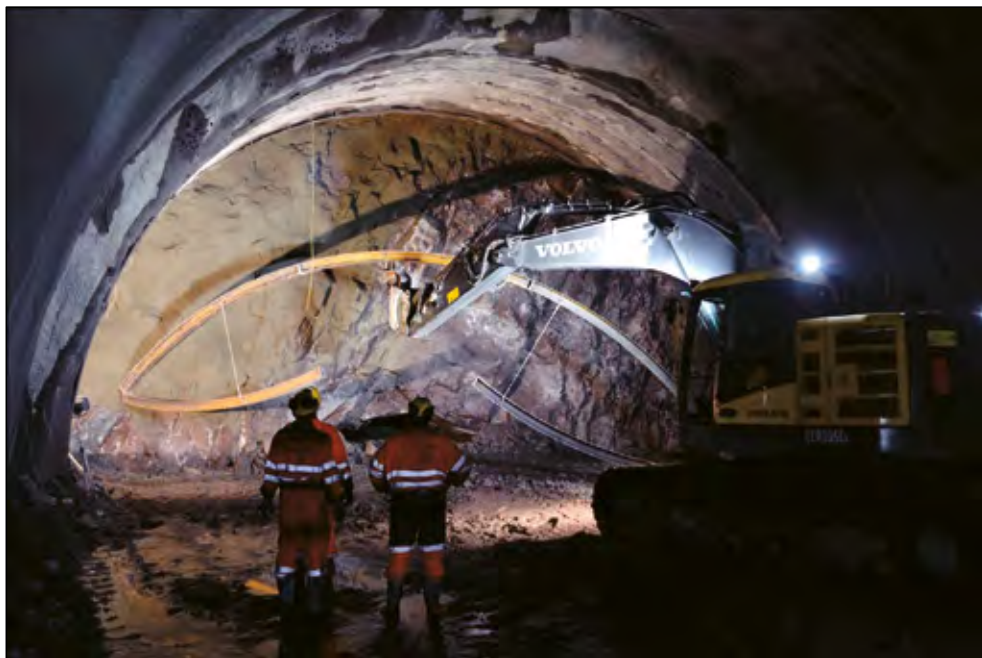
Bilde 3. Montering av stålboge. Stålbogane vart levert i 5 delar og montert saman på anlegget. For å forenkle monteringa var bogane ledda i begge sider. Foto: Freddy Fagerheim, JBV.
