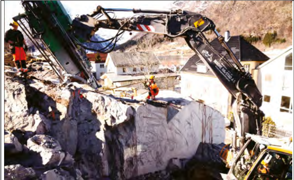
Figur 3: Montabert på gravemaskin. Innmåling av vinkel for supplerende bergsikring. Utførende underentreprenør Hafstad entreprenør
