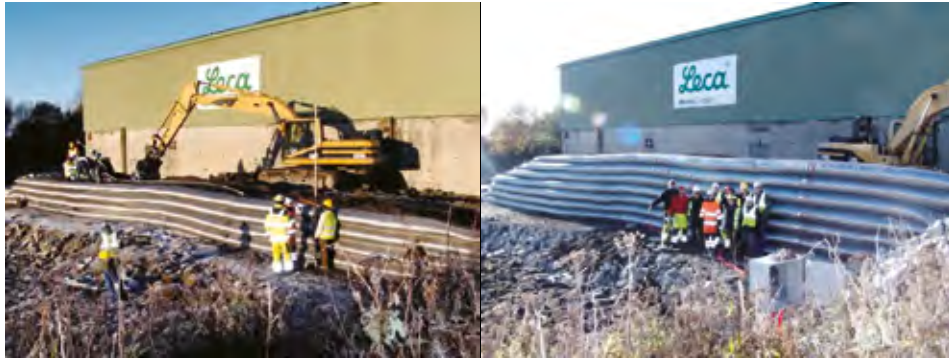
Figur 10 Fra bygging og ferdigstilling av 2,5 meter høy TeMaSi-konstruksjon ved Borge.
