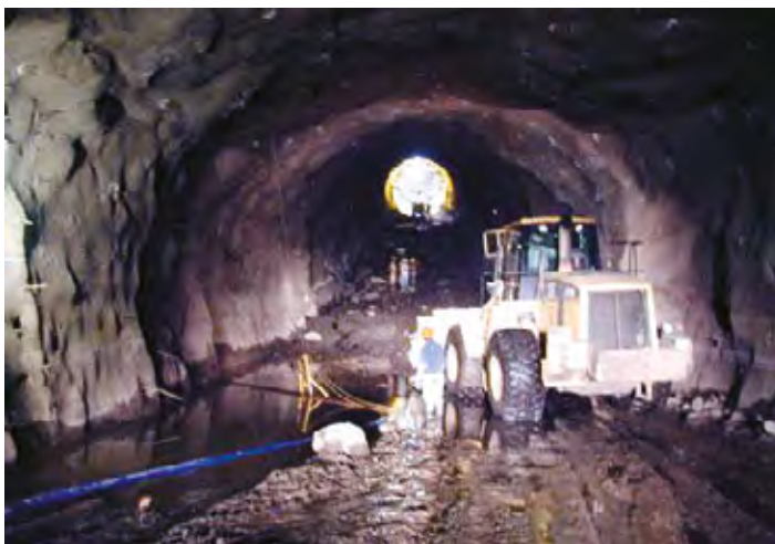
Figur 4. Foto fra inntakstunnelen ved Esti, Panama. (Foto: TunnelTalk)
