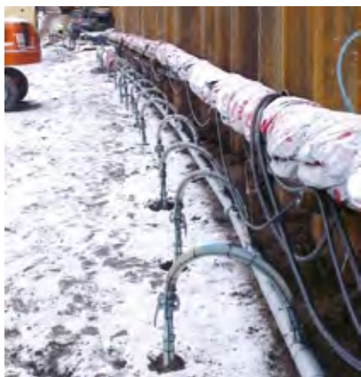
Figur 20: Wellpoints over et større område.
