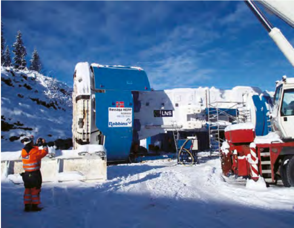
Figur 2 Montering av TBM'en foregår i vinterlige omgivelser.
