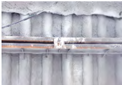
Figur 15: Rensk og sprutbetong.
