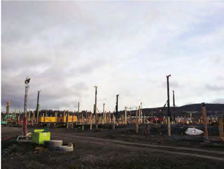
Figur 11. Installasjon av betongpeler ved Alfaset, Alnabru (foto NGI).
