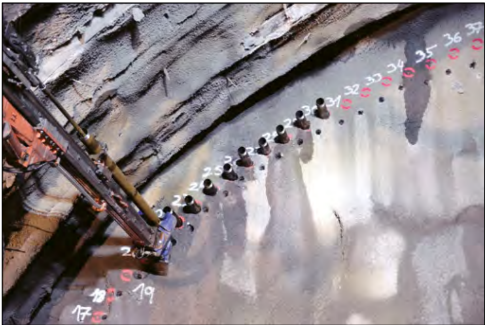
Bilde 2. Innboring av 114mm perforerte stålrør. Foto: Freddy Fagerheim, JBV.
