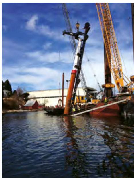
Figur 6: IHC S-200 hammer med leder under peling i akse 18/Skjematisk tegning av riggen (Bilfinger, 2012)
