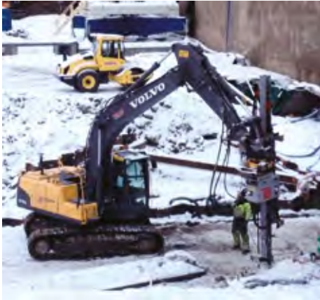
Figur 25: Injisering av injeksjonsmasse.
