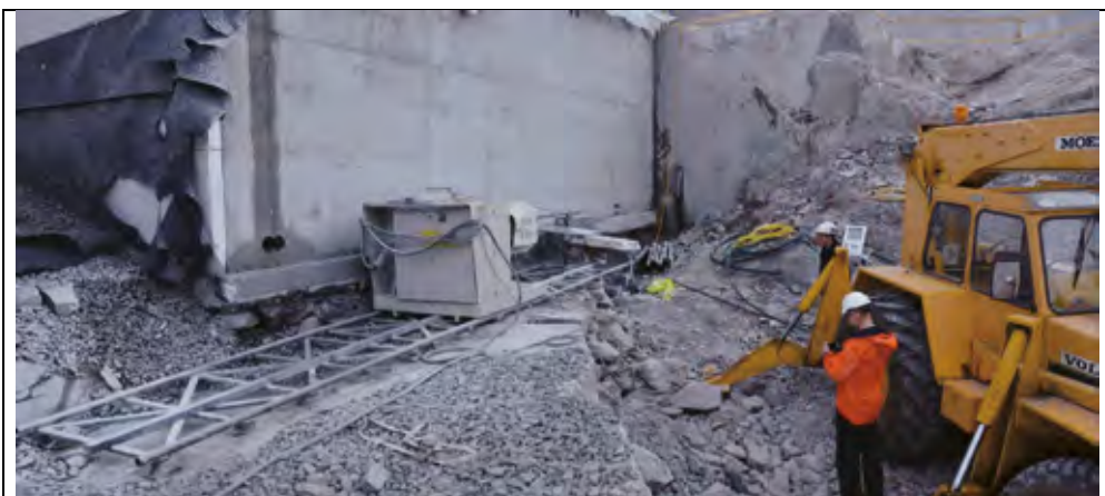
Figur 4: utstyr for saging av bergmassen med diamantvaier. Utførende DW wireteknikk
