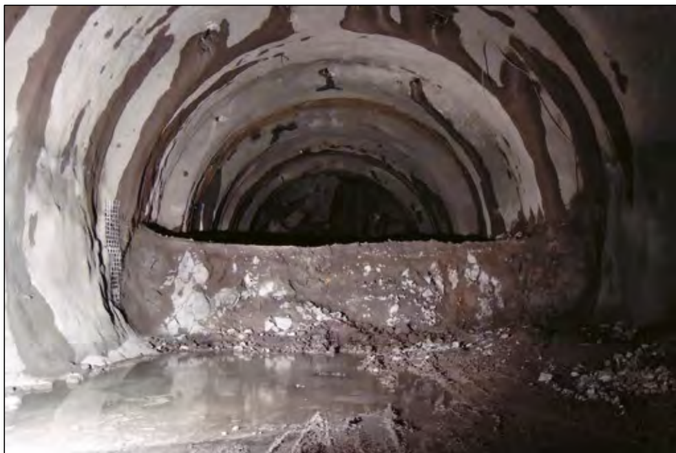
Bilde 4. Utstrossing av nedre del av profilet. Foto: Jernbaneverket.
