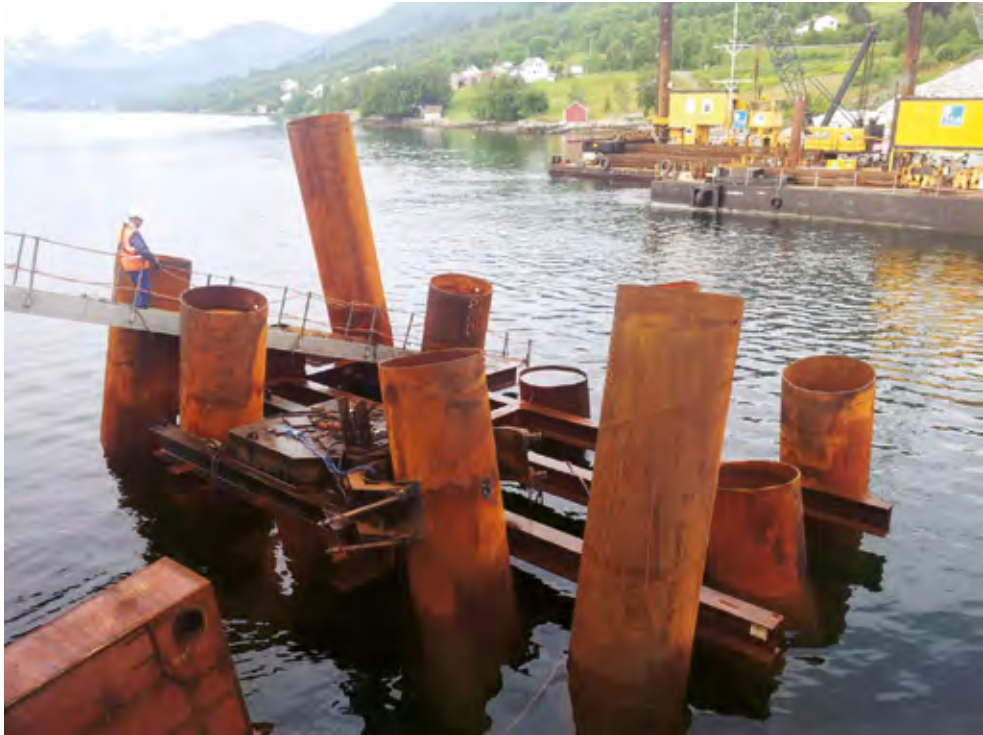
Figur 4: 12 peler fundament i akse 17. PDA utstyr kan sees påmontert pelen som står i «kloa».
