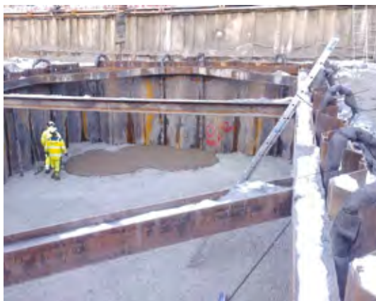
Figur 21: Lokal senking av grunnvann i spuntgrop med wellpoints.
