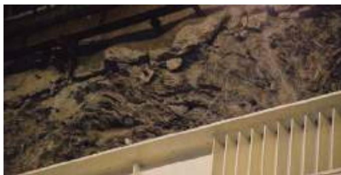
Figur 4. Eksponert fyllitt /skifer i nedstrømveggen av maskinhallen.
