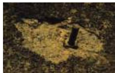
b) Skadet sprøytebetong pga boltebrudd
