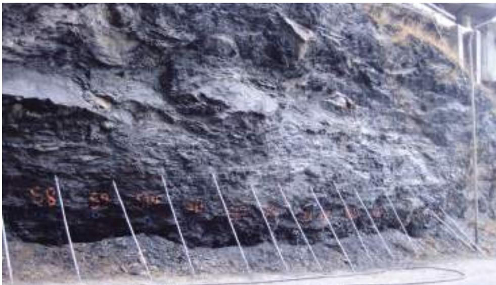
Bilde 1: Vegskjæringen inn til NorBetongs og Norcems anlegg. Store kalkknoller sees i øvre del av skjæringen. Forsøksbolter klare for installasjon.
