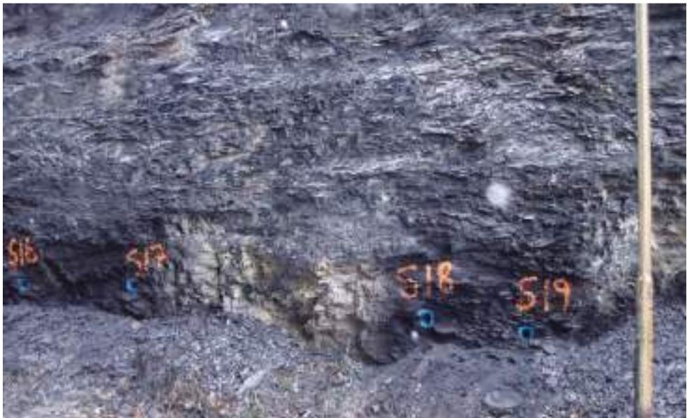
Bilde 2: Typisk bergkvalitet i vegskjæringen - tett skifrig alunskifer som i overflaten er løs og småfallen.
