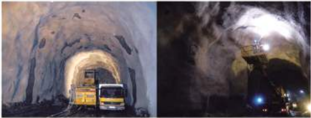
Figur 6. Forsøksfelt tverrslag Ulvin syd. Venstre foto: vannlekkasjesituasjon i tunnelkonturen etter utført bergsikring, før påføring av vanntetningsmembran. Høyre: pågående sprøytearbeid med vanntetningsmembran.
