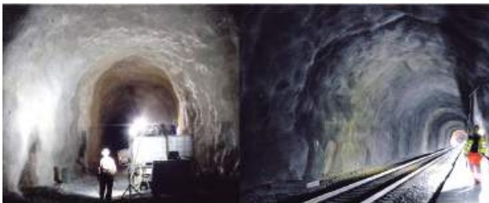
Figur 8. Gevingåstunnelen. Venstre: fra byggefasen med påføring av vanntettingsmembran.
