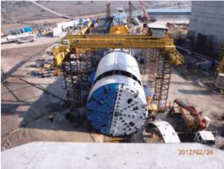
Foto 3 TBM under sluttmontasje
