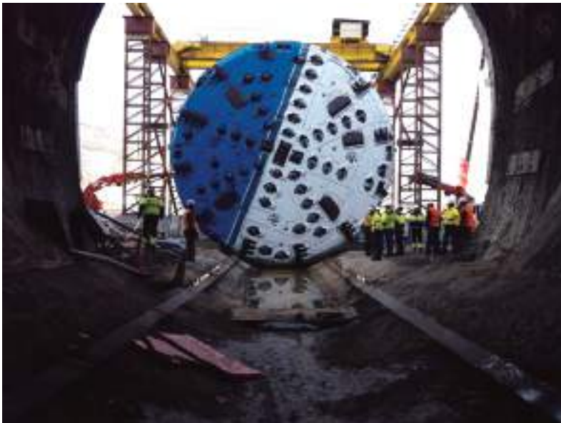
Foto 4 TBM på vei inn i tunnelen
