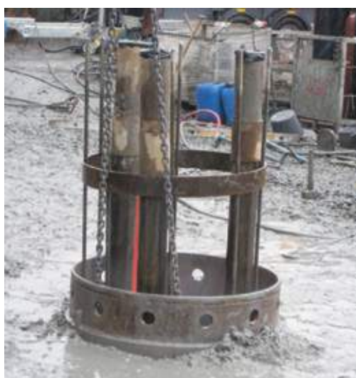
Figur 20 Nedsenking av armeringskurv i ferdig boret pel.
