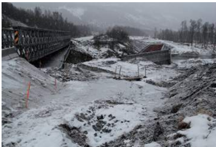
Figur 7 viser hvordan det så ut høsten 2010 før frosten gav oss en pause i utvaskingen. Denne lille brua midt i bildet ble satt opp av en nabo som ville hjelpe oss over "silt-elva" fra hull 202 og 203.
