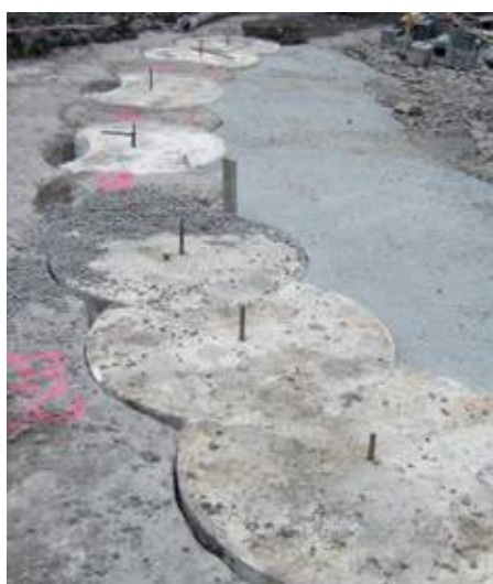
Figur 19 Støping av boremal for nøyaktig ansett av sekantpelene.
