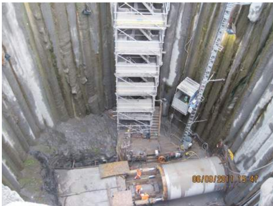
Figur 36 Sjakt S9 i september 2011. Rørpressing foregår mot høyre, gjennom sjaktveggen. Utvendig diameter på røret er 3,0 m. Analyser viste at hulltaking i veggen kunne gjøres uten forsterkninger av veggen.
