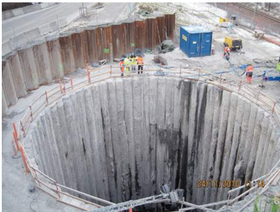
Figur 32 24. november 2010. Oversikt. Mosseveien til venstre, Østfoldbanen til høyre.
