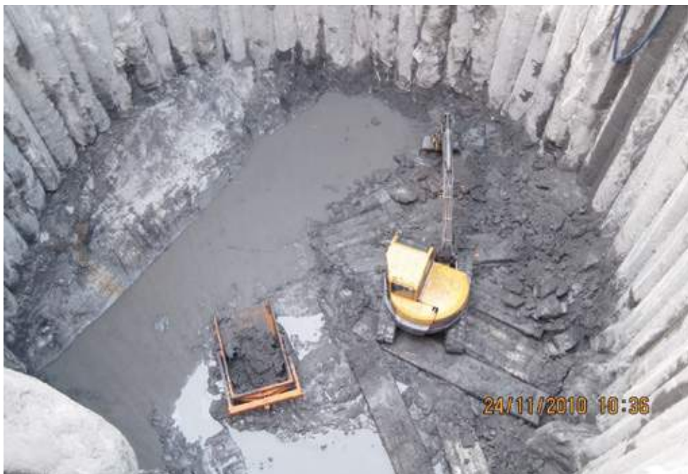
Figur 30 24. november 2010. Utgravingen har nådd ca. 18,5 m. Ni tonns maskin og stålbeholder på 3 m 3 . Merk skrå bergflate til venstre.
