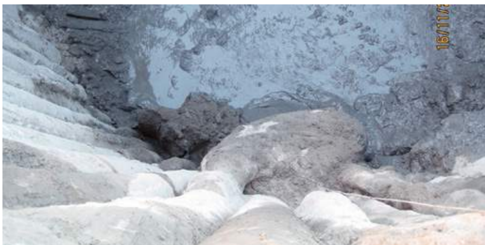
Figur 28 16. november 2010. Utgravingen har nådd ca. 15 m. Den største betongutveksten stikker ca. 2 m ut fra sjaktveggen.
