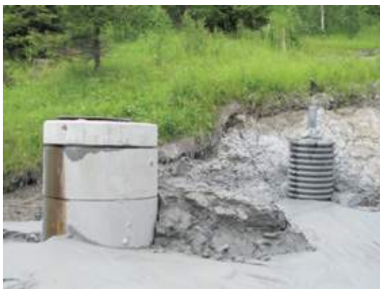
Figur 14 Kumringene rundt hull 202 i forgrunnen og dreneringsbrønn 302 bak.
