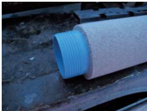
Figur 16 En dreneringsbrønn med prefabrikkert filter.
