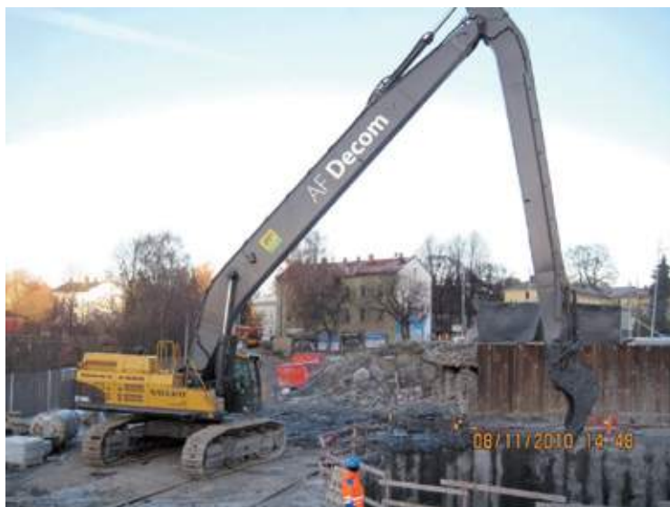
Figur 23 8. november 2010. 70 tonnns maskin med rekkevidde nesten 20 m.
