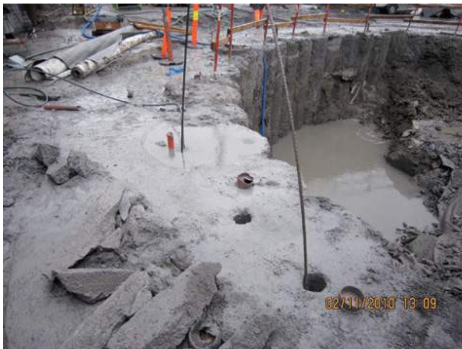
Figur 33 Klargjøring for montering av forankringsstag. Spyling av borhull. Merk rødt rør for inklinometermålinger i en av pelene.
