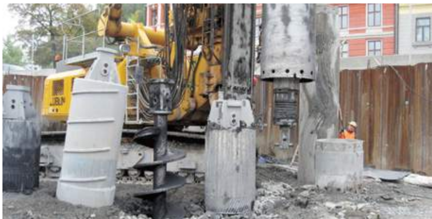
Figur 21 Diverse utstyr for boring av sekantpelene.
