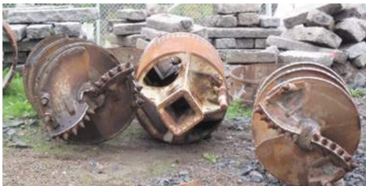
Figur 16 Utstyr for innboring av sekantpelene i berg.
