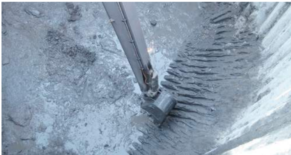
Figur 29 16. november 2010. 70-tonneren når ikke lenger helt til motstående vegg. Merk faste masser der det er KS-stabilisert nærmest sjaktveggen.
