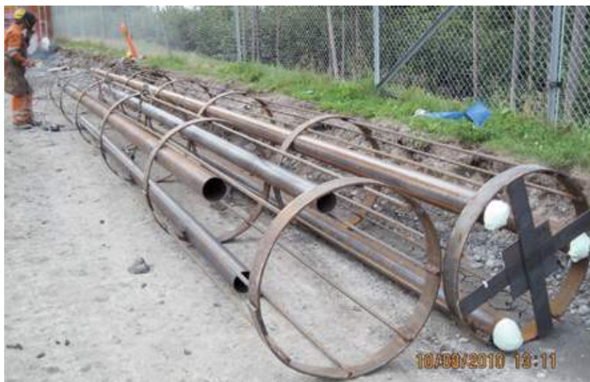
Figur 18 Armeringskurv med rør for fordyblingsbolter.
