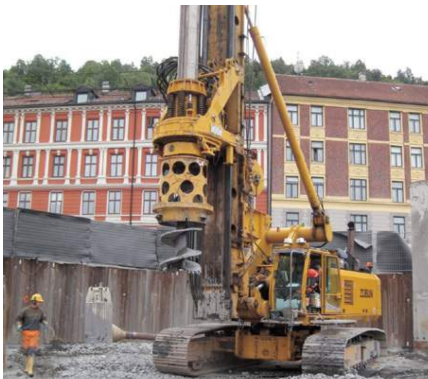
Figur 14 Maskinen for boring av sekantpelene. Vekt 140 tonn.
