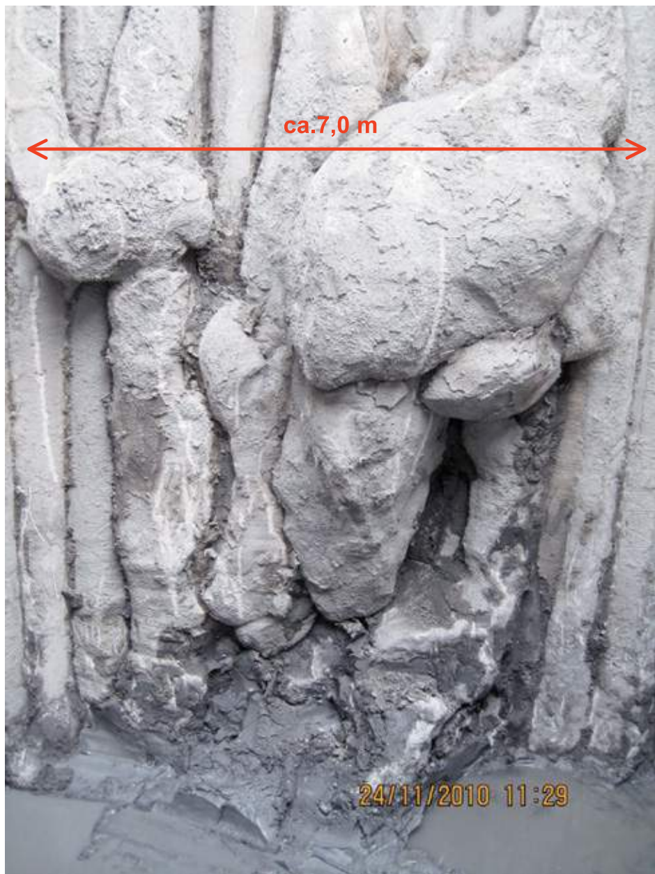
Figur 31 Sjaktvegg der de største betongutvekstene var konsentrert. Den store klumpen til høyre kom sist og la seg utenpå de andre. I den pelen var overforbruket av betong ca. 71 %; det største for alle pelene.
