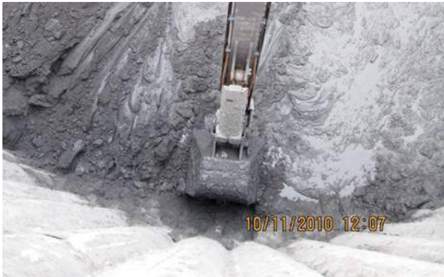
Figur 26 10. november 2010. Utgravingen har nådd ca.13 m. Sjakten sett ovenfra. Merk faste masser der det er KS-stabilisert nærmest sjaktveggen og omrørte masser for øvrig.
