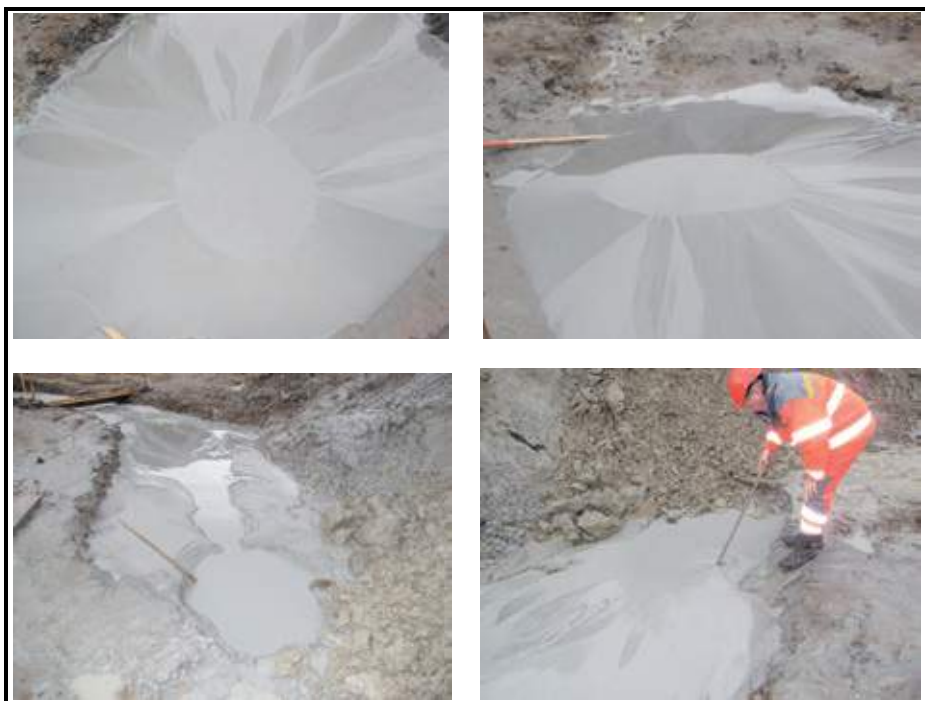
Figur 17 Silt i ulike fasonger. De to øverste bildene viser en "siltvulkan". Bilde nederst til venstre viser hvordan silten rant ut av hull 202 og laget en bekk av finstoff og vann ned mot elva. Silt som ligger i ro blir raskt fast i toppen og "størkner" nedover, men blir flytende igjen når man rører i den slik at vannet igjen blandes sammen med kornene, se bilde nederst til høyre.
