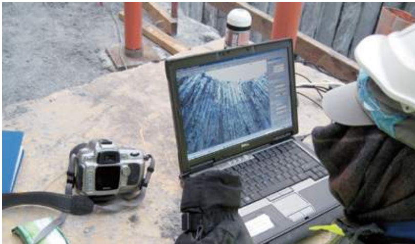
Figur 35 Kontroll av geometri ved skanning. Operatøren er godt kledd mot kulda.
