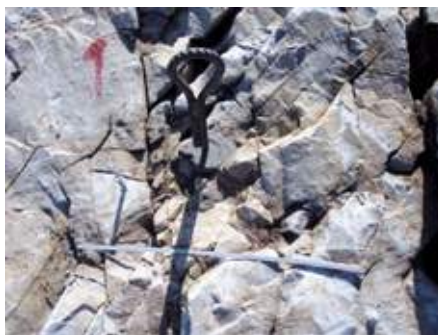
Figur 7 Bolt 11 før belastning
