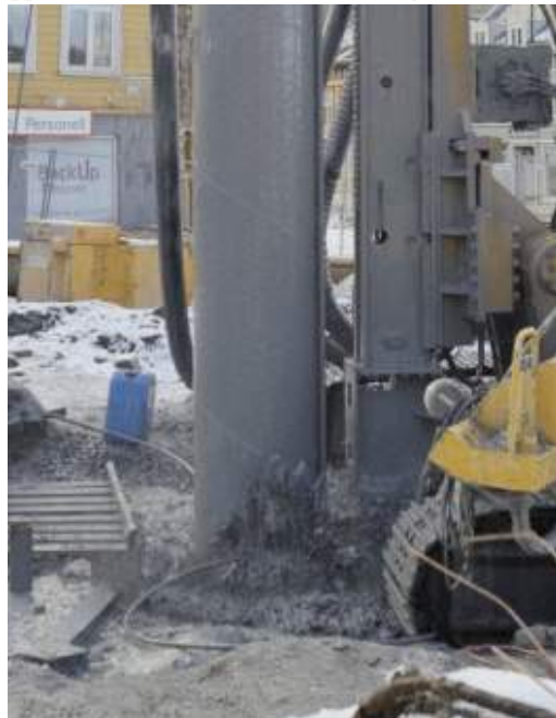
Figur 5: Luft kommer opp langs utsiden av røret.
