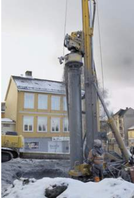
Figur 4: Tømming av rør med luft.
