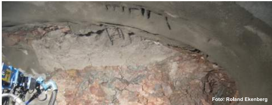
Figur 9. Insprutade gitterbågar, spiling och inträngning av morän i tunnelns hjassa
