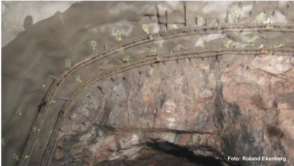
Figur 6. Injekteringsbara stag och gitterbågar, i nedre delen av fotot syns pilottunneln vidare
