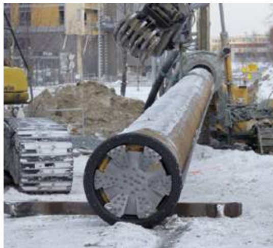
Figur 2: Rørsputt med pilotkrone, ringborkrone og spuntlås.
