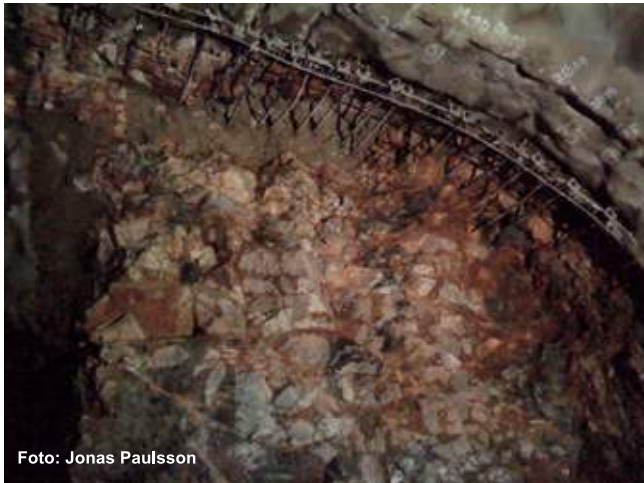
Figur 2. Bergmassan och inträngning av morän i tunnelns hjässa
