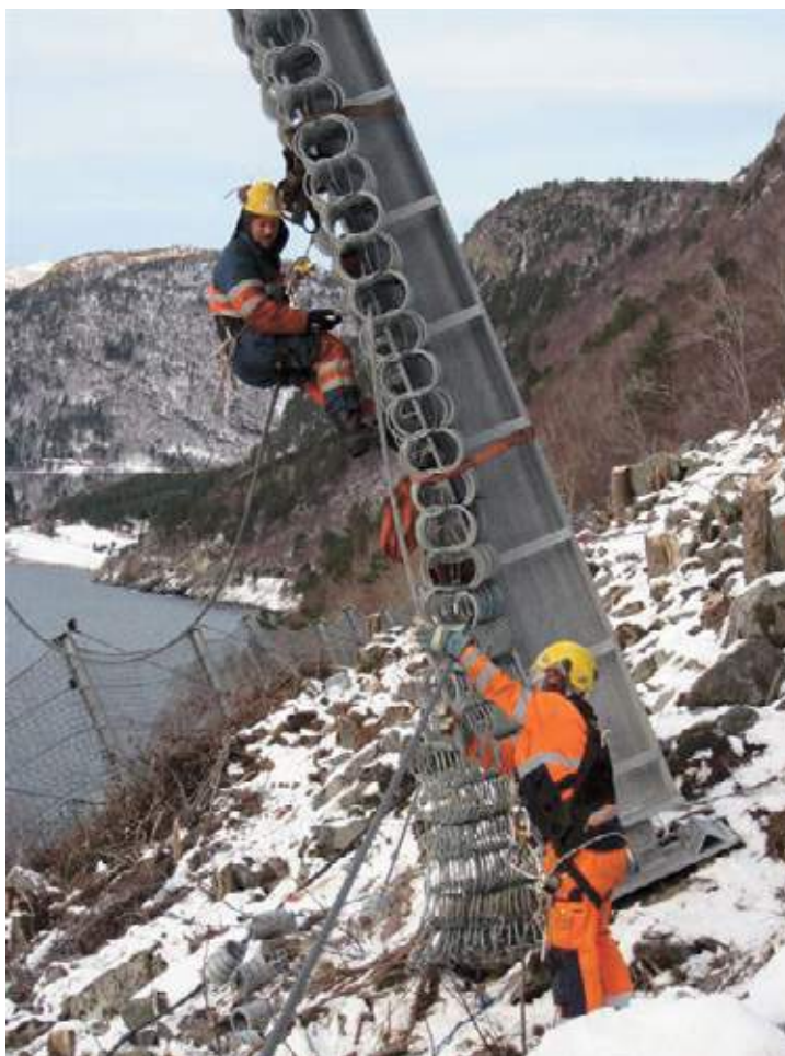
Figur 18 5000kJ gjerdet – en av stolpene under monteringen.
