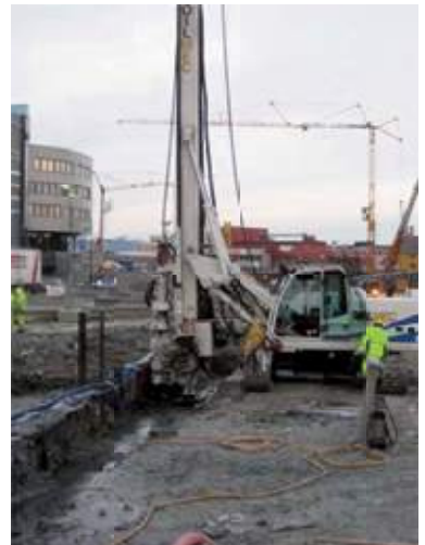
Fig. 22.7 Jetinjeksjon mellom KC-blokk og spunt
