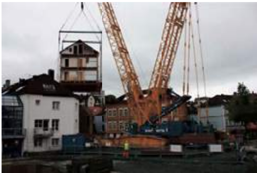
Figur 22.3 Flere hus ble flyttet ...
