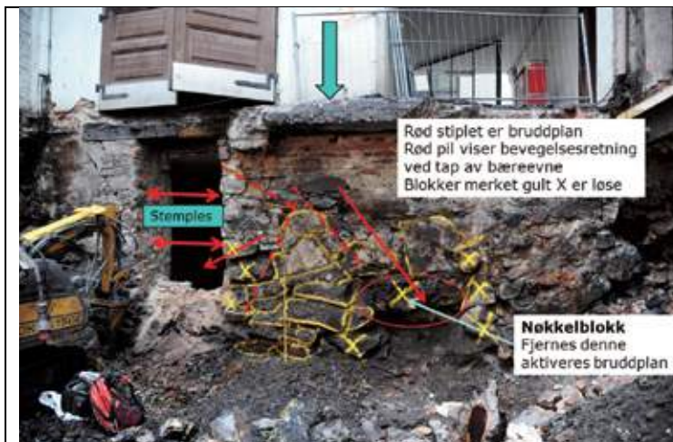
Figur: Tørrmur i portrom. Foto ble brukt som instruks for hvordan arbeidet skulle utføres. For denne vegg var rekkefølge på arbeidsprosesser kritisk for å opprettholde bæreevne.
