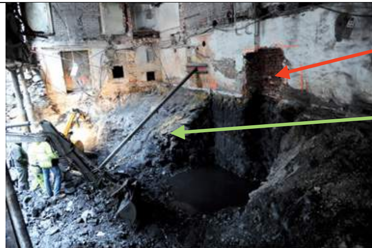
Figur: Seksjonsvis utgraving langs vegg mot KJ12J med avstiving ved grube for rulletrapp. Plassering av rulletrapp mot yttervegg mot naboeiendom KJ12J medførte at veggflaten fikk mindre sidestøtte fra etasjeskiller enn opprinnelig prosjektert. Plassering av rulletrapp var i henhold til leietakers ønsker. Plassering av pilastre må avklares med RIB og RIG i fellesskap! Det er viktig å være klar over at alunskifer ikke er en tett bergart
