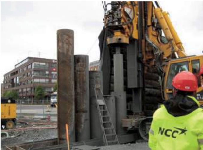
Fig 22.6 Nedboring av siste 2 m av hvert spunnrør med senkbor. mellom Prosjektleder Svein-Arne Henriksen ser på.
