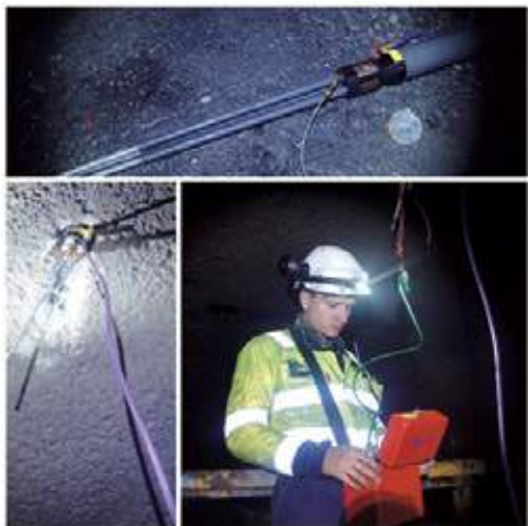
Figure 12 Installering av ekstensometer nivå 221 borort 5
