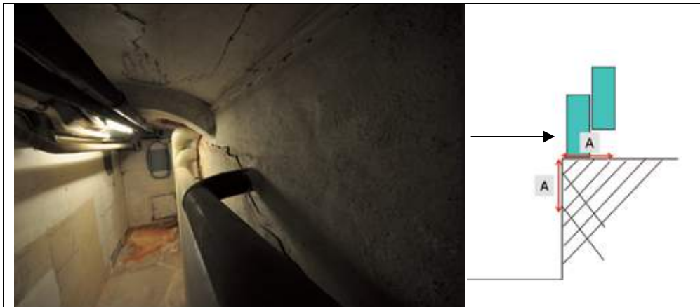
Figur 2: Teglsteinsvegg mot naboeiendom KJ12J. Pil viser nivå der fjernvarme og sprinkler krysser eiendomsgrensen.
