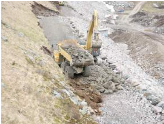
Figur 19: Arbeidsbredde ved plastring 2007 Foto: J. Aarbakk
