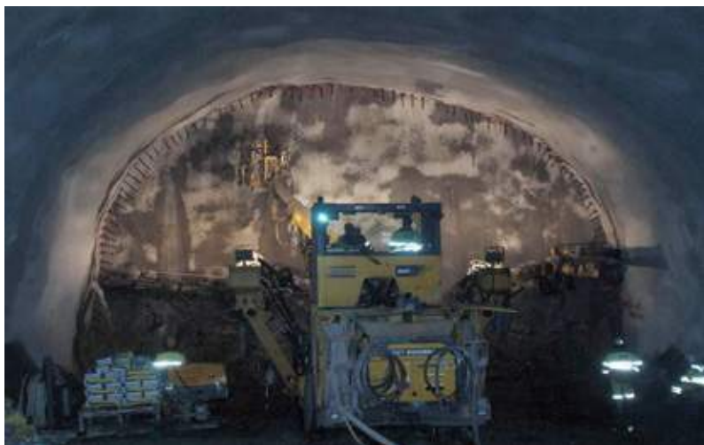
Figur 18-10 viser stuff sikret med spiling, buer og sprøytebetong på stuff.
