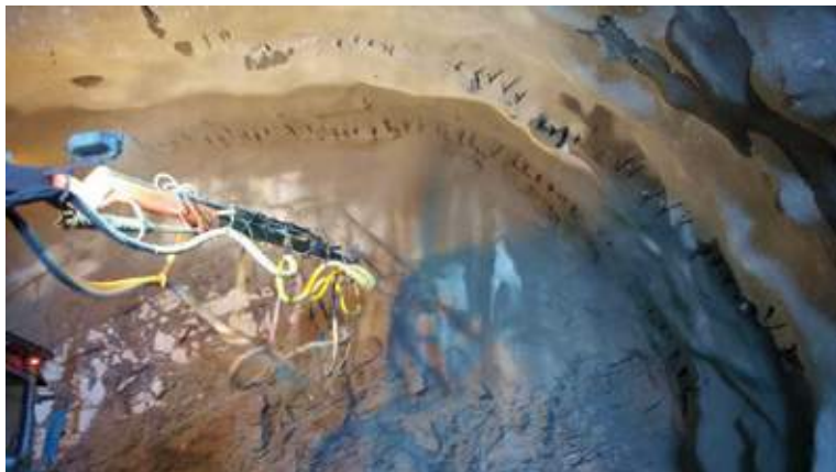
Figur 18-8 stuff på Håvik viser tett oppsprukket berg, med overlappende spiling og sprøyting av stuff.
