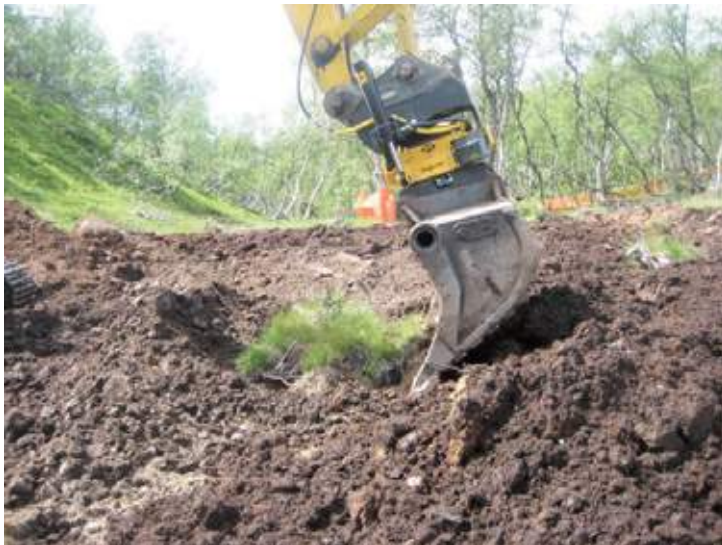
Figur 25: Plassering av torv i grunn plantegrop. Foto: P.A. Pedersen
