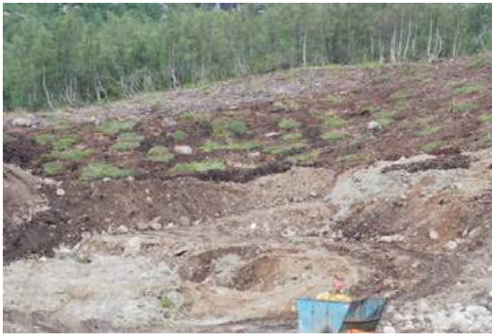
Figur 23: Ferdigstilling av steinbruddet. De innerste og øverste delene ble gjort helt ferdig først, august 2008. Foto: A. Skrindo.
