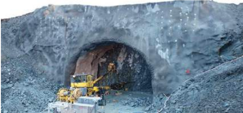
Figur 18-6 viser påhugget på Håvik hvor det er støpt avlastingsplate over påhugget og hvor det er satt inn horisontale og vertikale bolter, ca c/c 1m. Bergmassekvaliteten vises best ved å se på steinmassene i skråningen ved siden av stoffen.
