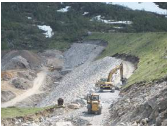
Figur20: Plastring av dammen, 2007. Foto: P. A. Pedersen
