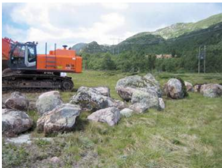
Figur 11: Det ble tatt ut ca 50 naturstein fra 0,5 til 2,5 m i diameter, og disse ble lagret med vegetasjonssiden opp, 2006. Foto: P. A. Pedersen
