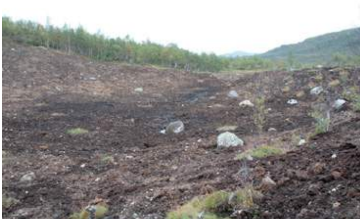
Figur 24: Det gjenfylte bruddet danner en skålform med en slak helning ned mot anleggsveien, bildet er tatt i 2008. Foto: L. Rosef
