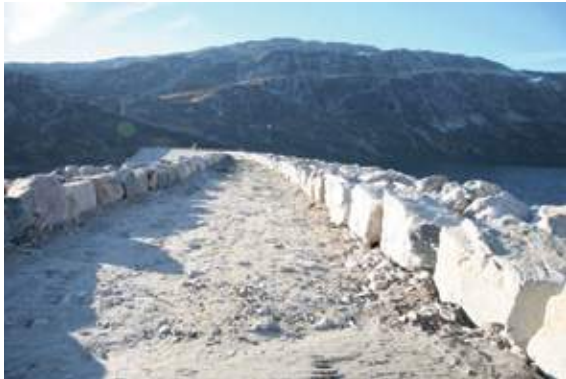
Figur 21: Avslutning av topp dam med kantstein Foto: J. Aarbakk
