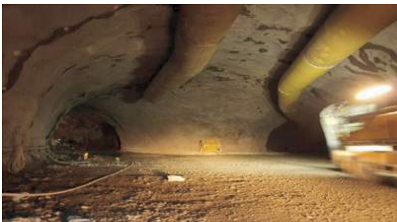
Figur 18-9 viser ferdig utsprengt rundkjøring.
