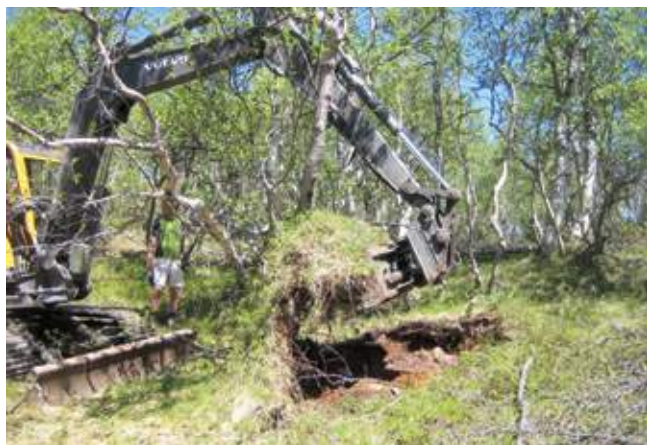
Figur 7: Uttak av torver med fjellbjørk. Foto: P.A. Pedersen
