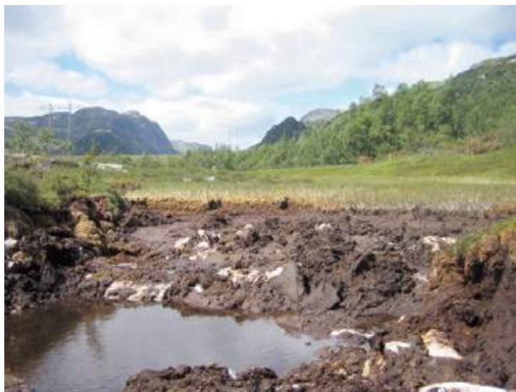
Figur 10: Begynnende avdekking og fjerning av myrjord der steinbruddet skulle etableres. Foto: P. A. Pedersen
