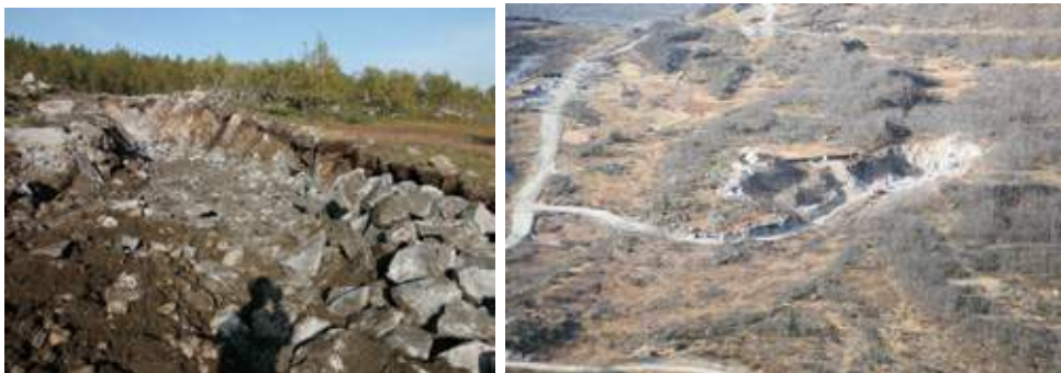
Figur 2: Etablering av atkomstvei til steinbrudd Foto: J. Aarbakk
