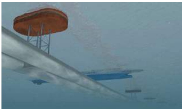
Eksempel på rørbru med flytende pontonger sett nedenfra
