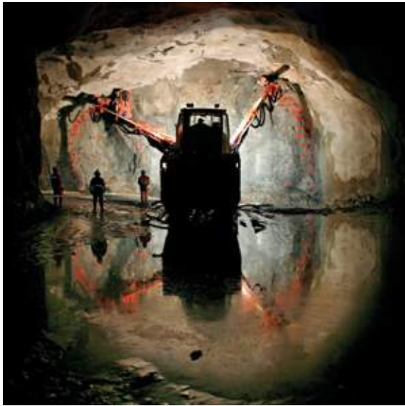
Figur 4. Konvensjonell tunneldriving ved sprengning (Foto: Hilde Lillejord, JBV)
