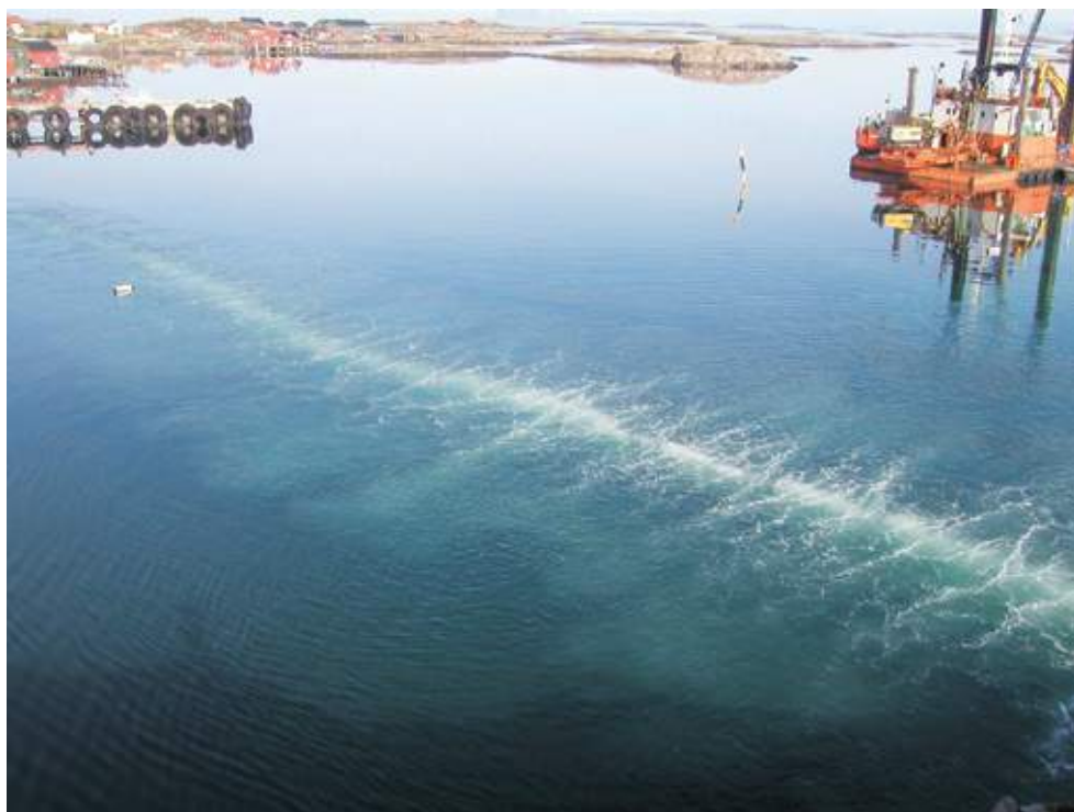
Figur 3 Boblegardin 55 m fra detonasjonssted. Lengde 120 m. (Foto Per Helge Thom Kystverket Senter for utbygging 2004)
