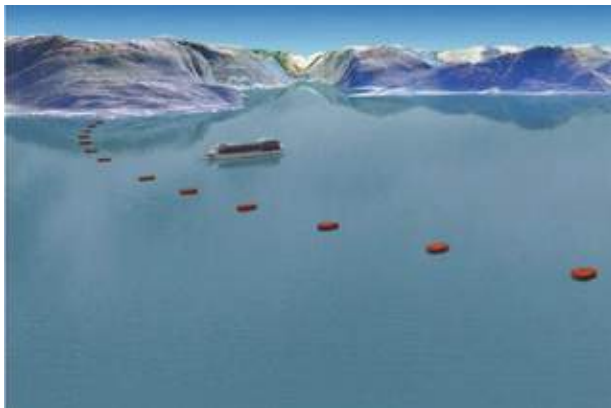
Rørbru-konseptet med flytende pontonger
