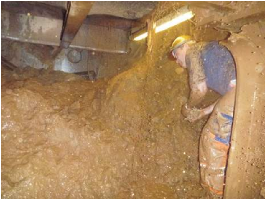
Figure 12 Kutterhodet etter man traff den andre svakhetssonene
