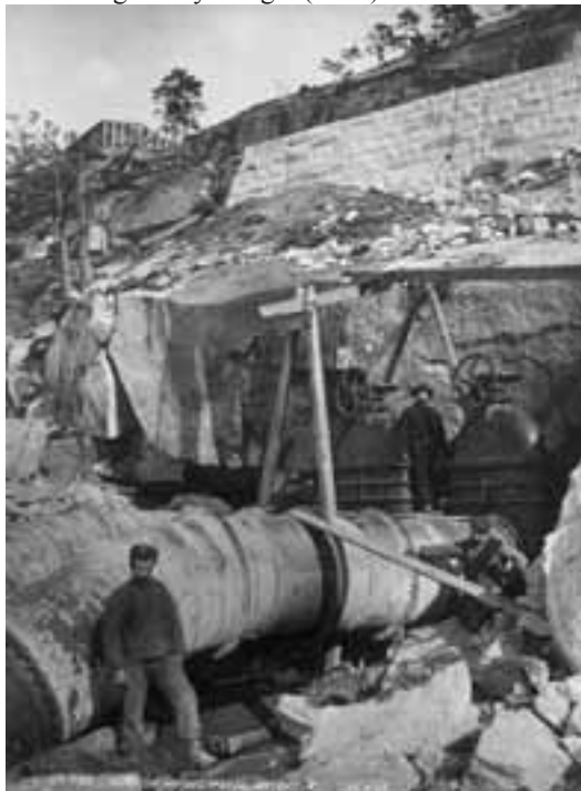
Montering av rør 1 og 2 (1908)
