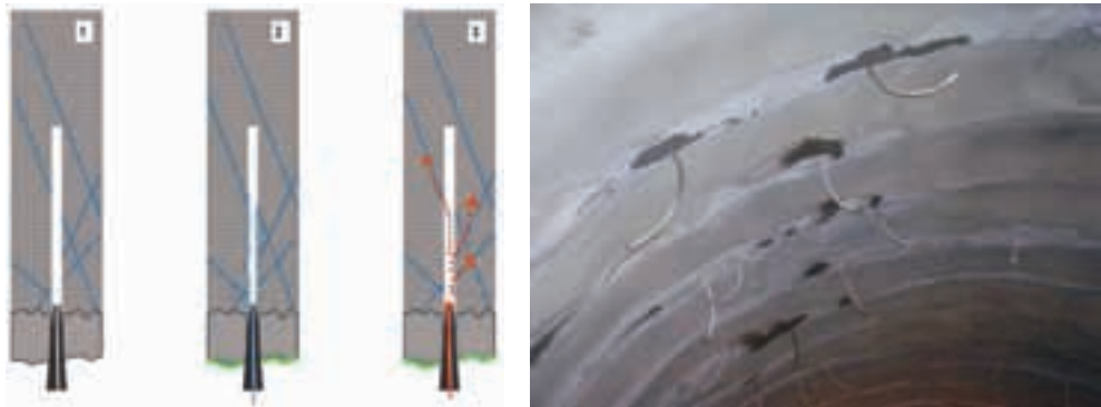
Figur 8. Eksempel på temporær drenasje av mindre punktlekkasjer på tunneloverflaten før påføring av vanntetningsmembran.
