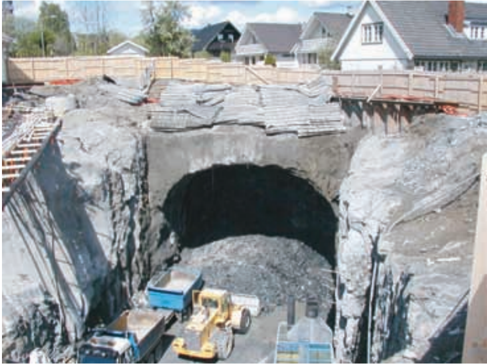
Figur 2, Påhugg for Skaugumtunnelen i Akser
