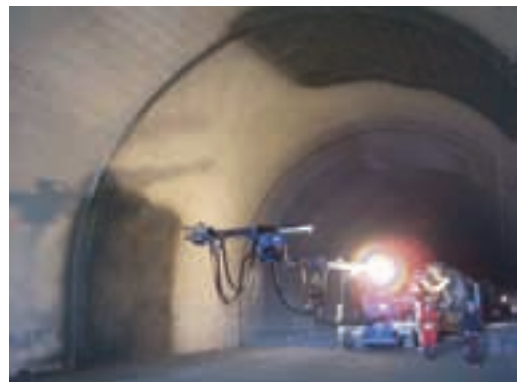
Figur 6. Utførelse av sprøytebetongdekk sjikt utenpå herdet Masterseal ® 345. Til venstre: normal sprøyterobot. Til høyre: digital sprøyting med presis og konstant lagtykkelse med sprøyterobot MEYCO ® ROBOJET LOGICA.
