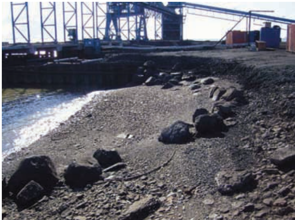
Figur 3 Erosjon ved kaianlegget på Kapp Amsterdam, Svea
