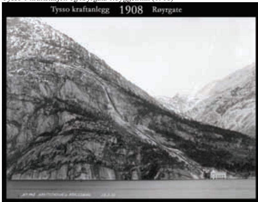
Tysso 1 kraftstasjon og røyrgata 1.byggetrinn (1908)
