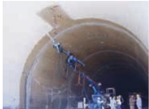
Figur 5. Applikasjon av sprøytebar vanntetningsmembran Masterseal ® 345 manuelt fra korg (vannlekkasjer er drenert ned til såle med dreiskanaler) og mekanisert med MEYCO ® ROBOJET LOGICA.
