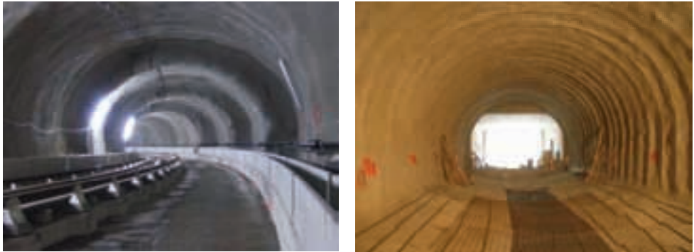
Figur 11. Tunnel de Viret, Lausanne Metro M2. Til høyre: Situasjon før arbeidene med innvendig betonkonstruksjon starter. Vanntettingsmembran Masterseal®345 utført i hele profilet, inkludert sålen. Til venstre: Ferdig tunnel med plasstøpt sålekonstruksjon, fiberarmert sprøytebetong (tykkelse 30 cm) med sprøytebar vanntettingsmembran.
