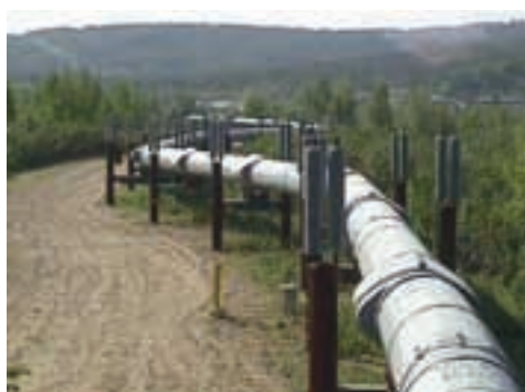
Figur 1 Vei og rørledning på permafrost (Canada). Veien har fått store skader, mens permafrosten under rørledningen holdes stabil ved hjelp av kondensatorer
