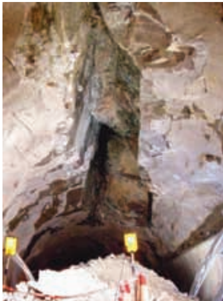
Figur 2. Detalj fra raset i Hanekleivtunnelen. Vi ser få avrevne eller avkledde bolter. (Rapport fra undersøkelsesgruppen, februar 2007)
