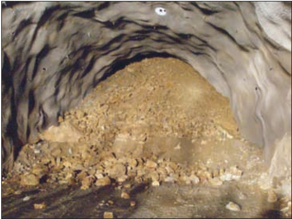
Figur 5: Ras på stuff (pr. 1634) den 20.03.07. Bildet er tatt dagen etter at raset begynte.
