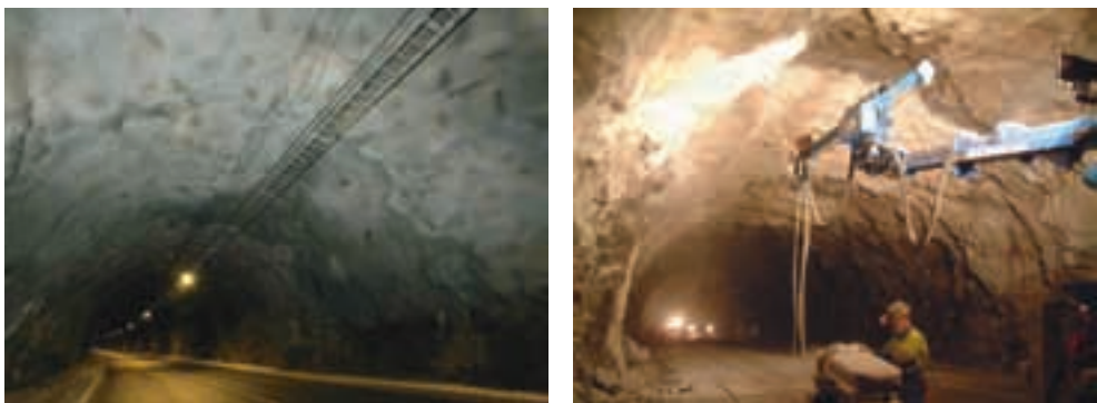
Figur 9. Nordøytunnelen Færøyene. Ferdig vannsikring fra vegg til vegg med sprøytebetong i kombinasjon med sprøytebetong, og mekanisert sprøyting av vannsikringsmembran med computerscanning av overflaten. (Lamhaug et. al 2007)
