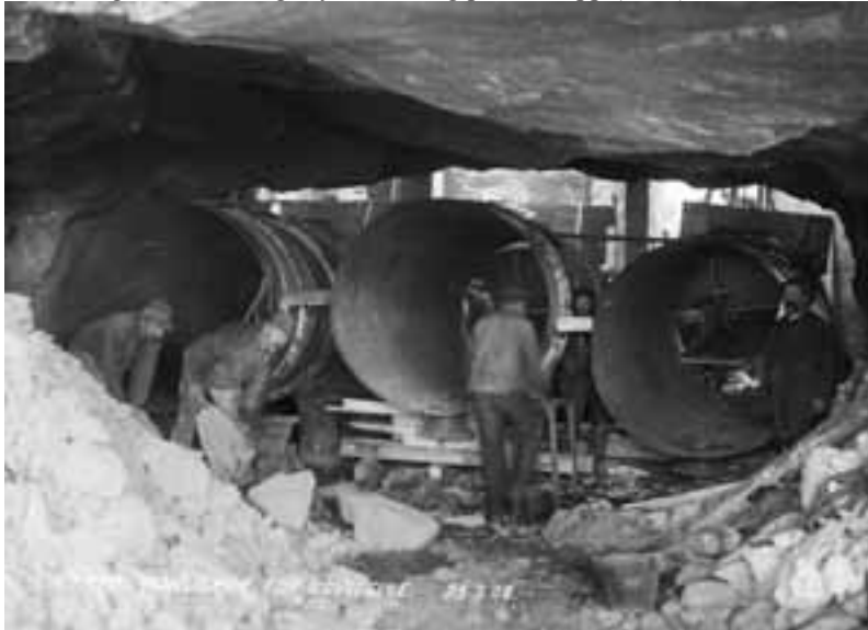
Montering av ventilar og røyra avslutning på Lilletopp (1908)
