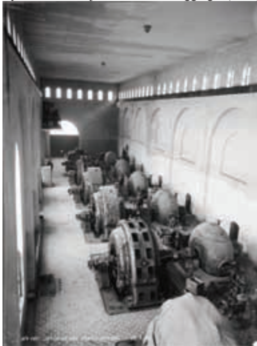
Tysso 1 kraftstasjon med 6 første aggregat (1908)
