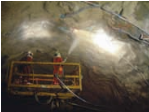
Figur 5. Applikasjon av sprøytebar vanntetningsmembran Masterseal ® 345 manuelt fra korg (vannlekkasjer er drenert ned til såle med dreiskanaler) og mekanisert med MEYCO ® ROBOJET LOGICA.
