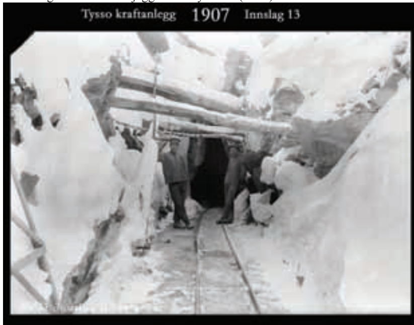
Tverrslag vassstunneil Skjeggedal – Tyssedal (1907)
