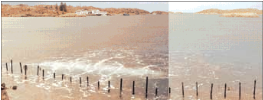
Fig.2. Smøla Konserver med laksemerder sees i bakgrunnen. Avstanden til anlegget er 500 meter. I forgrunnen sees foringsrørene som rager opp av borehullene på fjære sjø, og trykkluft gardinen foran salven.
