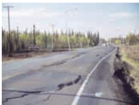
Figur 1 Vei og rørledning på permafrost (Canada). Veien har fått store skader, mens permafrosten under rørledningen holdes stabil ved hjelp av kondensatorer
