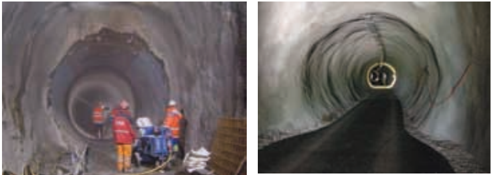
Figur 10. Giswil rømningstunnel, Sveits. Til venstre manuell applikasjon av Masterseal 345. Til høyre ferdig utført tunnel med vanntett sammensatt sprøytebetongsikring med Masterseal® 345. (Meier et. al 2005)
