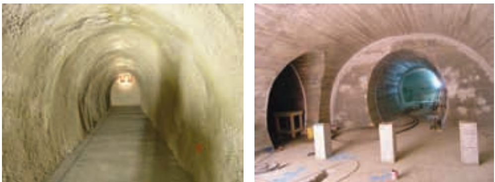
Figur 12. Praha Metro. Ferdig utførte bergrom med Masterseal 345 i kombinasjon med sprøytebetong (venstre) og plasstøpt betong (høyre).
