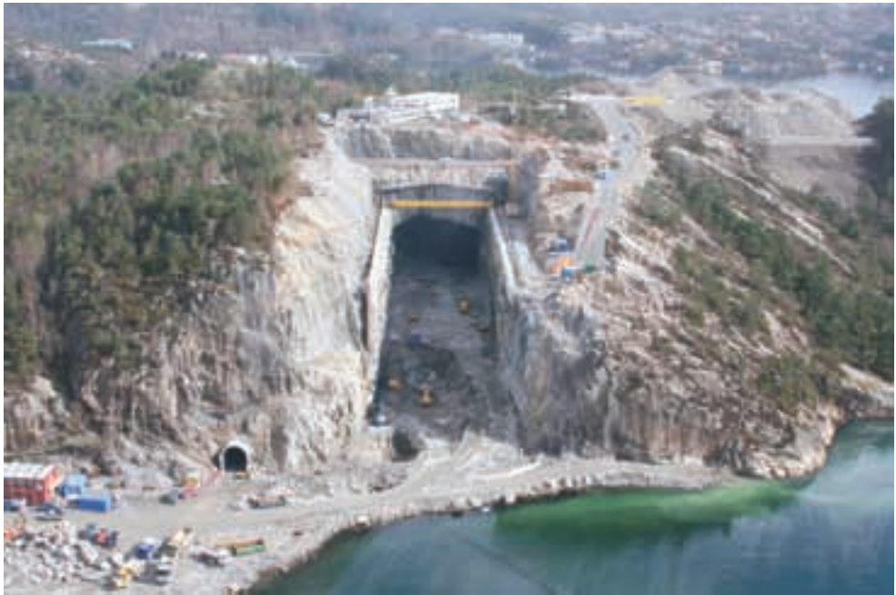
Foto 1 Oversikt utvidet tørrdokk i anleggsfasen
