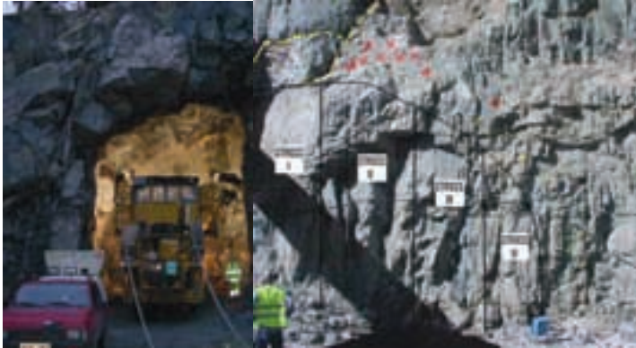
Figur 9. Borrar av pilot vid östra påslaget samt strossmarkering.
