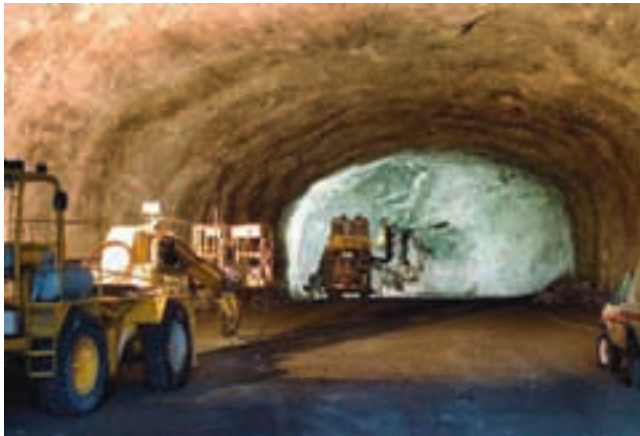
Figur 11. Full sektion med mittpilot och stross (foto Mikael Ullén)
