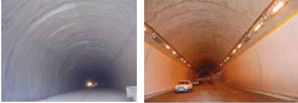
Figur 14. Chekka tunnel, Libanon. Til venstre: ferdig utført dekkjikt med fiberarmert sprøytebetong. Til høyre: ferdig rehabilitert tunnel med trafikk
