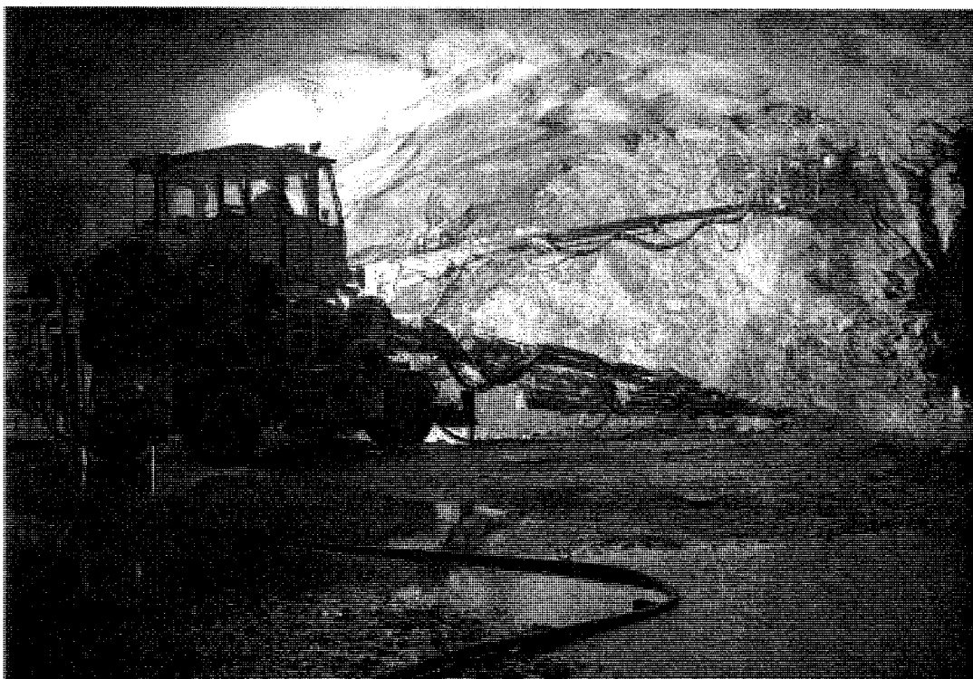
Figur 11 Titan SSE strenglading av sidecross i toppstollen for Hall 2.
