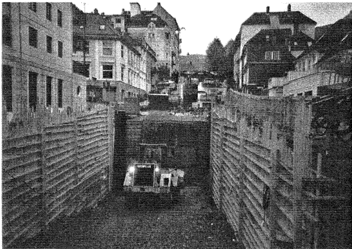
Figur 3. Forberedelser til å sprengne den første tunnelsalven i Vestre Muralmenningen.
