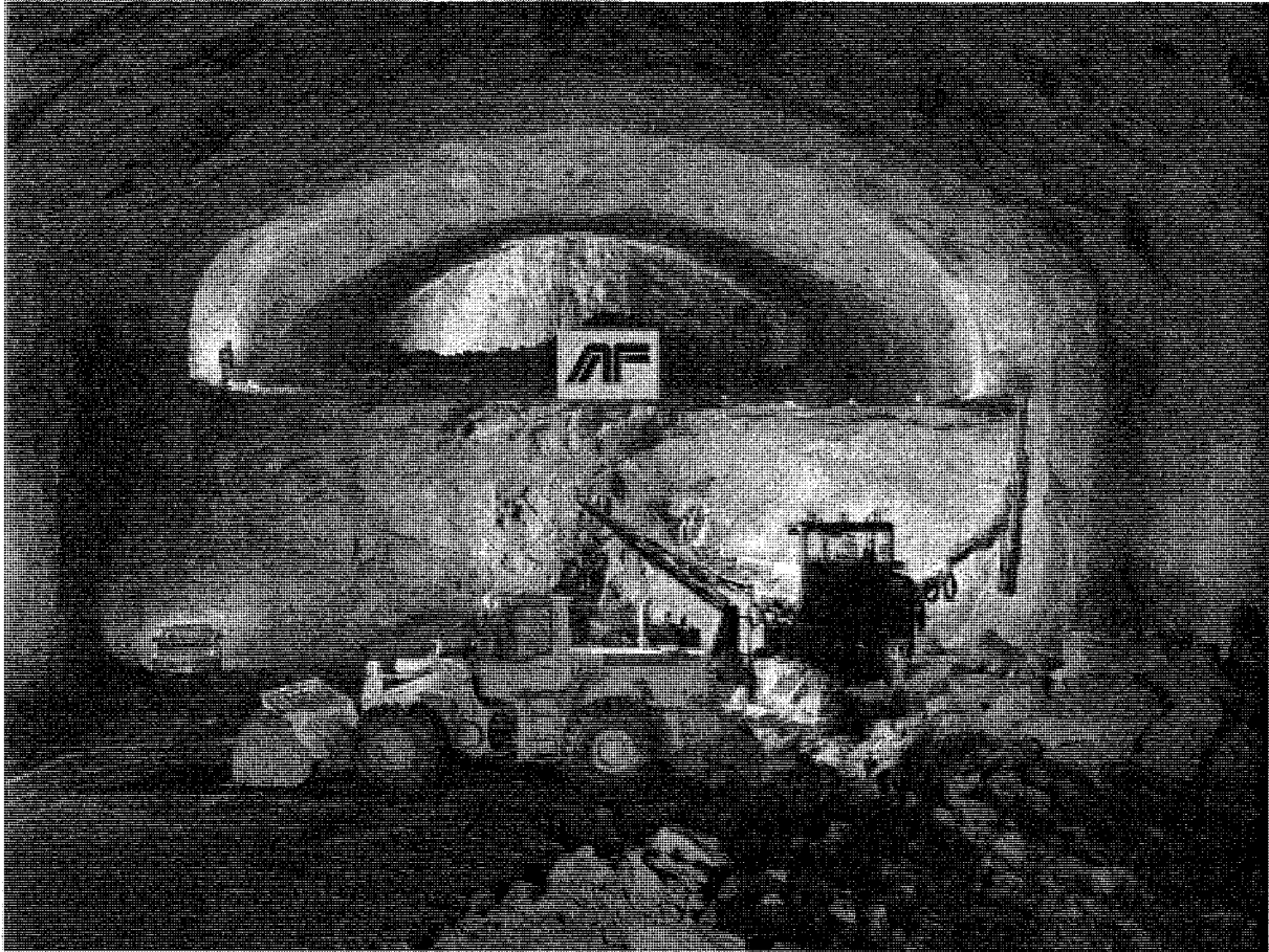
Fig. 11.5 Driving av bunnstrossen, takskiven er ferdig utsprengt og sikret. Fotograf: C F Wesenberg
