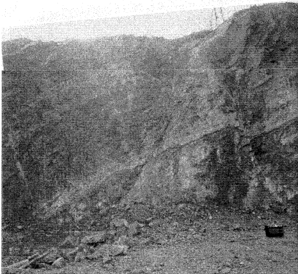
Fjellmassivet var også gjennomsett av enkelte få markante jordfyleslepper, Disse løp skrått inn i stuffen. Bildet viser det eneste området i skjæringsveggene rundt byggegropen hvor undertegnede kunne registrere at det hadde rast ut en kile ved en sleppe.
