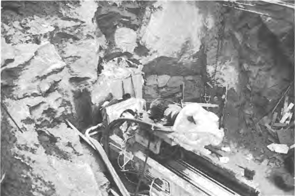
Fig. 6-3. Maskinen ble flyttet for boring av pilothull nr. 2.
