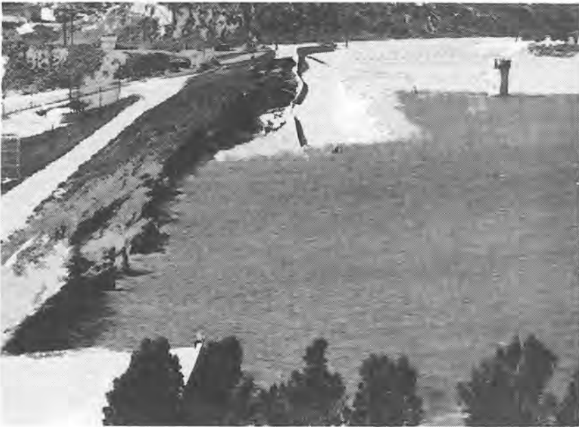
Fig. 19-17. Utglidning av nedre San Fernando dammen i 1971.
