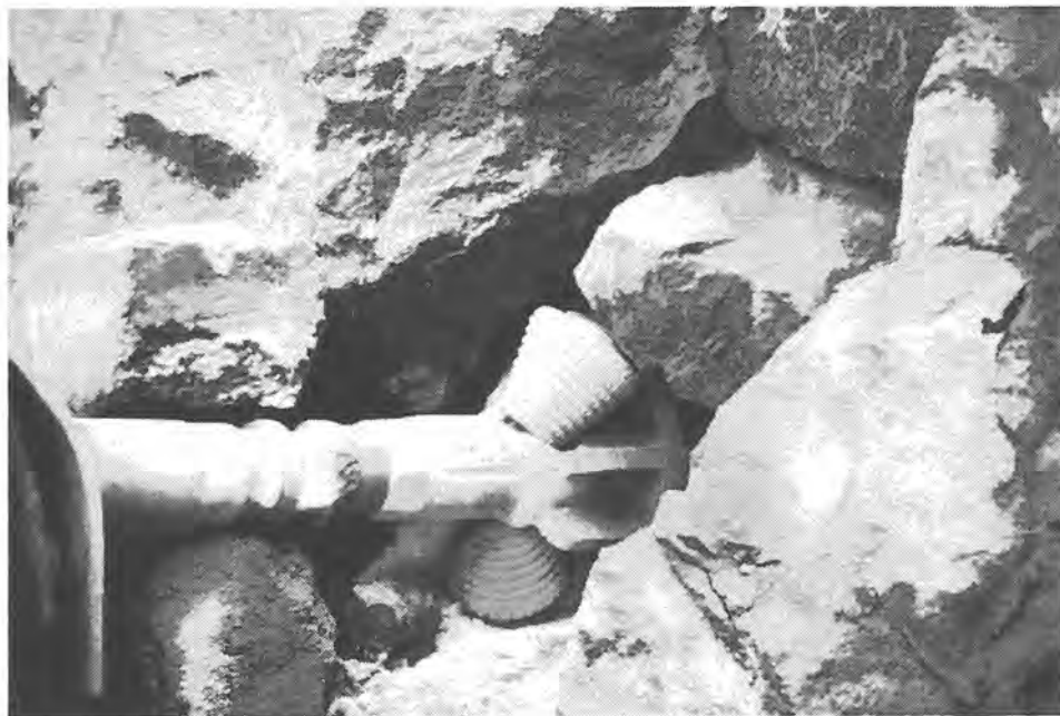
Fig. 6-5. Slutten på opprømmingen. Blokk på venstre side har løsnet.
