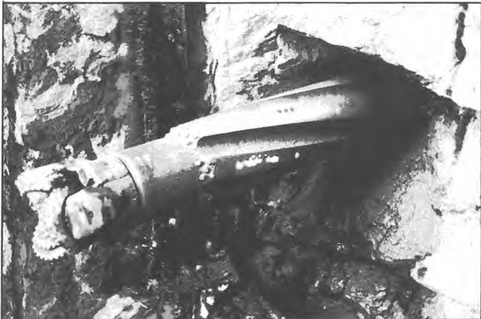
Fig. 6-2. Gjennom boring av pilothullet.
